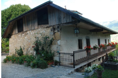
Vue d'ensemble. Phot. Thierry Monnet IVR84_20207400469NUCA
