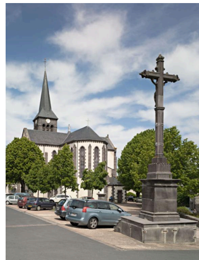
Vue générale du chevet. Phot. Jean-Michel Périn IVR83_20146300319NUC4A
