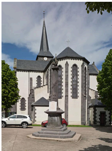
Vue générale du chevet. Phot. Jean-Michel Périn IVR83_20146300317NUC4A
