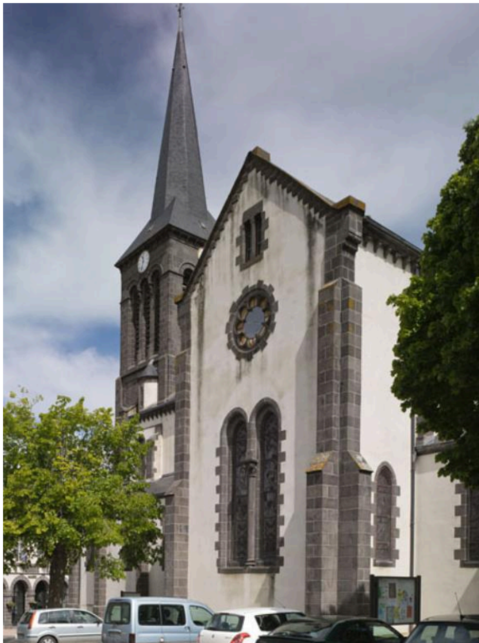
Vue générale transept sud.
