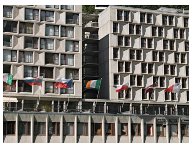
L'escalier entre la résidence Cassiopée et l'hôtel les Lindars ; détail des baies et des panneaux de ciment moulé de la façade principale Phot. Eric Dessert IVR82_20097400376NUCA
