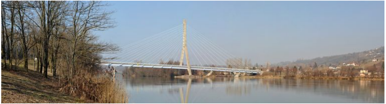
Vue panoramique, face aval (depuis la rive droite)
