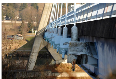
Travée gauche, vue partielle : ancrage des câbles, face aval (depuis la rive gauche) Phot. G. Gellert IVR82_20100100408NUCA
