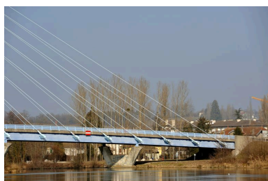
Vue partielle, travée gauche, face aval (depuis la rive droite) Phot. G. Gellert IVR82_20100100402NUCA
