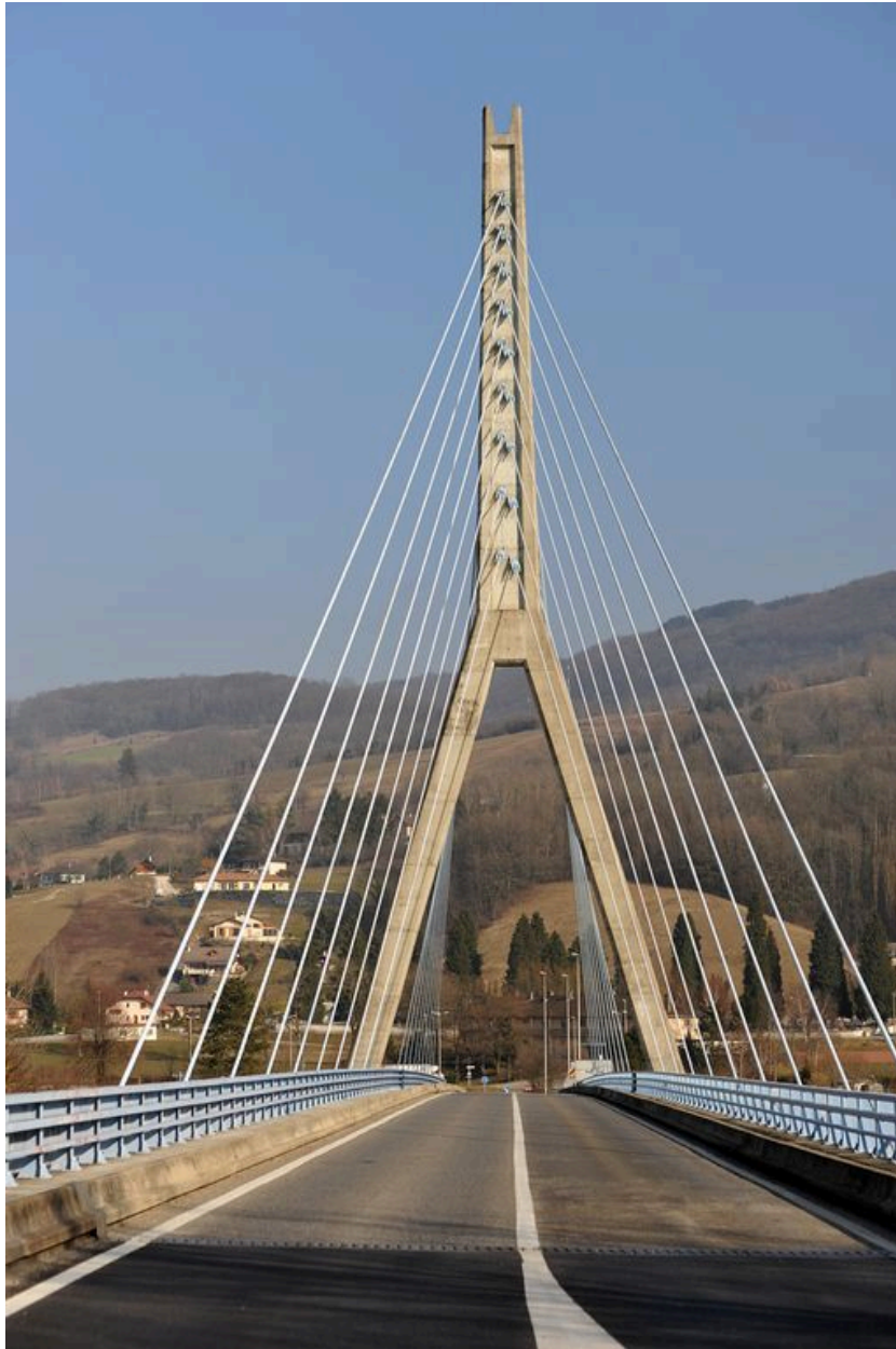
Vue générale, chaussée et pylône (depuis la rive gauche)
