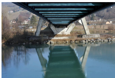
Vue du dessous du tablier, travée gauche (depuis la rive gauche) Phot. G. Gellert IVR82_20100100410NUCA
