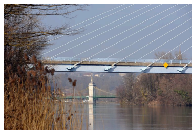
Vue partielle, travée droite, face aval (depuis la rive droite) ; en arrière-plan le pont suspendu Phot. G. Gellert IVR82_20100100401NUCA
