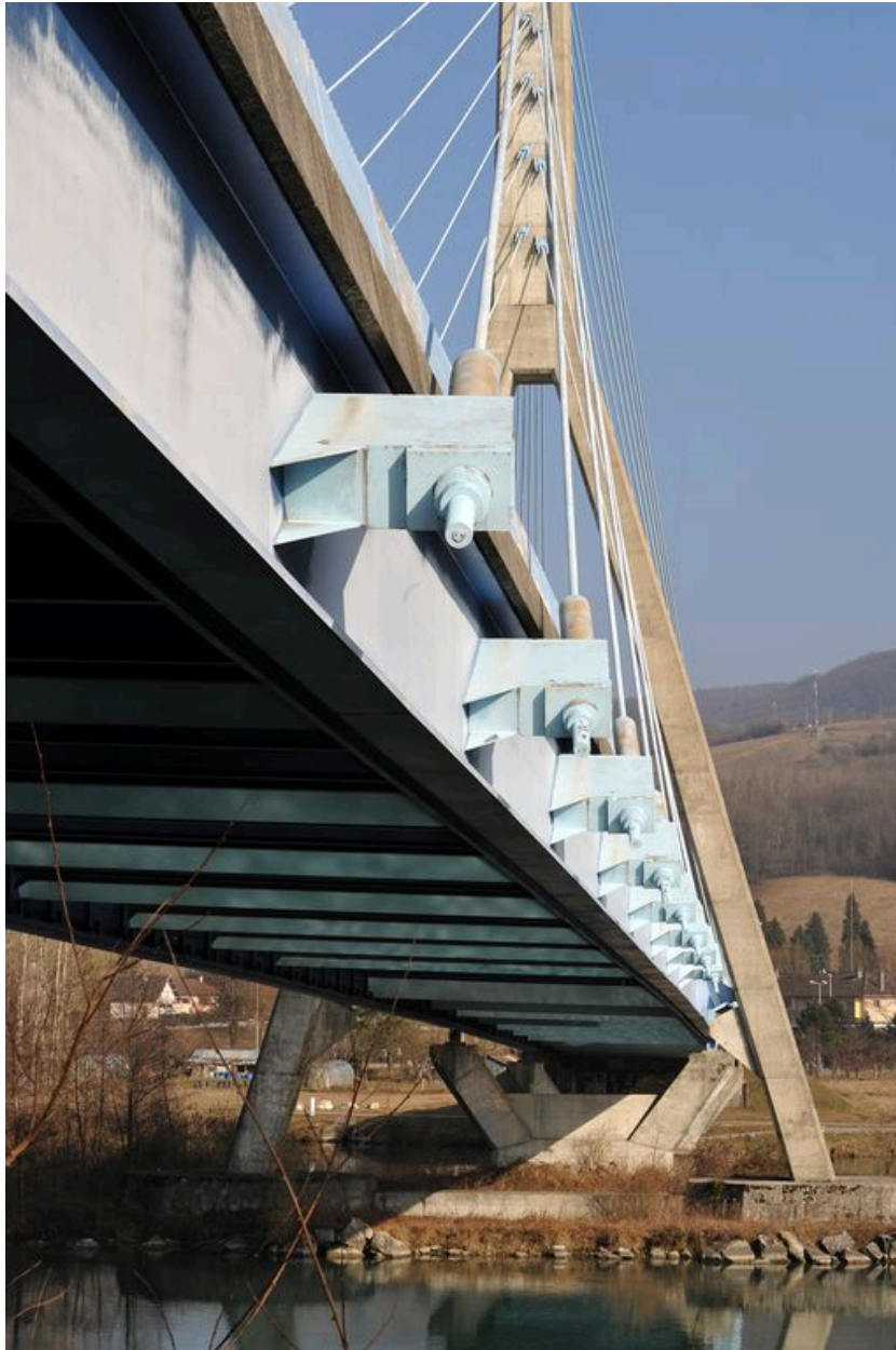
Travée gauche, vue partielle : dessous du tablier et ancrage des câbles, face amont (depuis la rive gauche)
