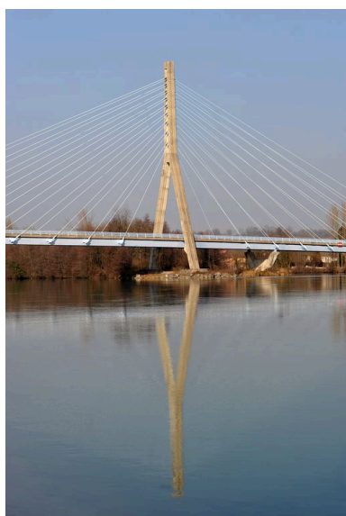
Vue partielle, pylône central, face aval (depuis la rive droite) Phot. G. Gellert IVR82_20100100406NUCA
