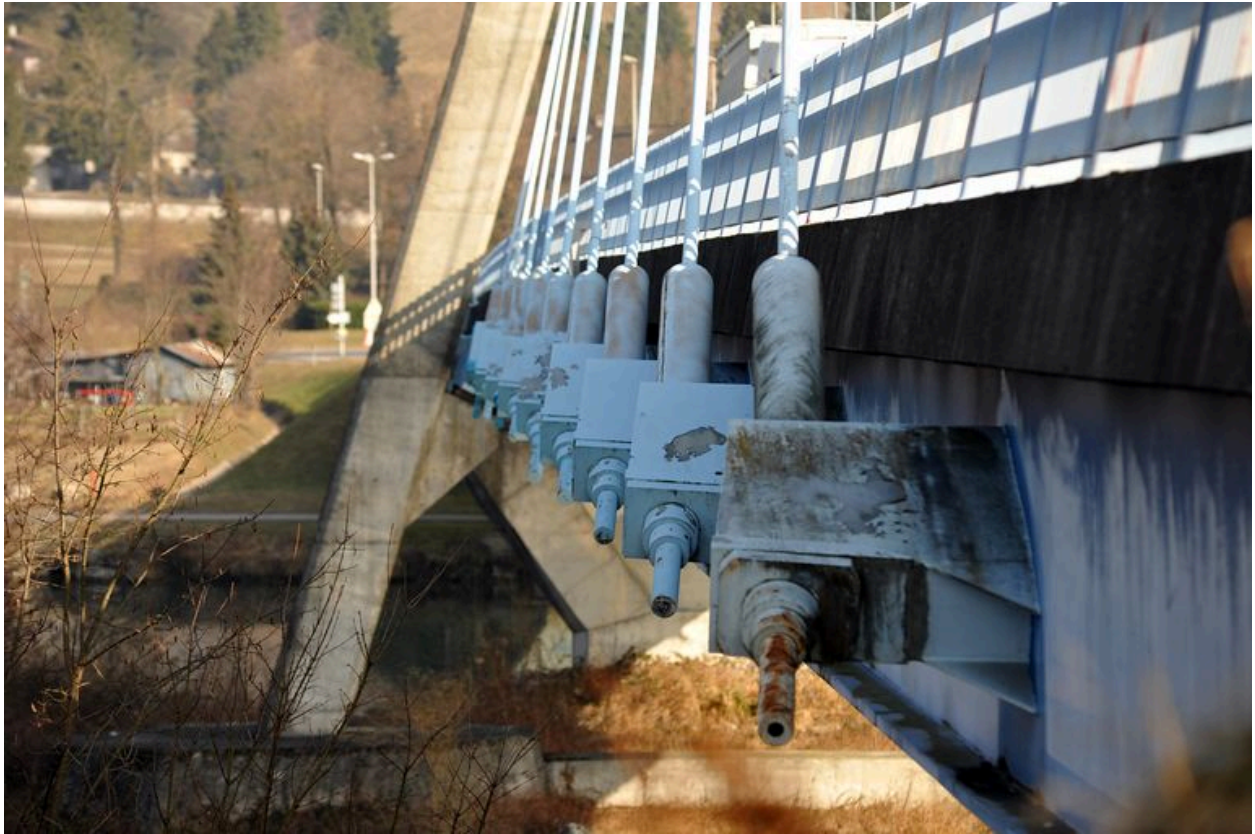
Travée gauche, vue partielle : ancrage des câbles, face aval (depuis la rive gauche)
