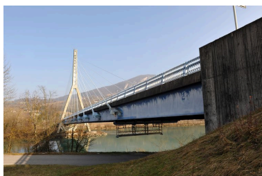
Vue partielle, de côté, culée et travée gauche, face aval (depuis la rive gauche) Phot. G. Gellert IVR82_20100100403NUCA
