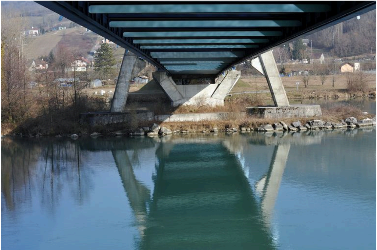
Vue du dessous du tablier, travée gauche (depuis la rive gauche)
