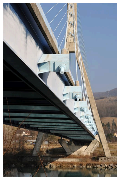
Travée gauche, vue partielle : dessous du tablier et ancrage des câbles, face amont (depuis la rive gauche) Phot. G. Gellert IVR82_20100100409NUCA
