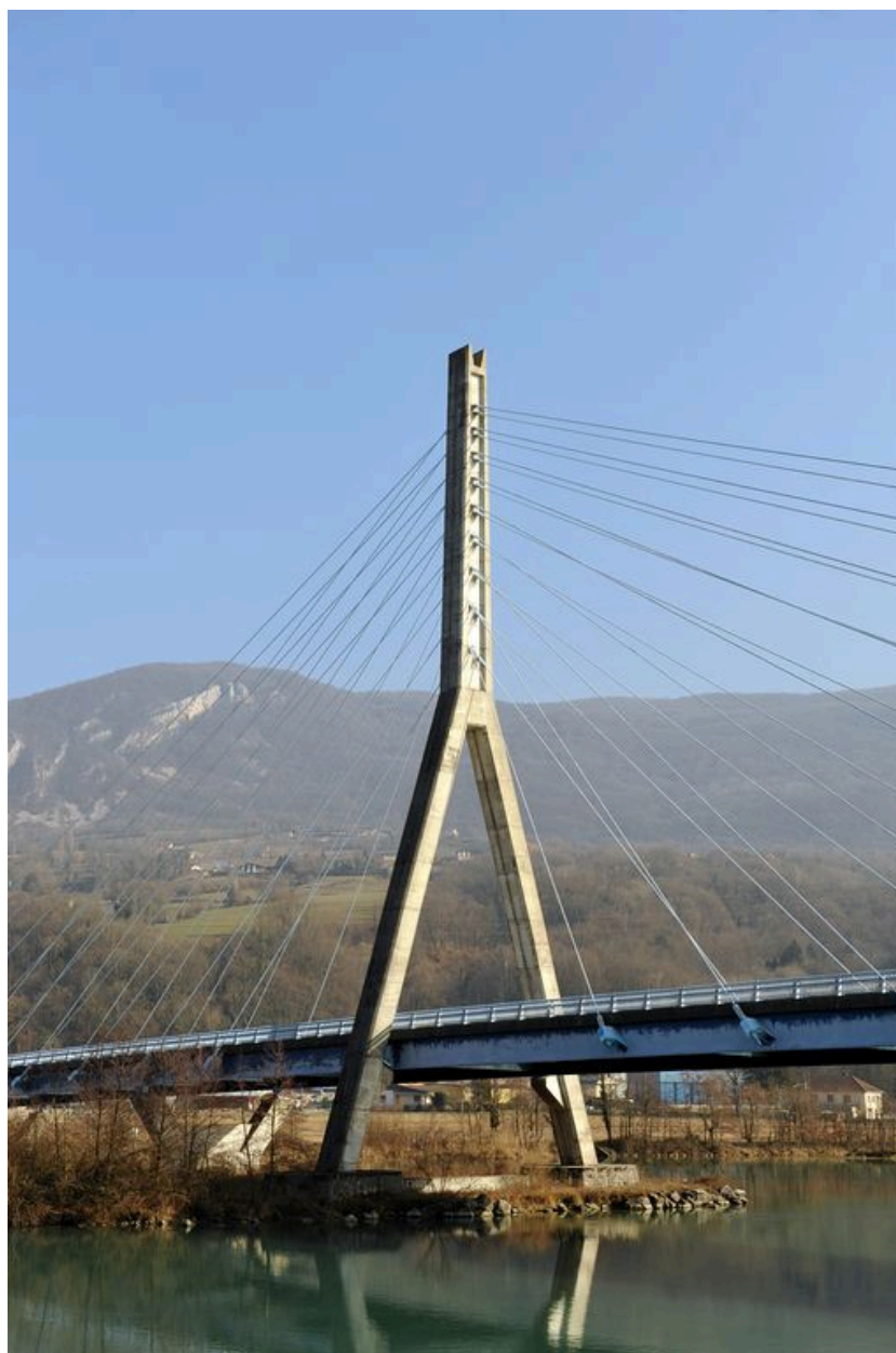
Vue partielle, pylône central, face amont (depuis la rive droite)
