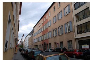
Elévation rue de la Claire : vue de situation Phot. Véronique Belle IVR82_20096900778NUCA
