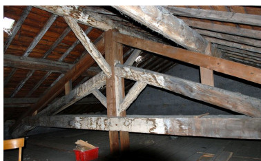
Corps de bâtiment principal : charpente, détail d'une ferme Phot. Véronique Belle IVR82_20096900799NUCA
