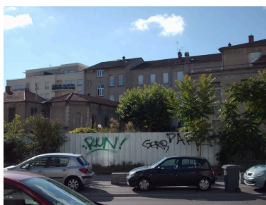
Elévations rue du 24-mars-1852 : vue de situation Phot. Véronique Belle IVR82_20116902463NUCA
