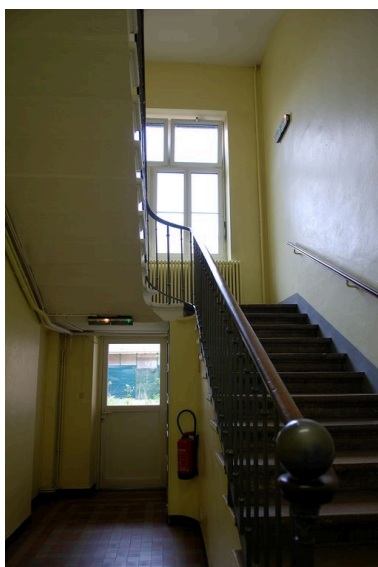
Corps de bâtiment principal : escalier nord-est Phot. Véronique Belle IVR82_20096900792NUCA
