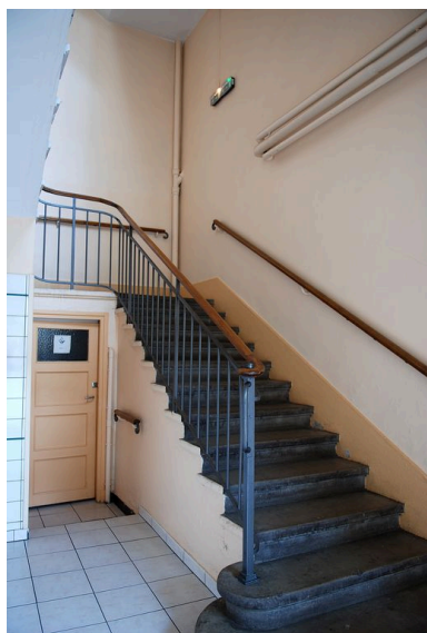
Corps de bâtiment principal : escalier sud-ouest Phot. Véronique Belle IVR82_20096900794NUCA
