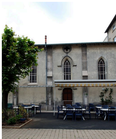
Chapelle : élévation latérale, détail d'une travée Phot. Véronique Belle IVR82_20096900788NUCA
