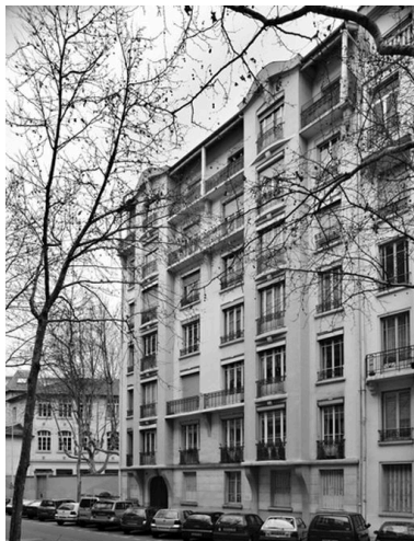
Vue d'ensemble depuis le sud-est Phot. Eric Dessert IVR82_20076901316NUC
