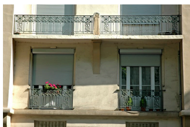
Détail de l'étage de balcon Phot. Maryannick Chalabi IVR82_20066903103NUCA
