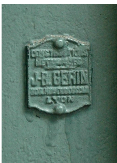
Marque du fabricant de la porte d'entrée Phot. Maryannick Chalabi IVR82_20066903113NUCA
