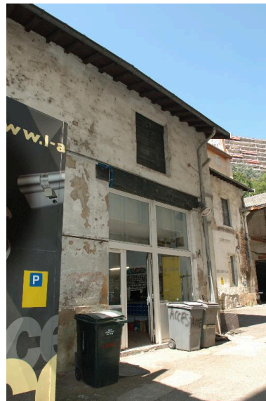
Vue des remises situées au sud-ouest. Phot. Catherine Guillot IVR82_20136900204NUC1A
