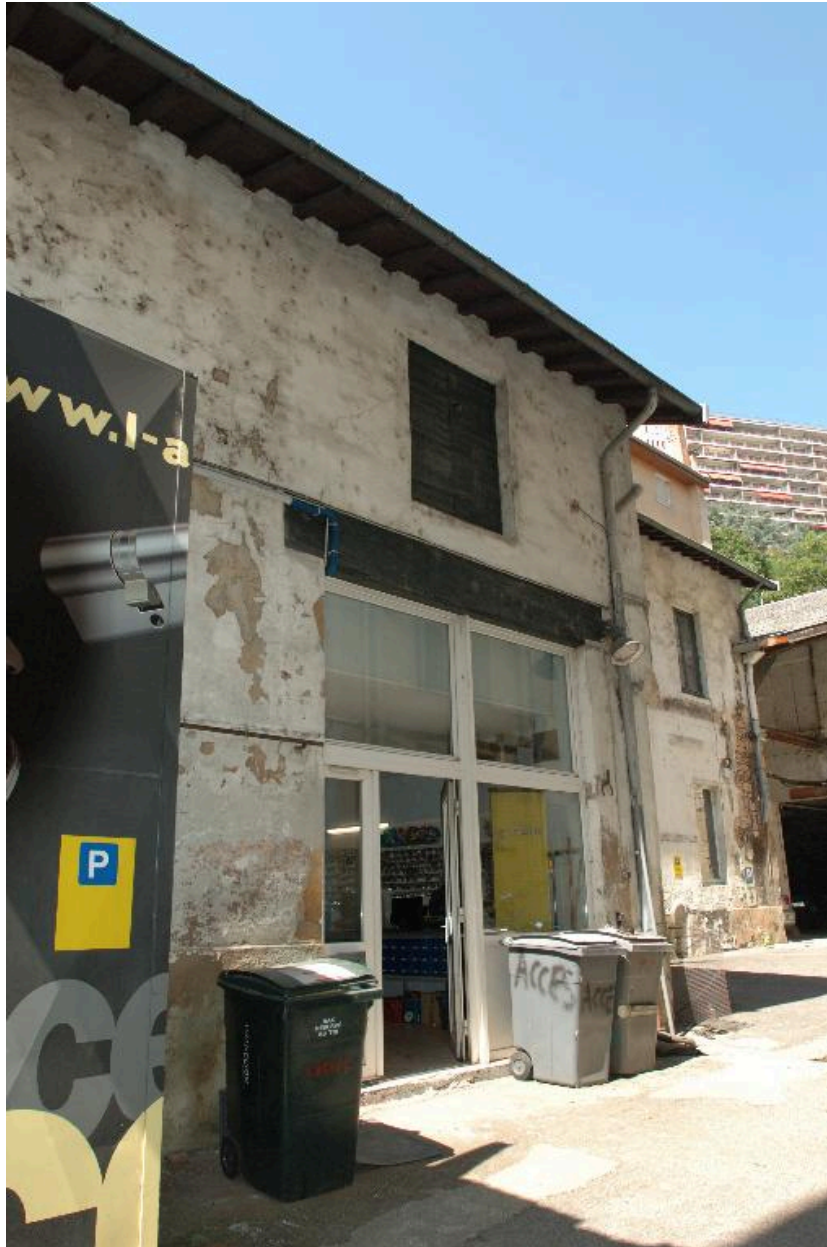
Vue des remises situées au sud-ouest.
