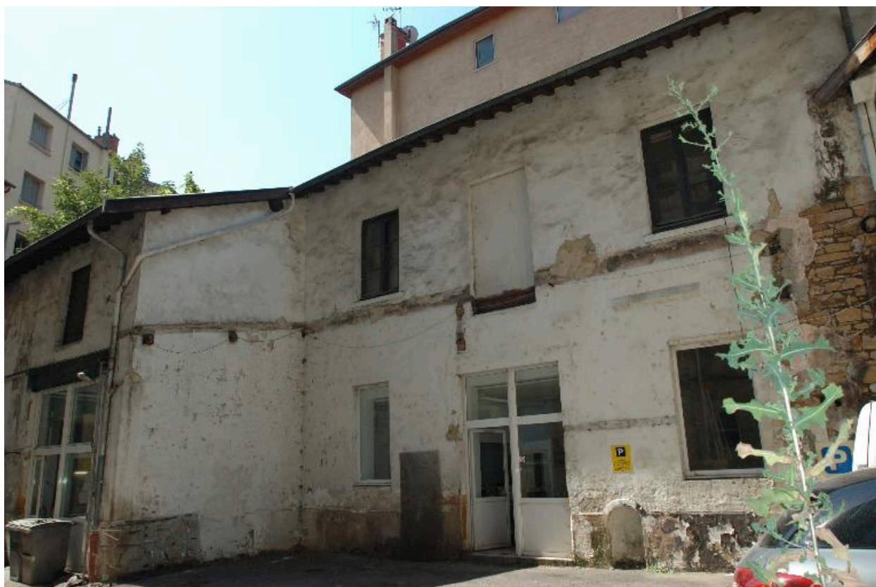
Vue des bâtiment situés au sud-ouest.
