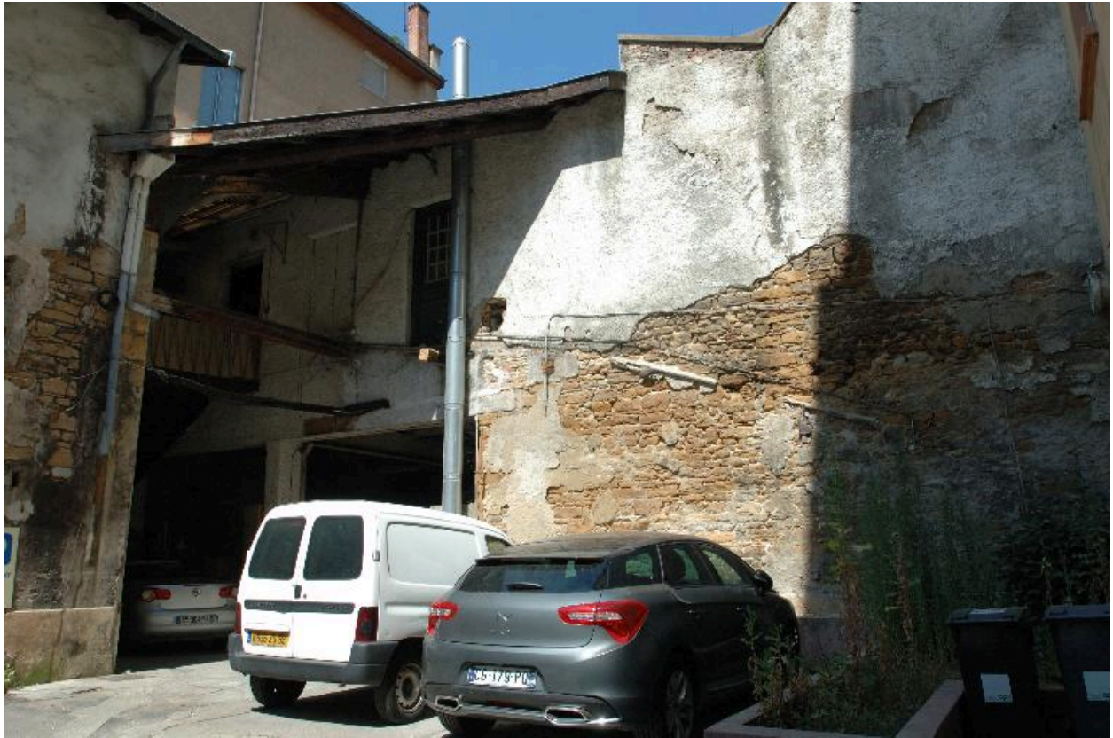
Vue des bâtiment situés en fond de cour, au nord.
