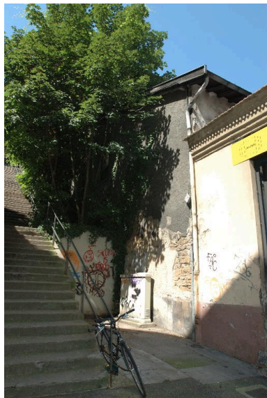
Détail de l'entrée, au pied de la montée. Phot. Catherine Guillot IVR82_20136900201NUCA
