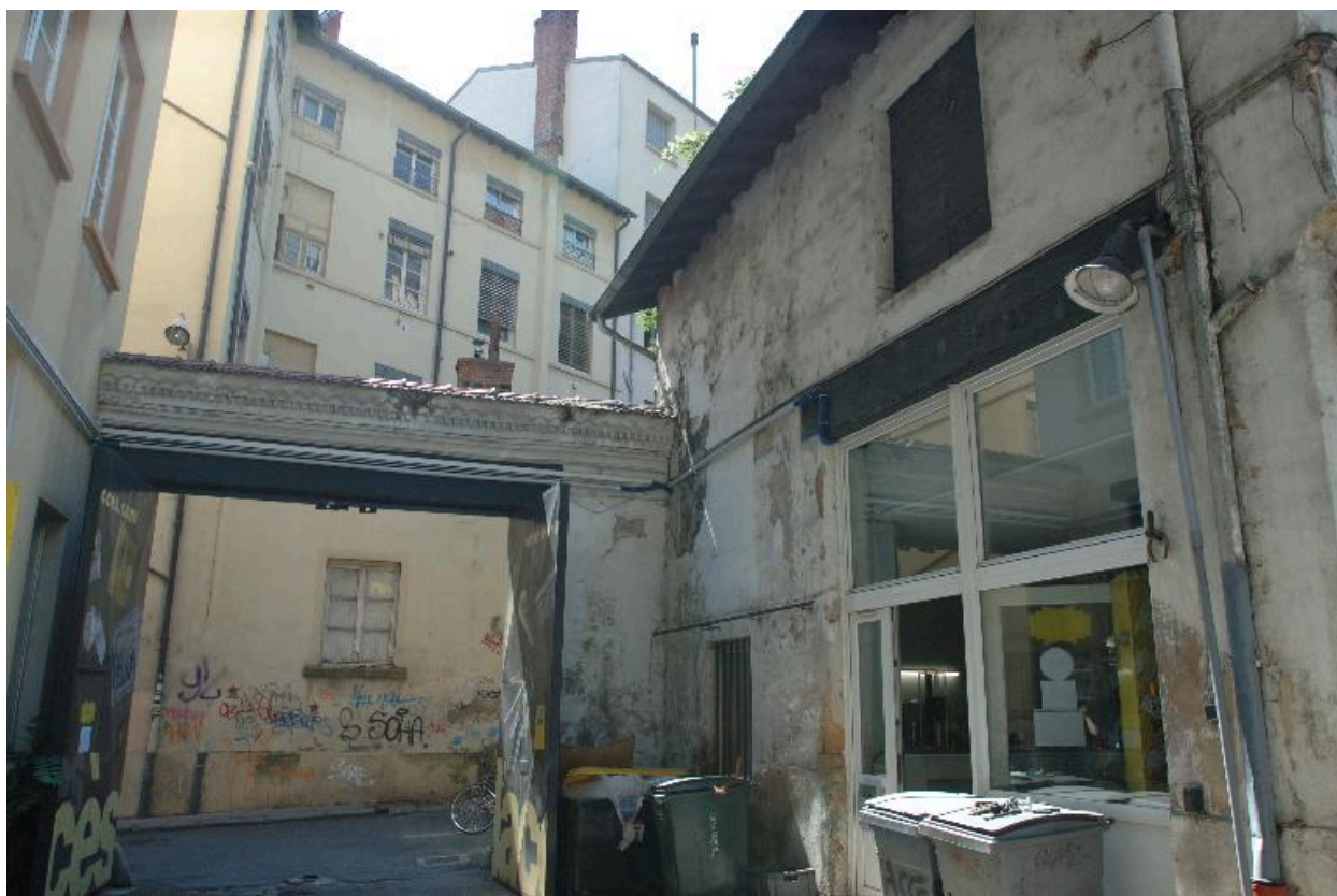
Vue de l'entrée et des remises situées au sud-ouest (ancien fenil ?).
