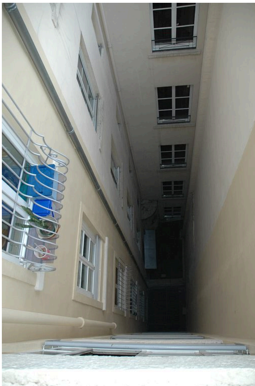
La cour depuis l'escalier 35 rue de Brest
