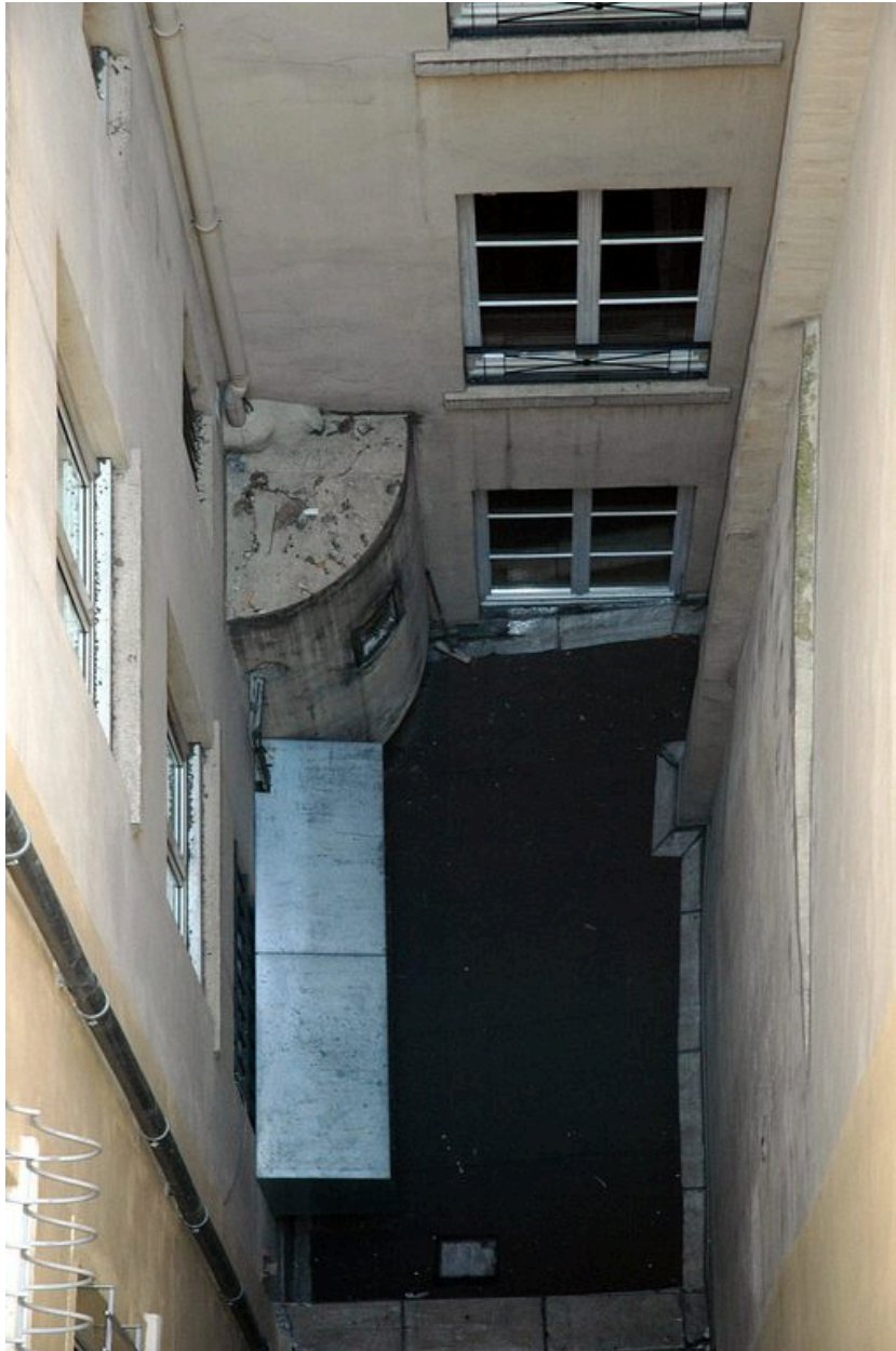
Partie inférieure de la cour avec la loge de concierge
