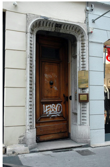
La porte piétonne Phot. Véronique Belle IVR82_20086902054NUCA
