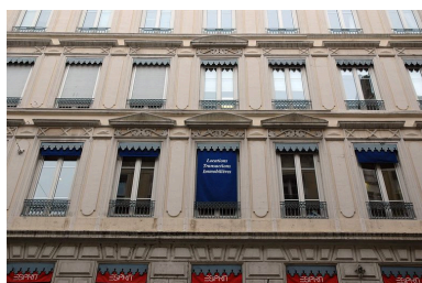
Elévation rue de Brest : détail des travées axiales des étages nobles Phot. Véronique Belle IVR82_20086902055NUCA
