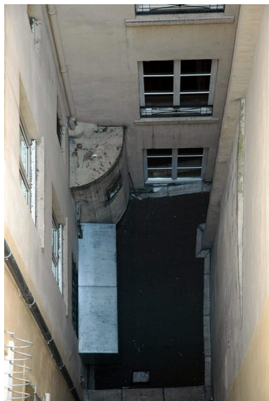
Partie inférieure de la cour avec la loge de concierge Phot. Véronique Belle IVR82_20086902928NUCA
