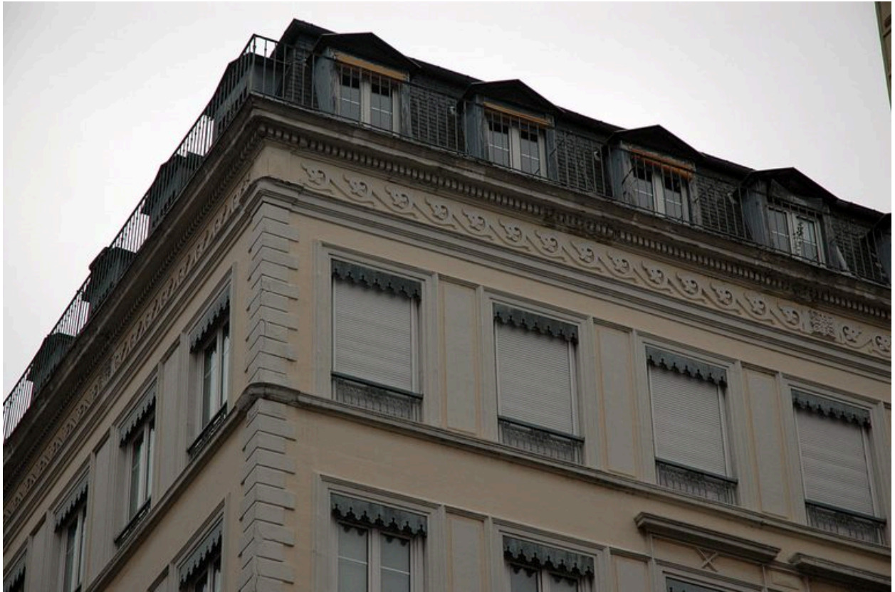
Détail de la corniche
