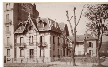
La villa et le chalet Darphin, vers 1898 Repro. François Fouger IVR82_20127300827NUCB
