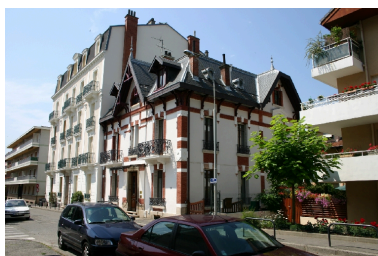
Vue de trois quart droit Phot. François Fouger IVR82_20067300622NUCA
