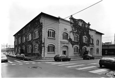
Vue générale nord-ouest Phot. Jean-Marie Refflé IVR82_20026905026V
