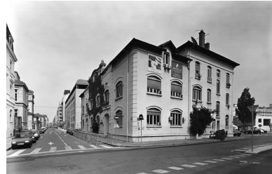
Vue sud Phot. Jean-Marie Refflé IVR82_20026905028V
