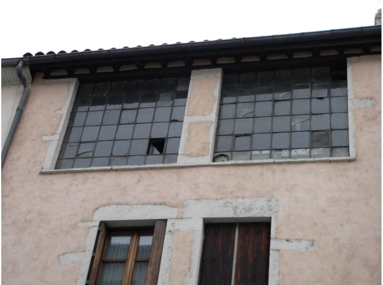
Baies du troisième étage
