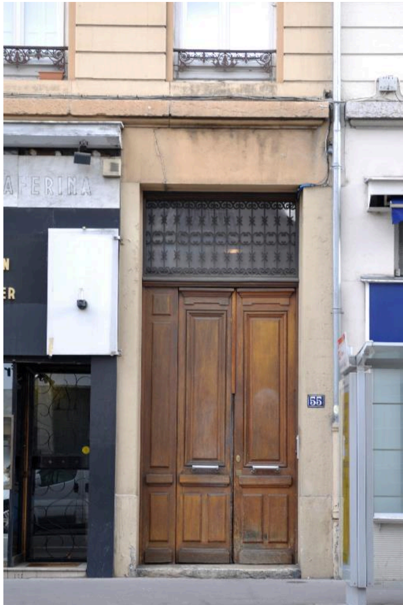
Vue rapprochée de la porte bâtarde
