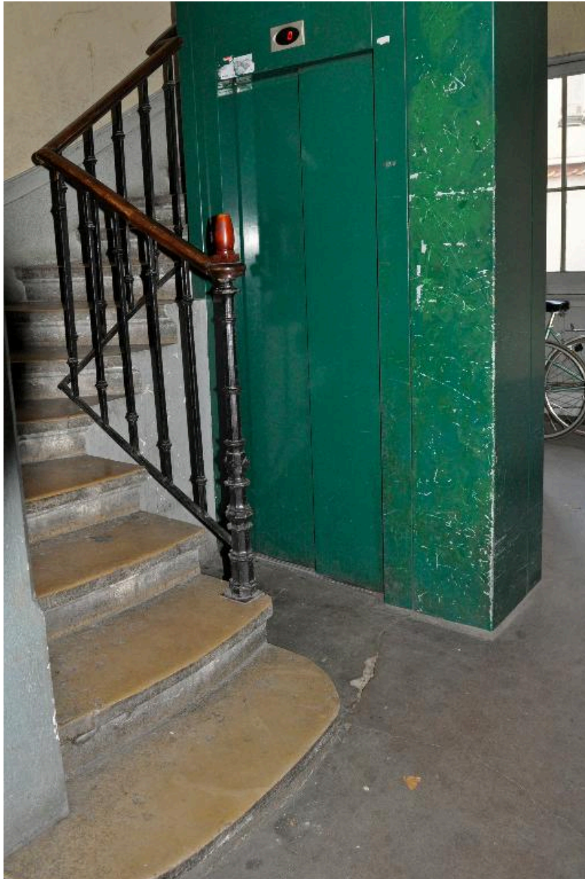
Vue intérieure : le départ de l'escalier (modifié par l'intégration de l'ascenseur ?)
