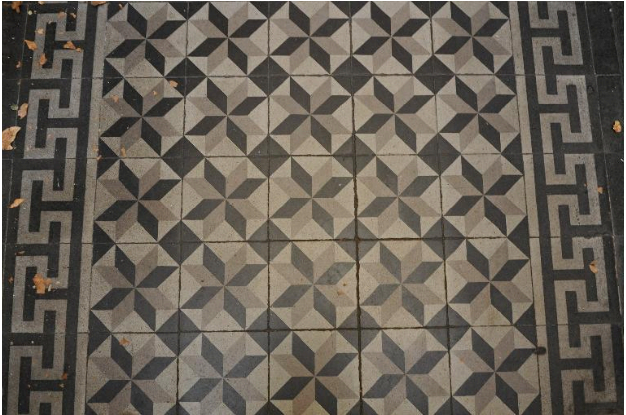
Vue intérieure, détail du pavement de l'allée
