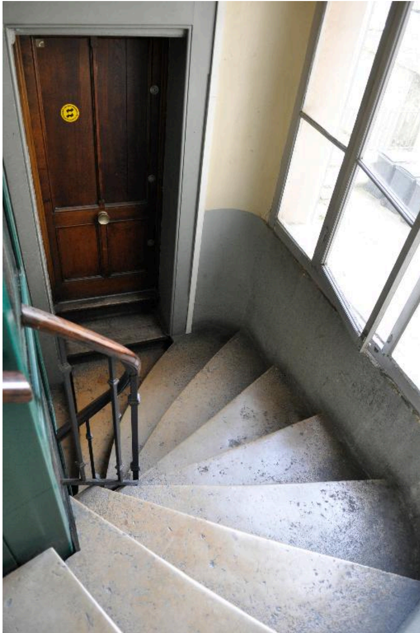
Vue intérieure : porte de log, dans la première volée d'escalier
