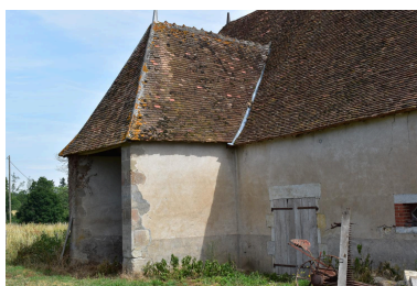
Détail du bâtiment primitif de la grange. Phot. Maryse Durin-Tercelin IVR84_20240300068NUCA
