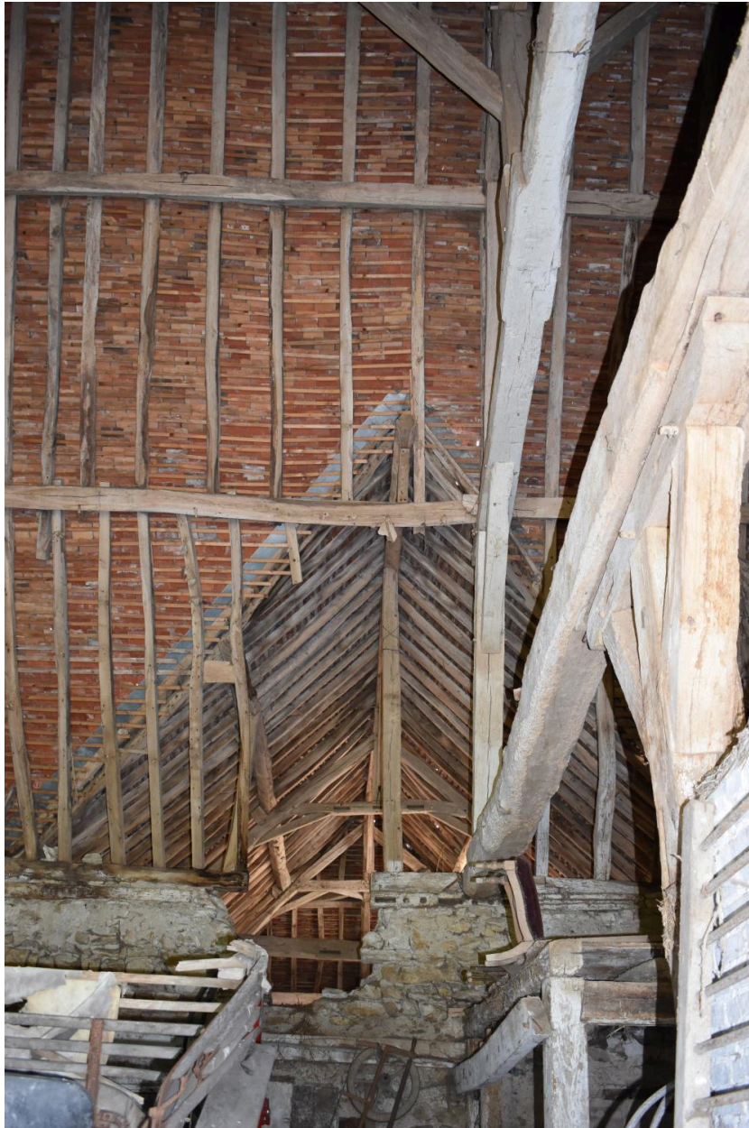
Charpente, vue en direction de la croupe nord-est.
