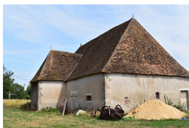
Bâtiment primitif de la grange étable à auvent, vue du sud-est. Phot. Maryse Durin-Tercelin IVR84_20240300069NUCA
