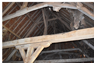
Charpente, vue en direction de la croupe sud-est. Phot. Maryse Durin-Tercelin IVR84_20240300073NUCA
