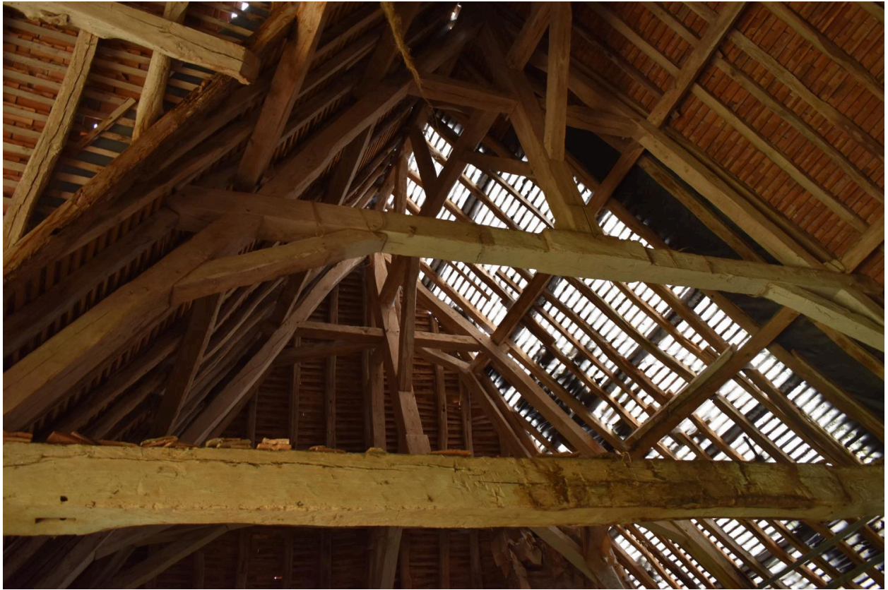
Charpente, prise en direction de la croupe du nord-ouest.
