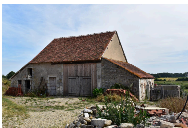
Bâtiment des écuries construit au nord-est au 19e siècle ou au début du 20e siècle. Phot. Maryse Durin-Tercelin IVR84_20240300075NUCA
