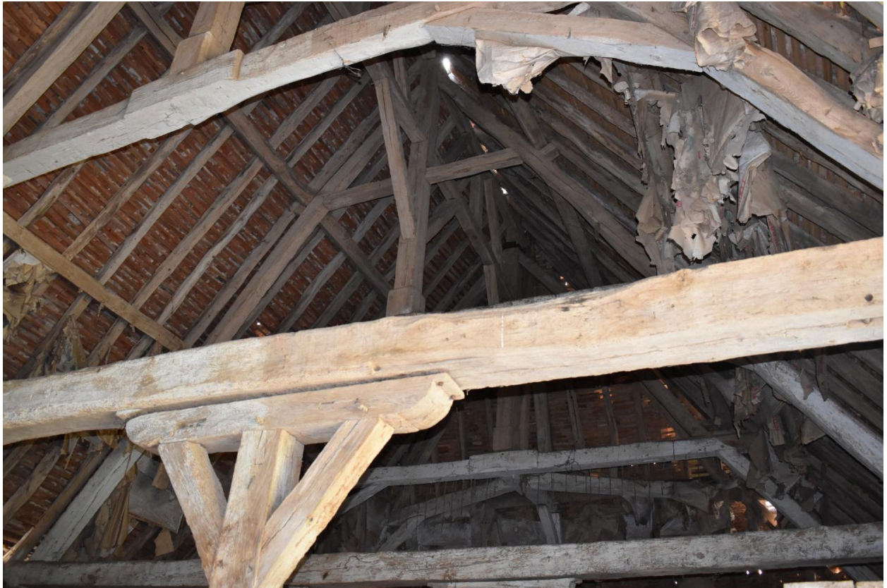
Charpente, vue en direction de la croupe sud-est.
