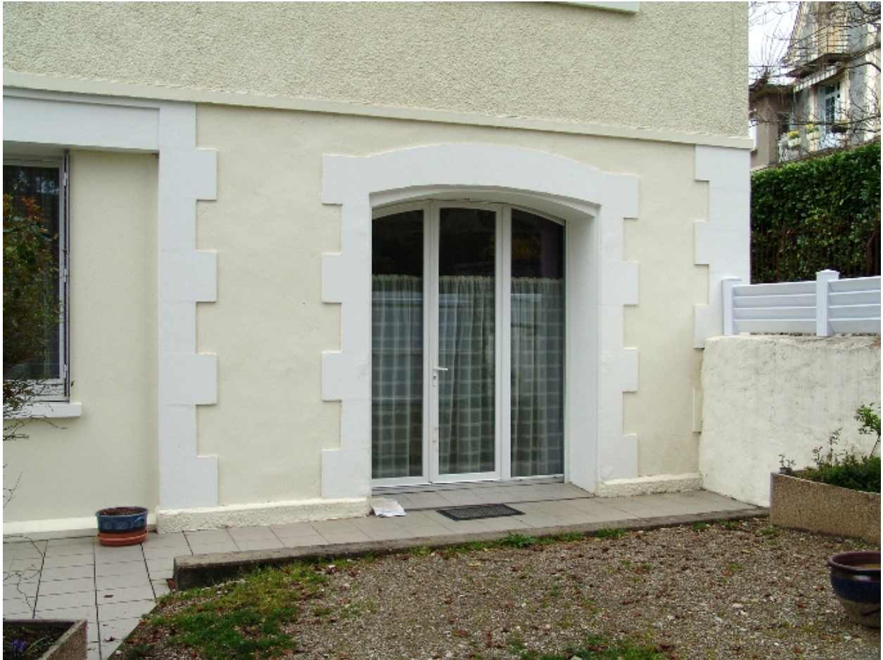
Détail de la façade
