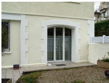
Détail de la façade Phot. François Fouger IVR82_20077300265NUCA
