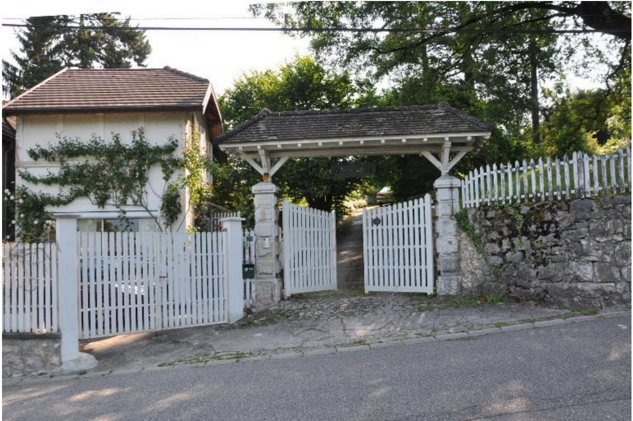
Portail et pavillon d'entrée
