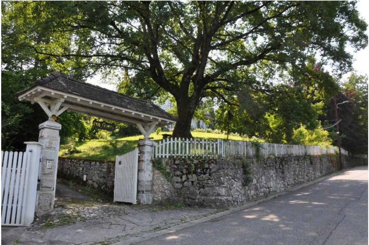
Vue d'ensemble depuis le chemin Honoré de Balzac
