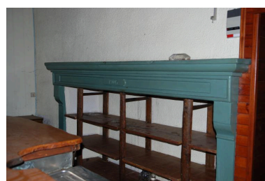
Cheminée datée 1905. Phot. Thierry Monnet IVR84_20207400811NUCA
