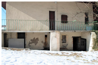
Vue partielle latérale droite Phot. Thierry Monnet IVR84_20197400150NUCA
