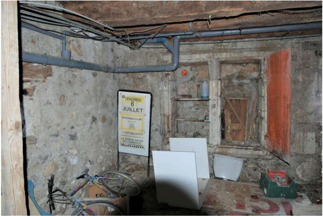
Vue d'ensemble d'un placard mural en pierre dans l'espace situé à l'étage de soubassement.
