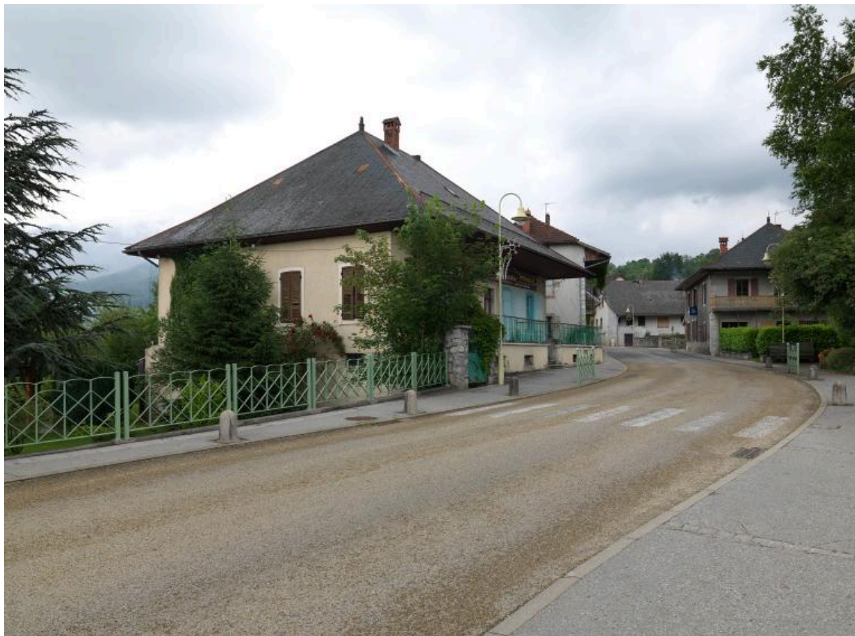
Vue d'ensemble de trois-quarts avant gauche du restaurant.
