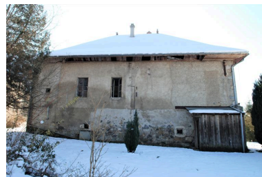
Vue d'ensemble de la façade arrière du restaurant Phot. Thierry Monnet IVR84_20197400151NUCA
