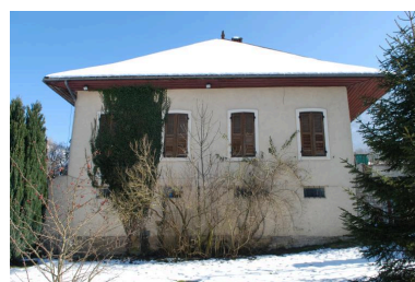
Vue d'ensemble de la partielle latérale gauche Phot. Thierry Monnet IVR84_20197400155NUCA
