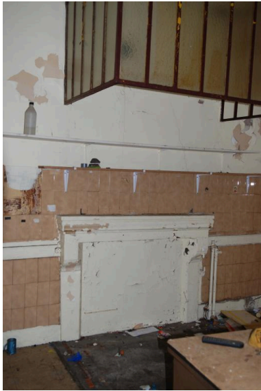
Cheminée de la cuisine. Phot. Thierry Monnet IVR84_20207400812NUCA
