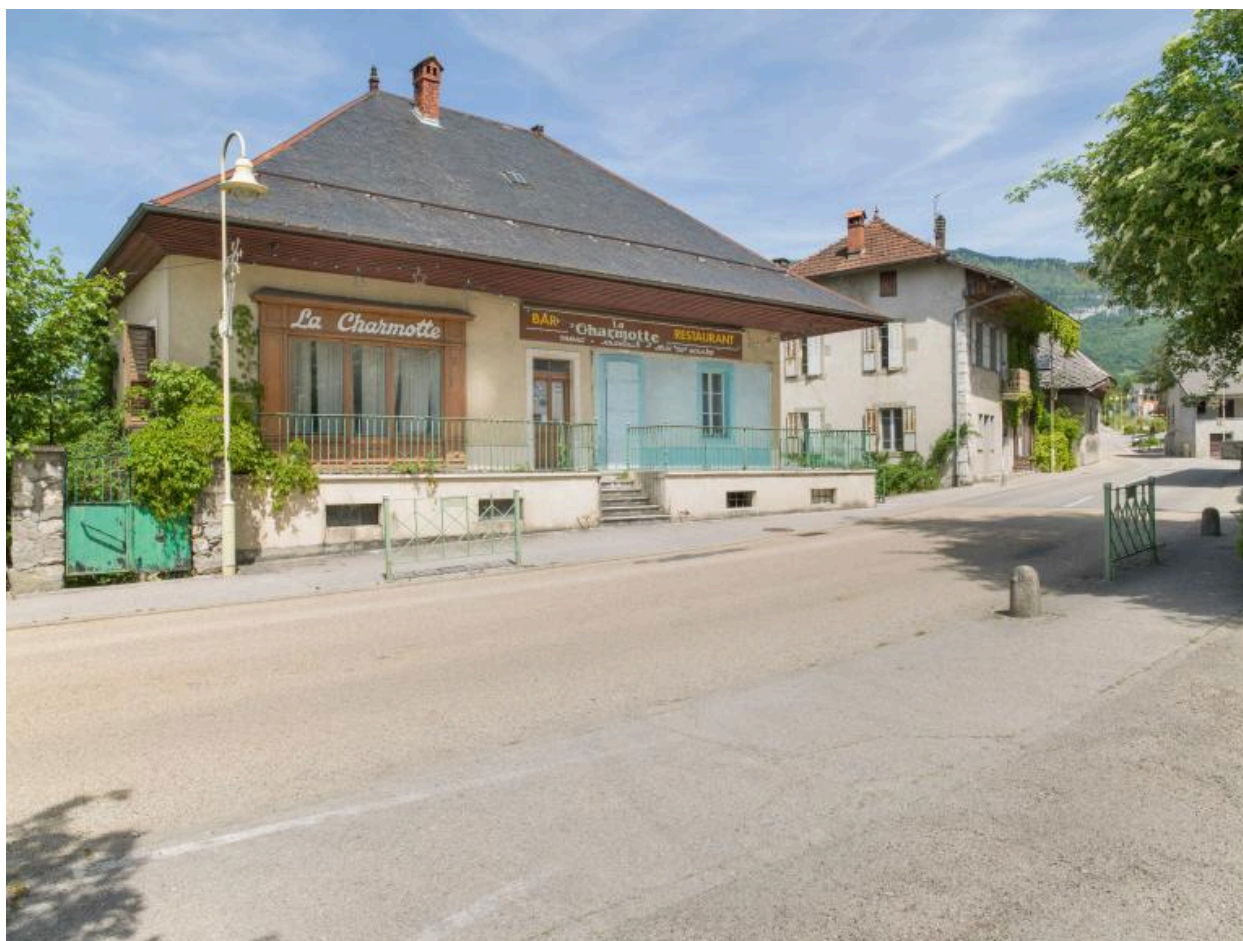
Vue d'ensemble du restaurant de trois-quarts avant gauche.
