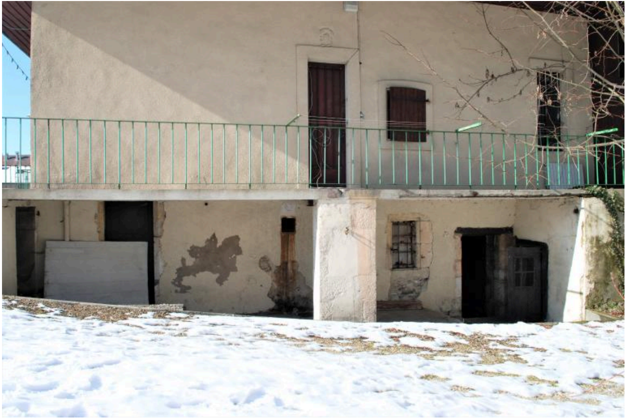
Vue partielle latérale droite
