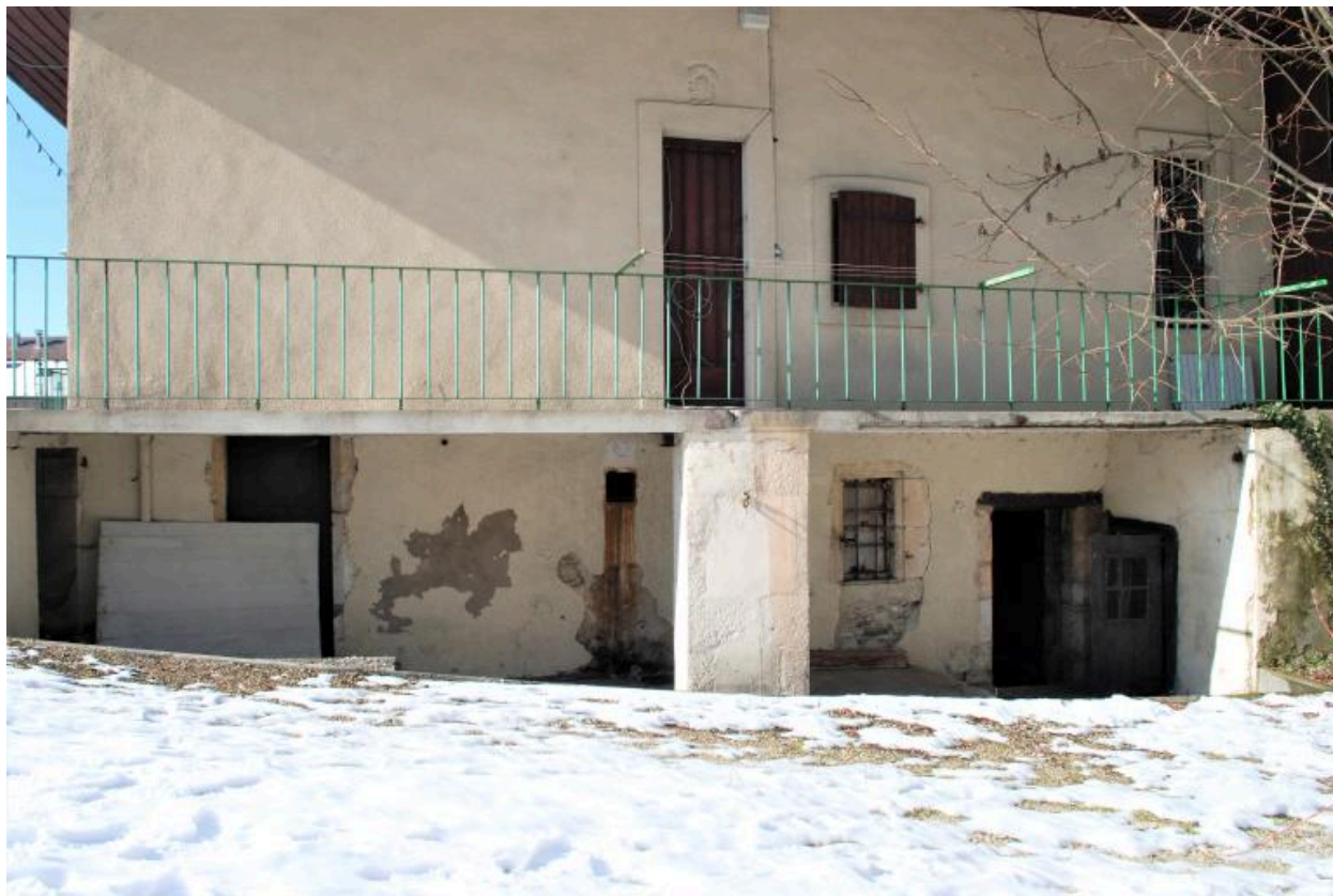
Vue partielle latérale droite
