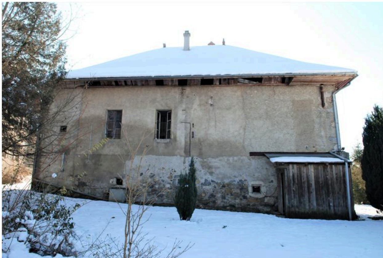
Vue d'ensemble de la façade arrière du restaurant
