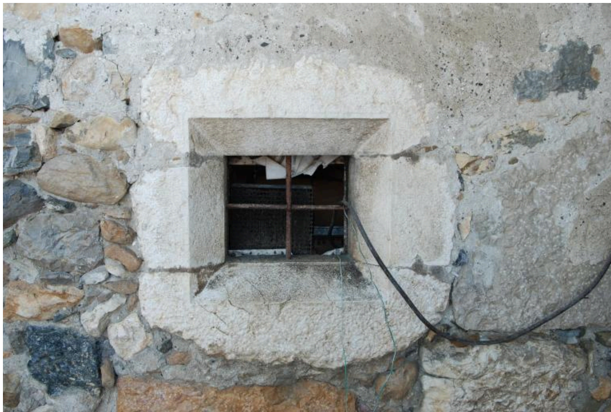
Façade arrière, détail d'un jour à encadrement chanfreiné.
