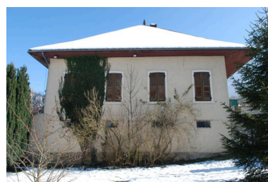
Vue d'ensemble de la partie latérale gauche Phot. Thierry Monnet IVR84_20197400155NUCA
