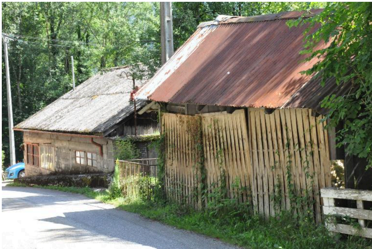
Au premier plan, le bâtiment reconstruit à la place de la scierie. Au second plan, la forge Teillier.
