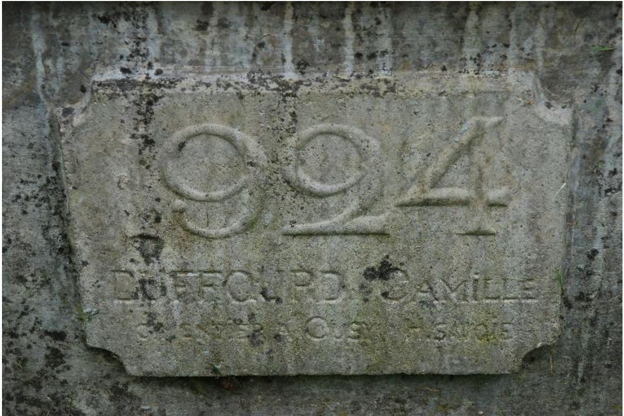
Vue d'ensemble de l'inscription portée sur le côté du bassin.
