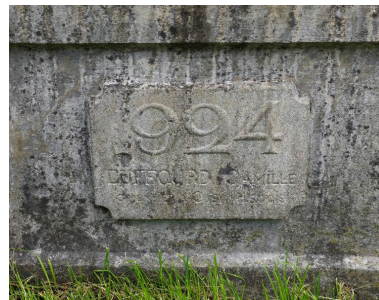
Détail de la plaque avec inscriptions. Phot. Thierry Leroy IVR82_20157303879NUCA
