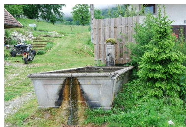
Vue d'ensemble de trois quart du bassin. Phot. Thierry Monnet IVR82_20157302587NUCA
