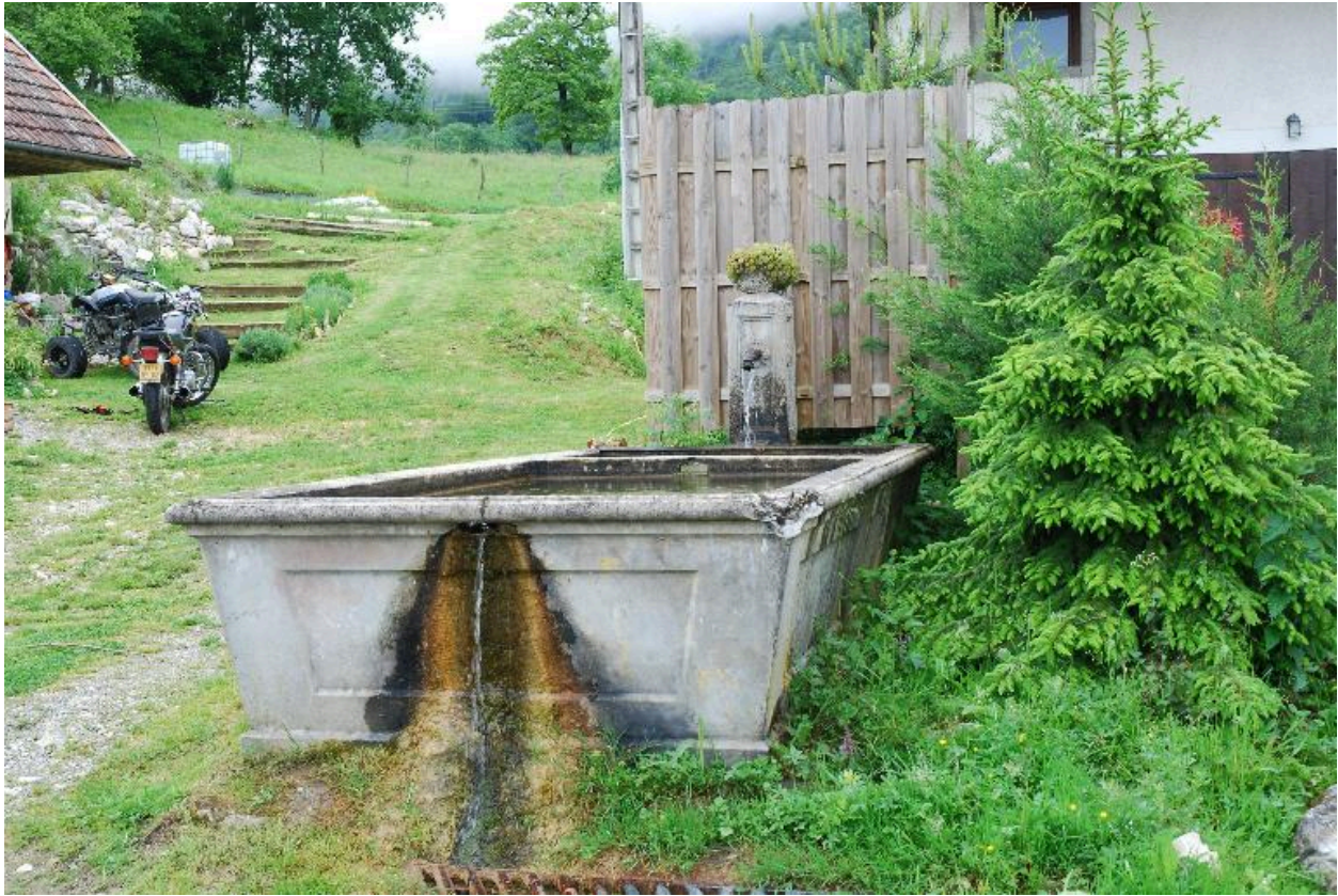
Vue d'ensemble de trois quart du bassin.
