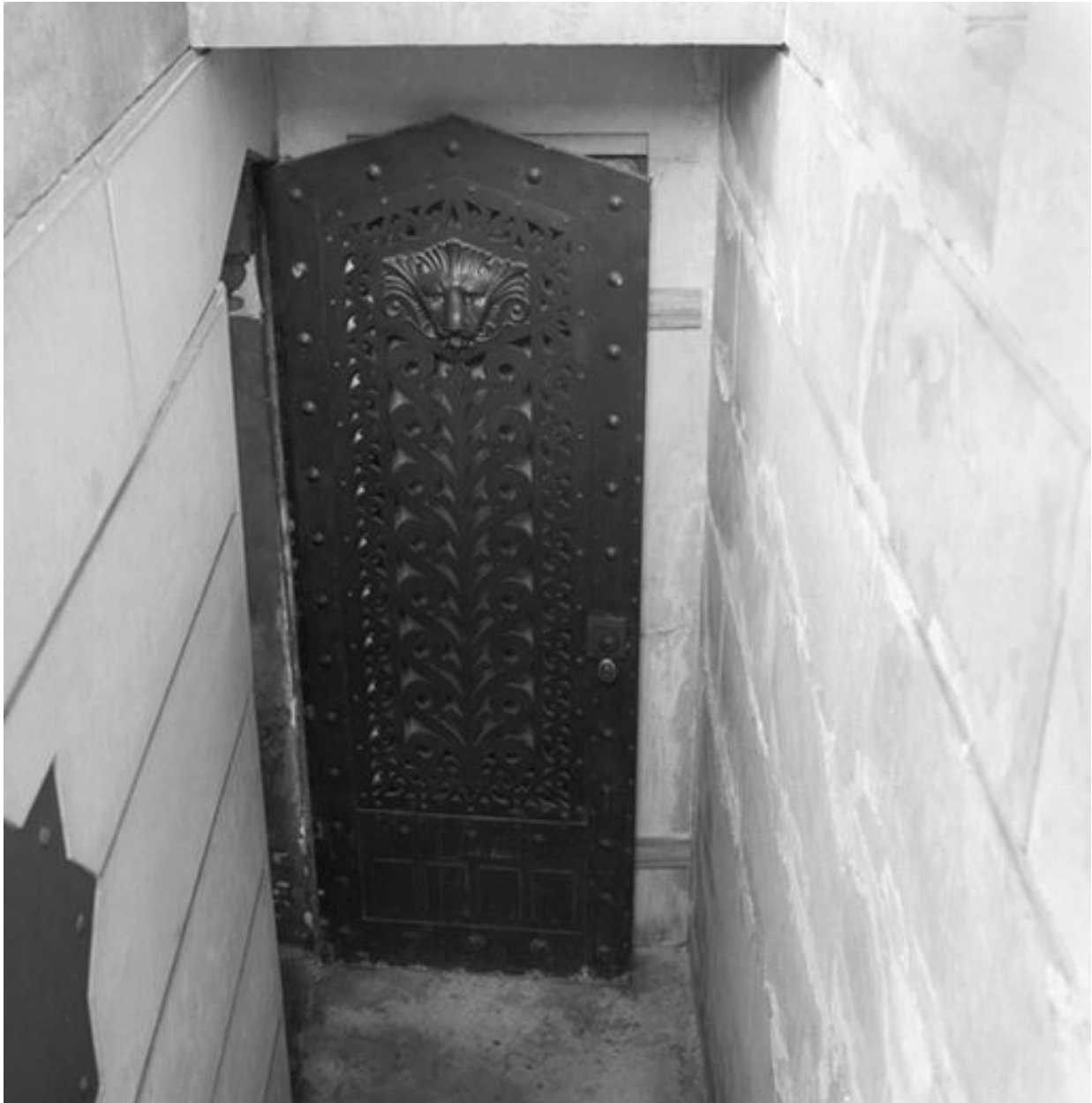
Vue du vantail ouvert depuis le haut de l'escalier
