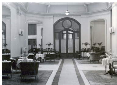
Le hall d'entrée au milieu du XXe siècle Repro. François Fouger IVR82_20097301004NUCB
