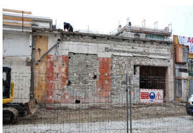
Traces des anciennes boutiques Phot. François Fouger IVR82_20097301089NUCA
