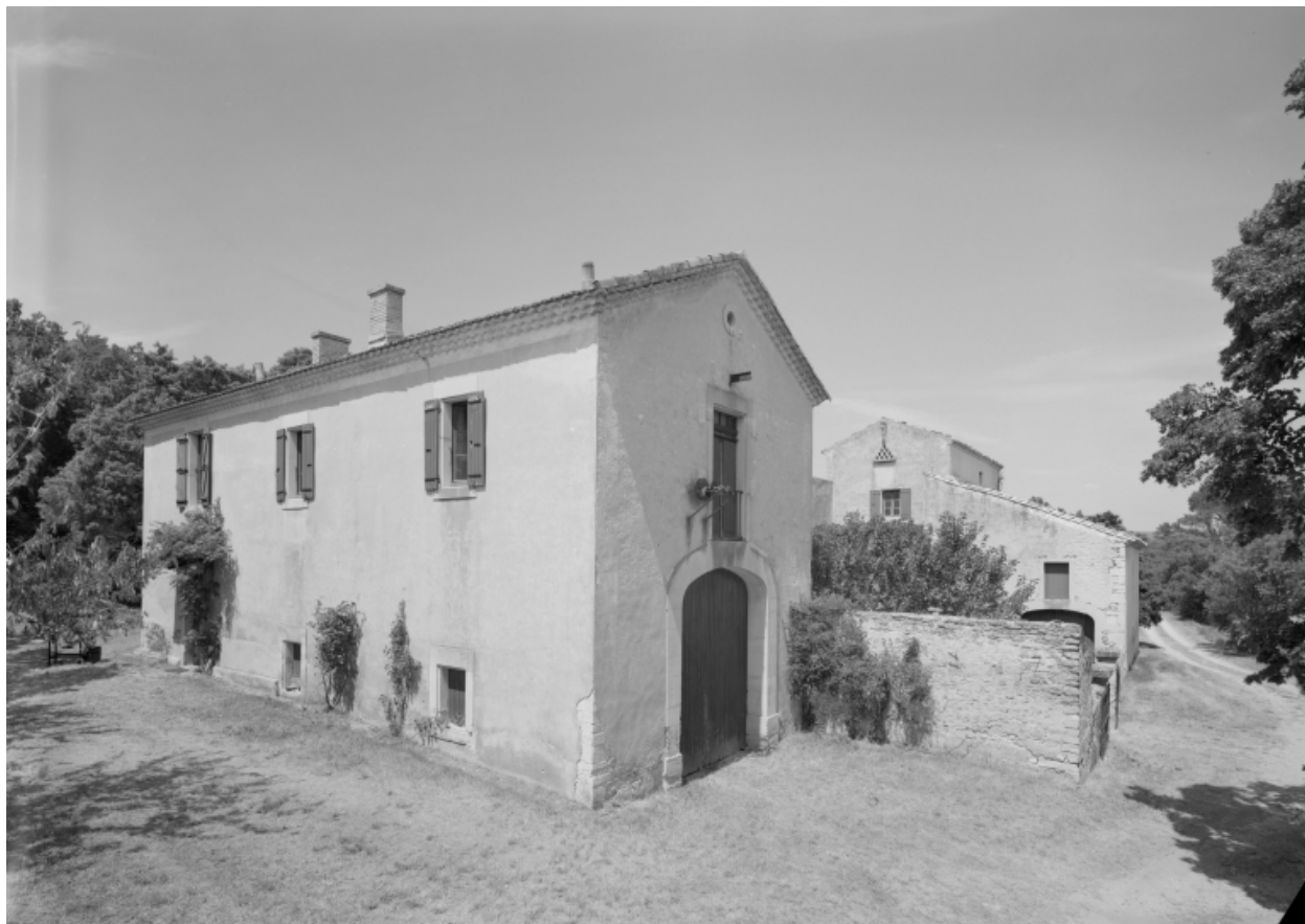
Vue de trois quarts d'une ancienne dépendance, actuellement logis, dont le grenier était aménagé en magnanerie.
