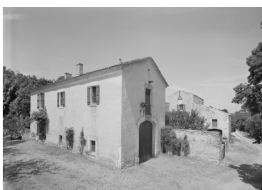
Vue de trois quarts d'une ancienne dépendance, actuellement logis, dont le grenier était aménagé en magnanerie.
