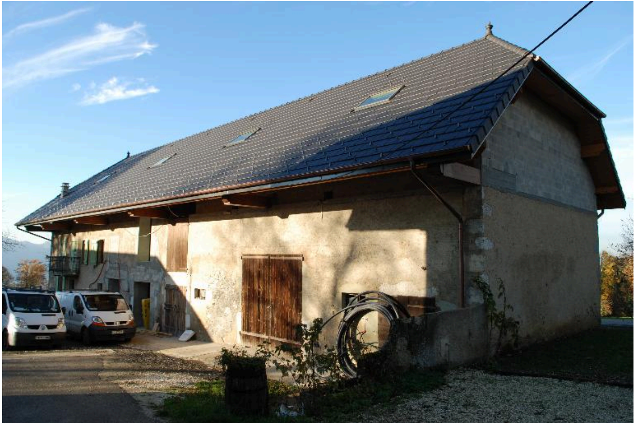
Vue d'ensemble de trois-quarts depuis le sud-est
