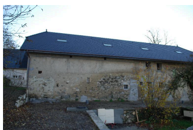
Vue partielle de la façade nord, partie de gauche. Phot. Thierry Monnet IVR84_20177300760NUCA
