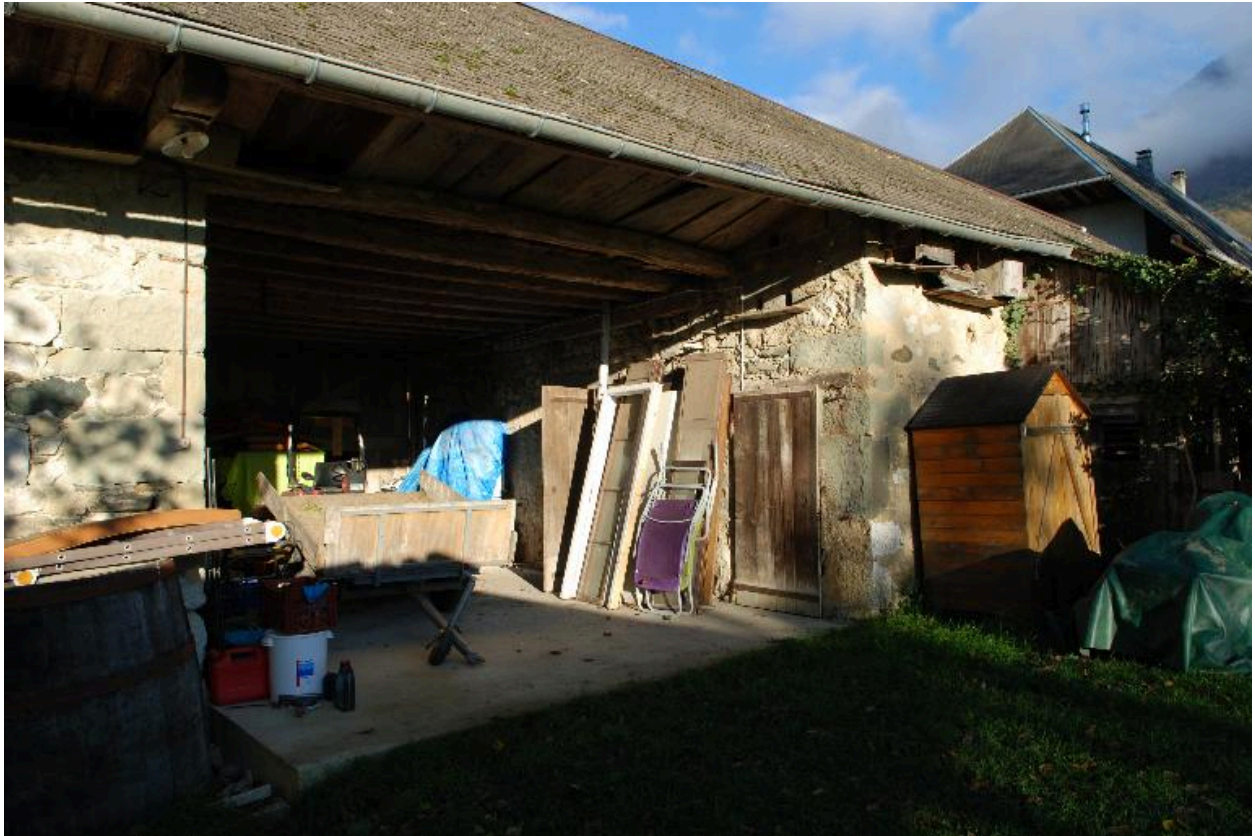
Vue partielle de la façade sud des bâtiments agricoles annexes avec pigeonnier.
