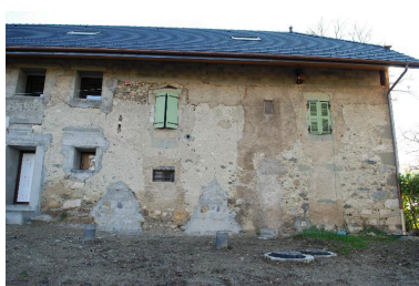
Vue partielle de la façade nord, partie de droite Phot. Thierry Monnet IVR84_20177300761NUCA
