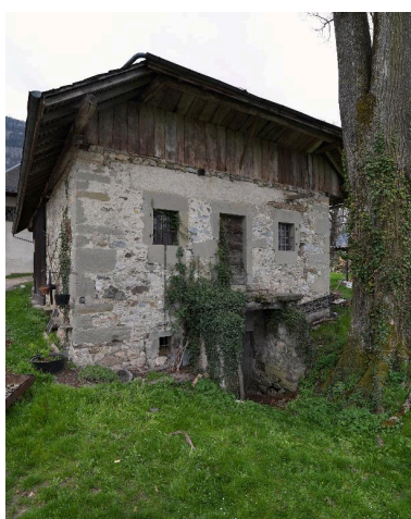
Vue d'ensemble de trois-quarts de la cave-grenier (?) Phot. Thierry Leroy IVR82_20157303713NUCAQ
