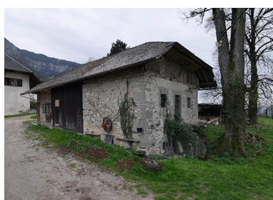
Vue d'ensemble de trois quarts des bâtiments agricoles annexes. Phot. Thierry Leroy IVR82_20157303710NUCAQ
