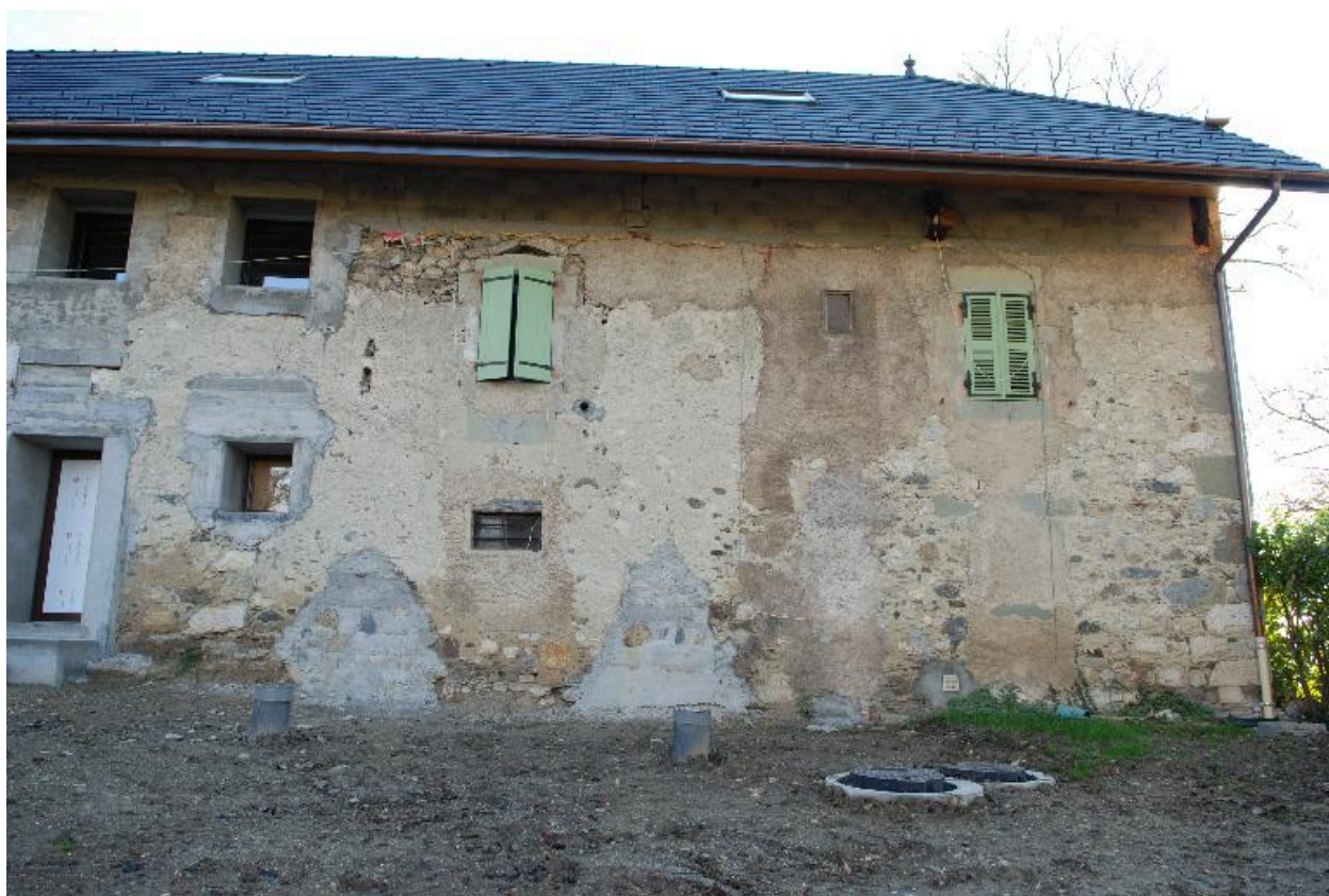
Vue partielle de la façade nord, partie de droite
