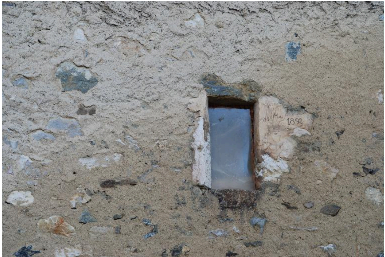
Détail d'une baie de la façade nord.
