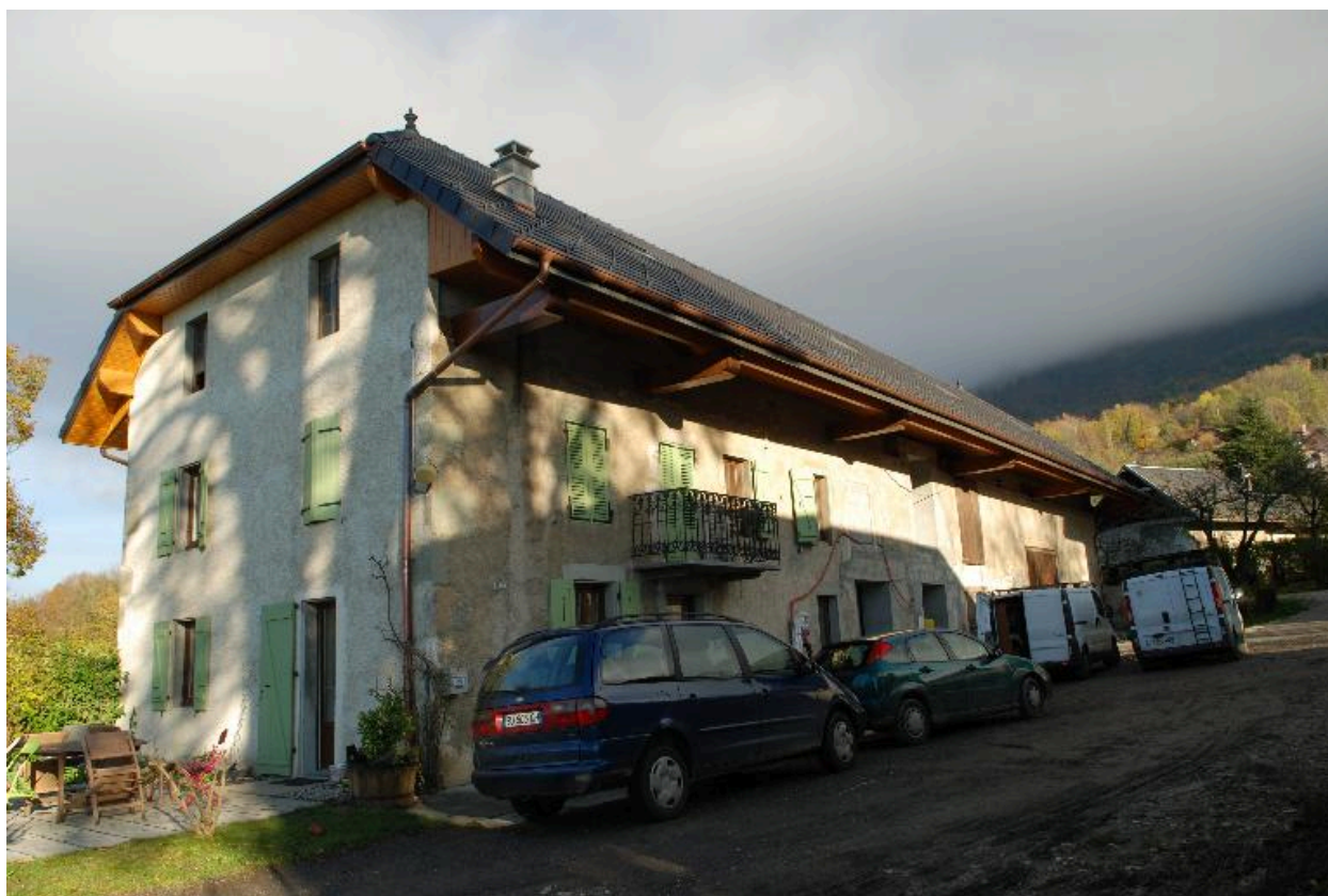
Vue d'ensemble de trois-quarts depuis le sud-ouest.
