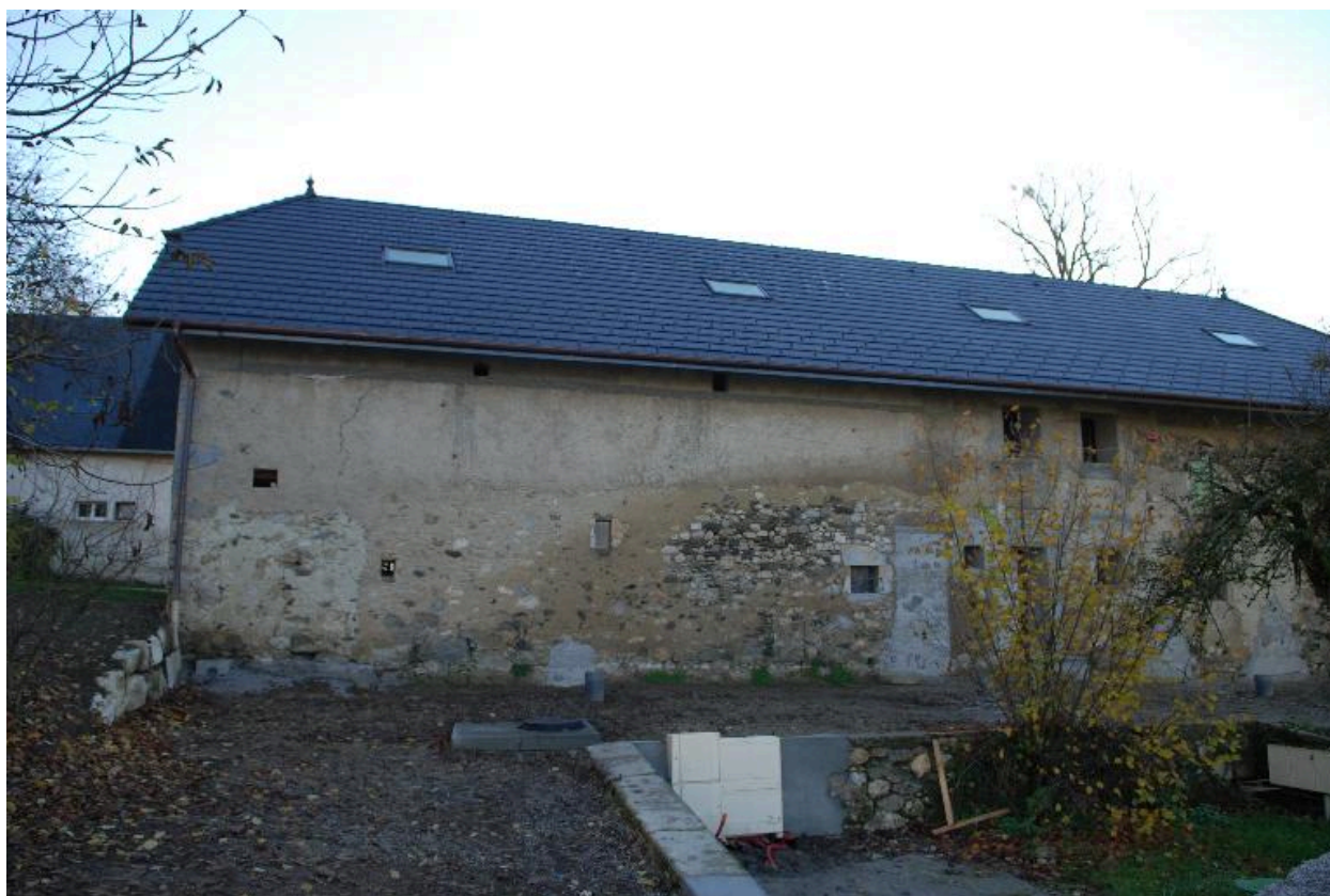
Vue partielle de la façade nord, partie de gauche.
