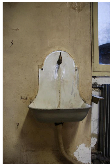
Lavabo de l'ancienne salle de physique Phot. Thierry Leroy IVR82_20136902060NUCA
