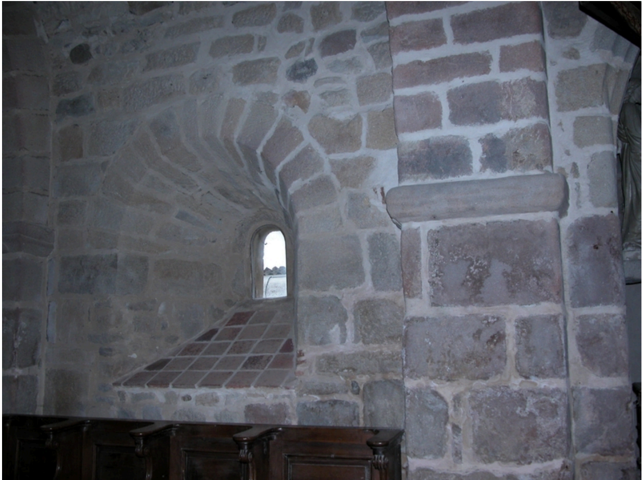
Vue intérieure de la travée de choeur : fenêtre sud.
