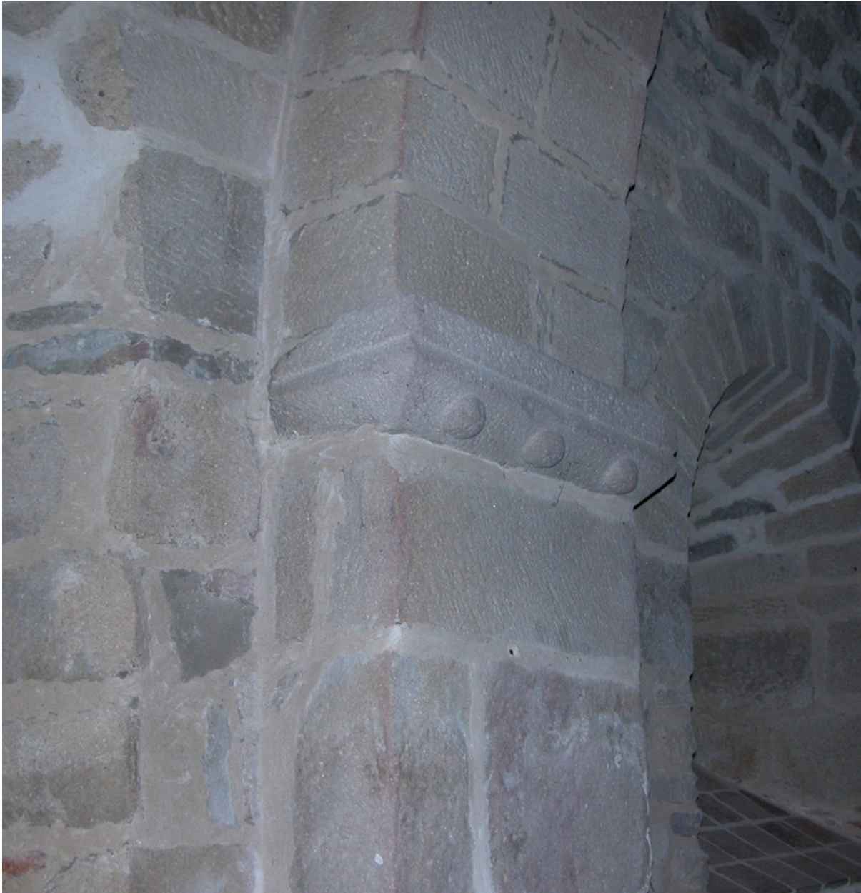
Détail de l'imposte du pilier sud du choeur (travée de choeur, angle sud-ouest).
