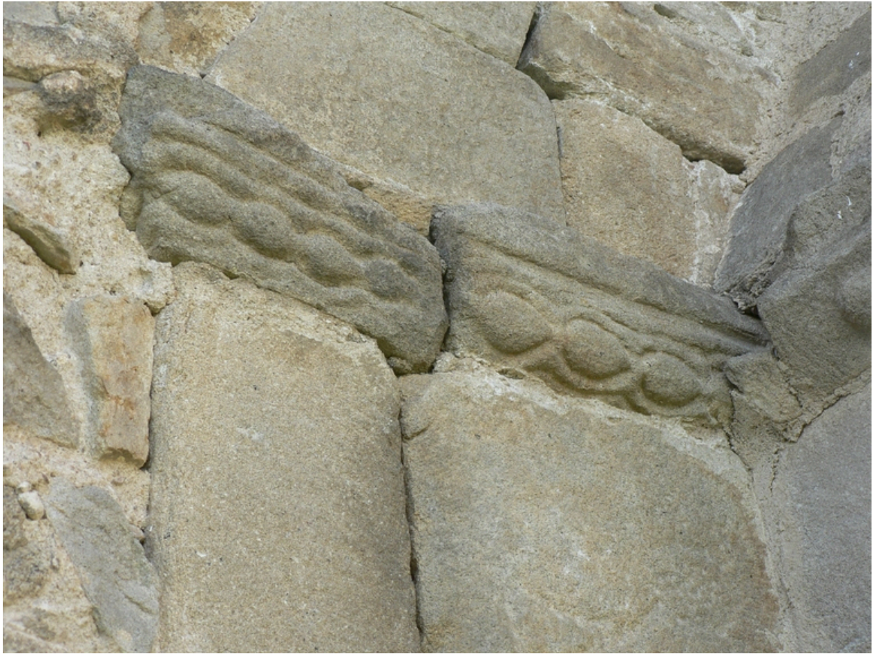
Détail du larmier du contrefort sud-est de la travée IV (à l'angle avec la travée de choeur).
