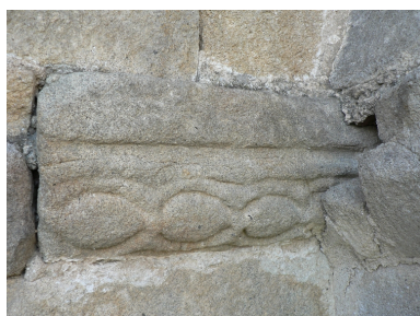
Détail du larmier du contrefort sud-est de la travée IV (à l'angle avec la travée de choeur). Phot. M. Busseuil IVR82_20114200025NUCA
