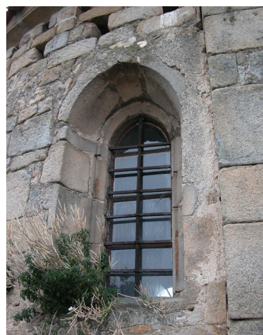
Détail de la fenêtre nord de l'abside. Phot. Caroline Guibaud IVR82_20114200015NUCA
