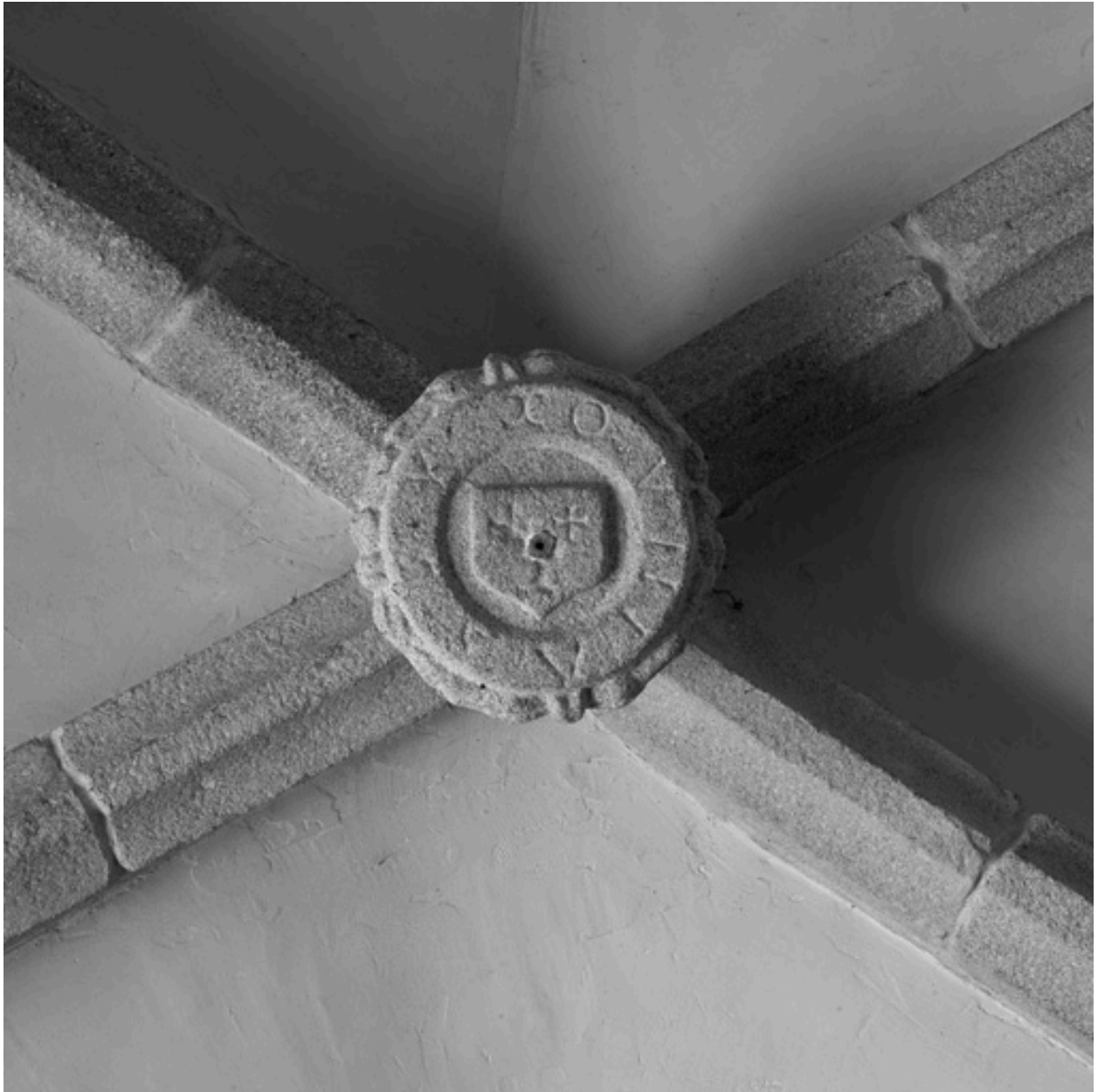
Détail de la clef de voûte de la chapelle Saint-Thomas.
