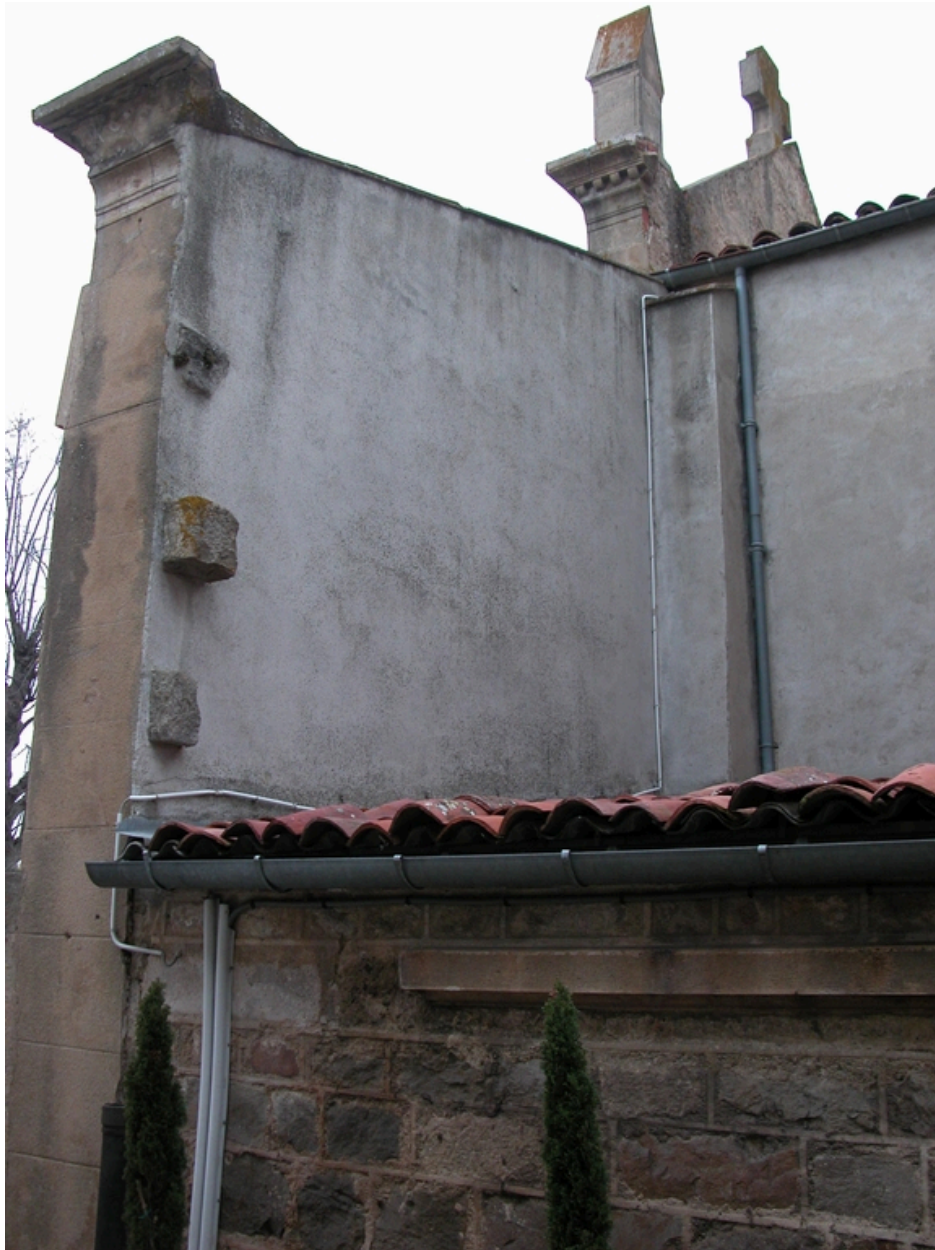
Vue arrière de la façade occidentale (partie sud, mur au-dessus de la chapelle Saint-Vincent, au sud-ouest).
