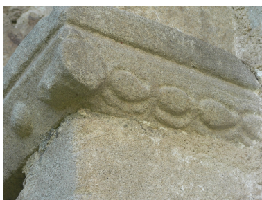
Détail du larmier du contrefort sud de la travée de choeur (angle avec la travée VI). Phot. M. Busseuil IVR82_20114200028NUCA
