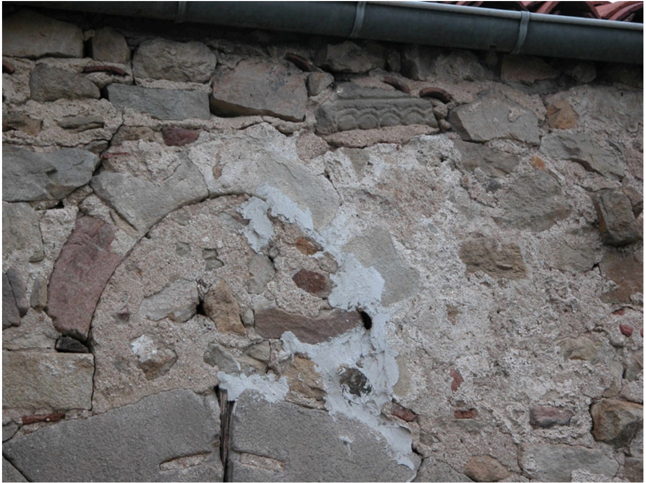
Détail des vestiges de l'ancienne fenêtre de la chapelle des Chabeu.
