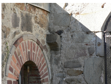
Détail d'un corbeau dans le mur de la chapelle des Chabeu (chapelle sud-est), à l'angle du mur de la sacristie. Phot. M. Busseuil IVR82_20114200029NUCA
