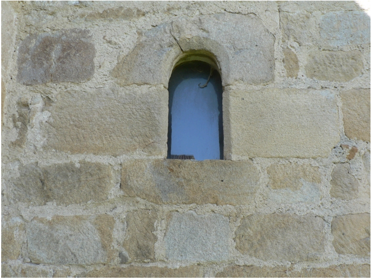
Détail de la fenêtre sud de la travée de choeur.
