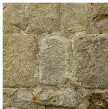
Détail du layage d'une pierre située à droite de la fenêtre sud de l'abside, dans la seconde assise de pierre de taille (en partant du sol). Phot. Eric Dessert IVR82_20064200309NUCA
