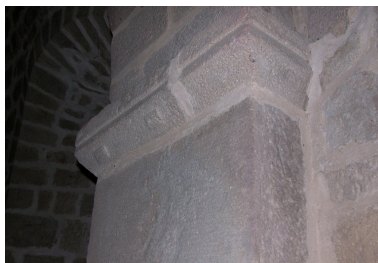
Détail de l'imposte du pilier nord du chœur (travée de choeur, angle nord-ouest). Phot. Caroline Guibaud IVR82_20114200018NUCA
