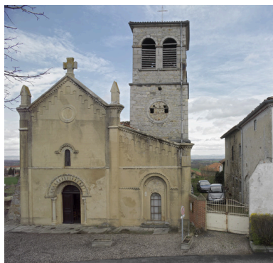
Vue d'ensemble de la façade occidentale. Phot. Eric Dessert IVR82_20064200304NUCA
