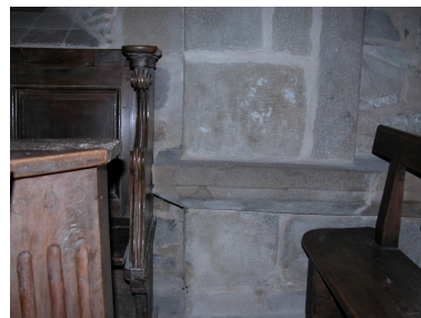
Détail du départ de la banquette de l'abside, côté nord. Phot. Caroline Guibaud IVR82_20114200020NUCA
