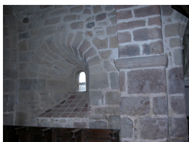
Vue intérieure de la travée de chœur : fenêtre sud. Phot. Caroline Guibaud IVR82_20114200019NUCA
