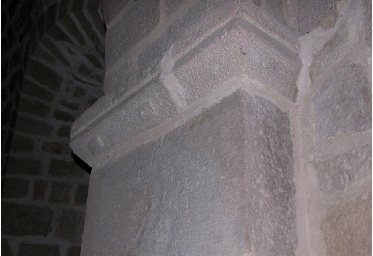
Détail de l'imposte du pilier nord du choeur (travée de choeur, angle nord-ouest).
