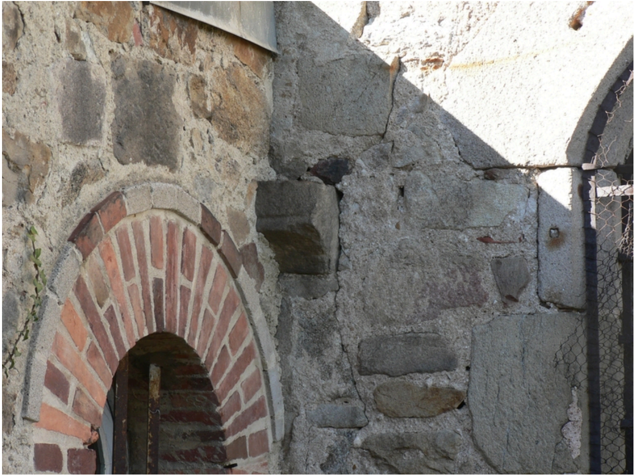
Détail d'un corbeau dans le mur de la chapelle des Chabeu (chapelle sud-est), à l'angle du mur de la sacristie.
