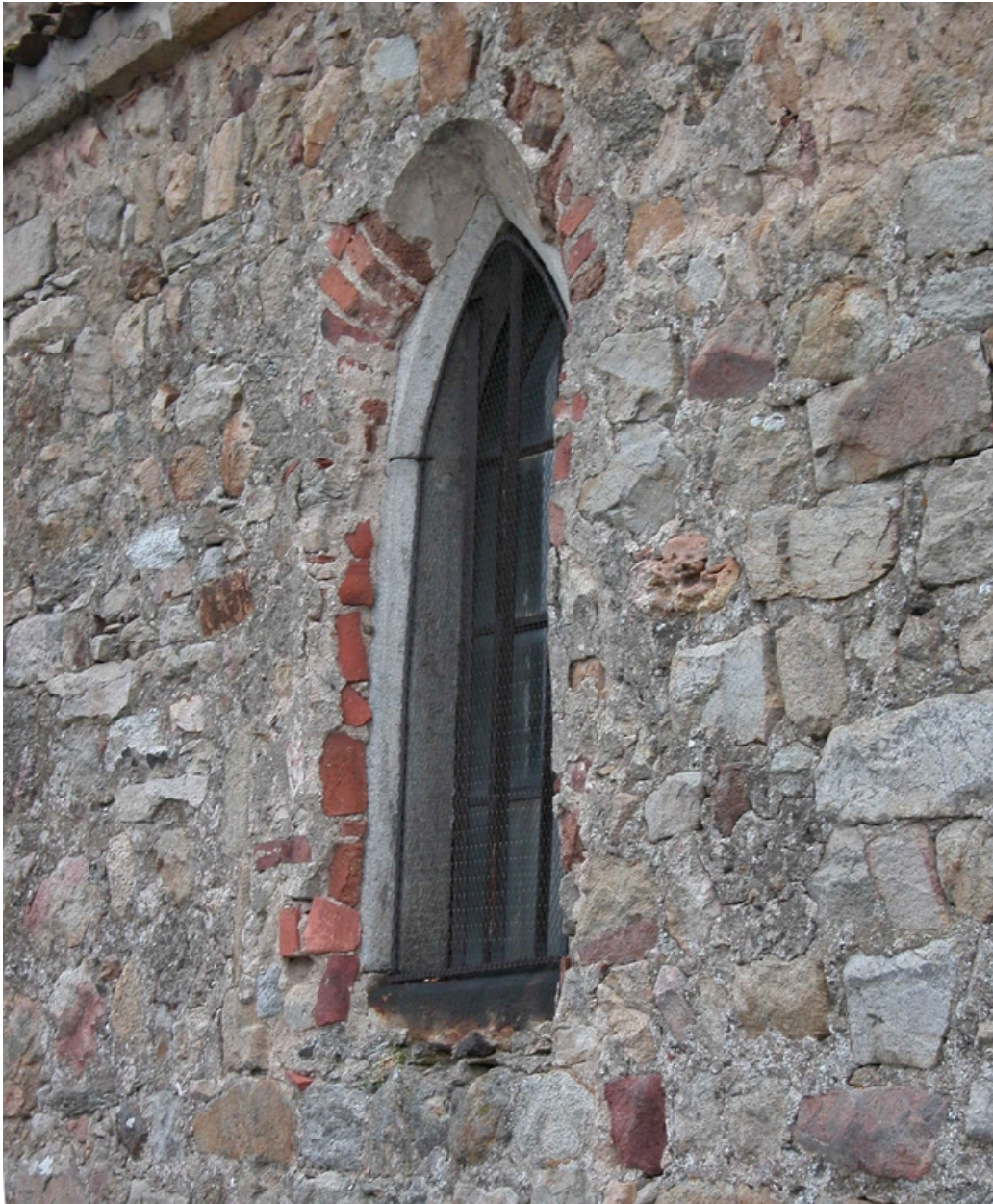
Détail de la fenêtre de la chapelle Saint-Thomas (chapelle nord).
