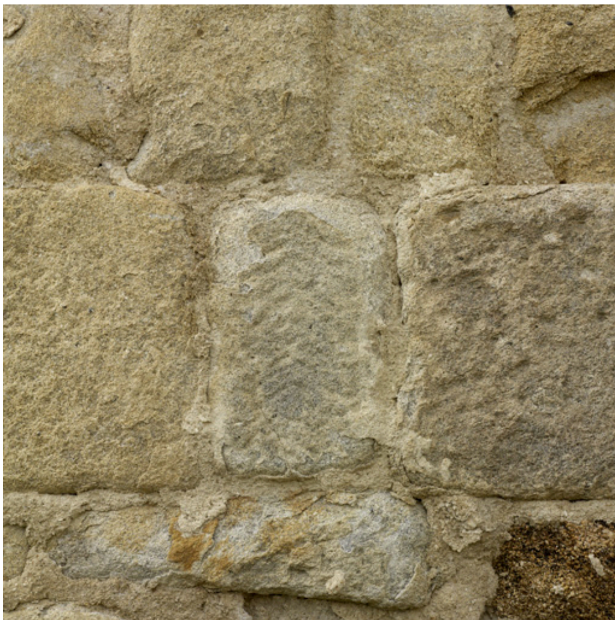
Détail du layage d'une pierre située à droite de la fenêtre sud de l'abside, dans la seconde assise de pierre de taille (en partant du sol).
