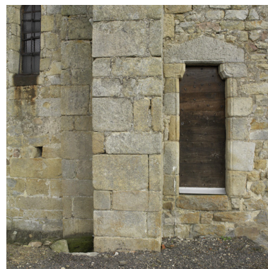
Vue de la porte nord. Phot. Eric Dessert IVR82_20064200308NUCA
