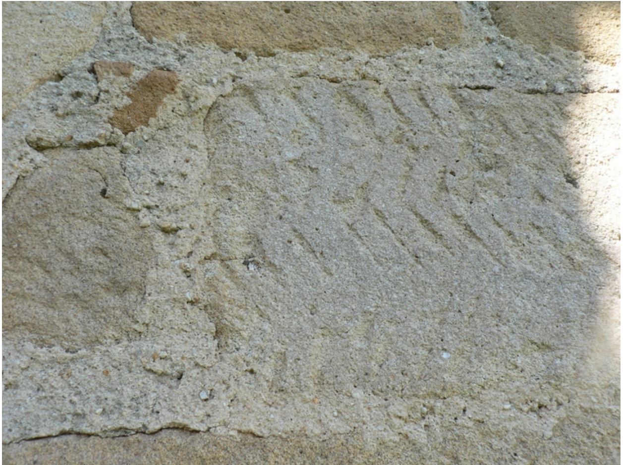
Détail du layage d'une pierre située à droite de la fenêtre sud de la travée de chœur.
