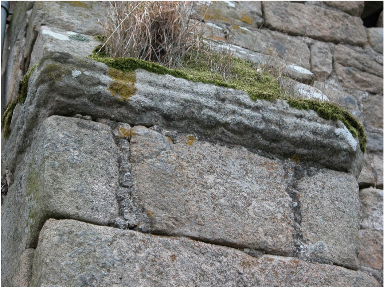
Détail du larmier du contrefort à gauche de la porte nord.
