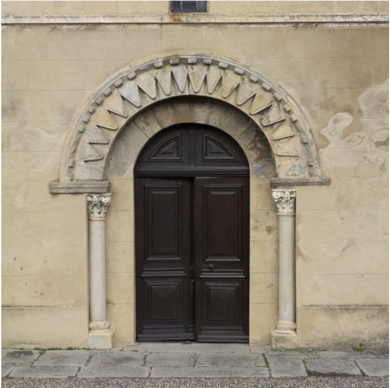
Vue d'ensemble du portail de la façade occidentale.
