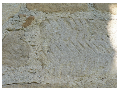
Détail du layage d'une pierre située à droite de la fenêtre sud de la travée de choeur. Phot. M. Busseuil IVR82_20114200027NUCA
