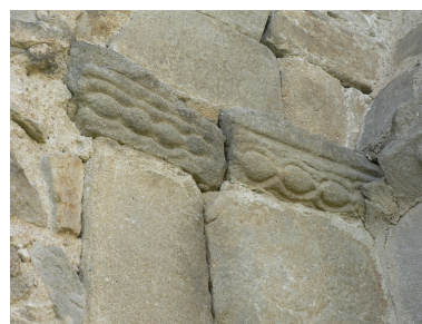
Détail du larmier du contrefort sud-est de la travée IV (à l'angle avec la travée de choeur). Phot. M. Busseuil IVR82_20114200024NUCA
