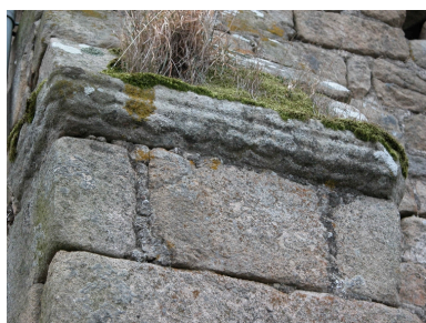
Détail du larmier du contrefort à gauche de la porte nord. Phot. Caroline Guibaud IVR82_20114200016NUCA
