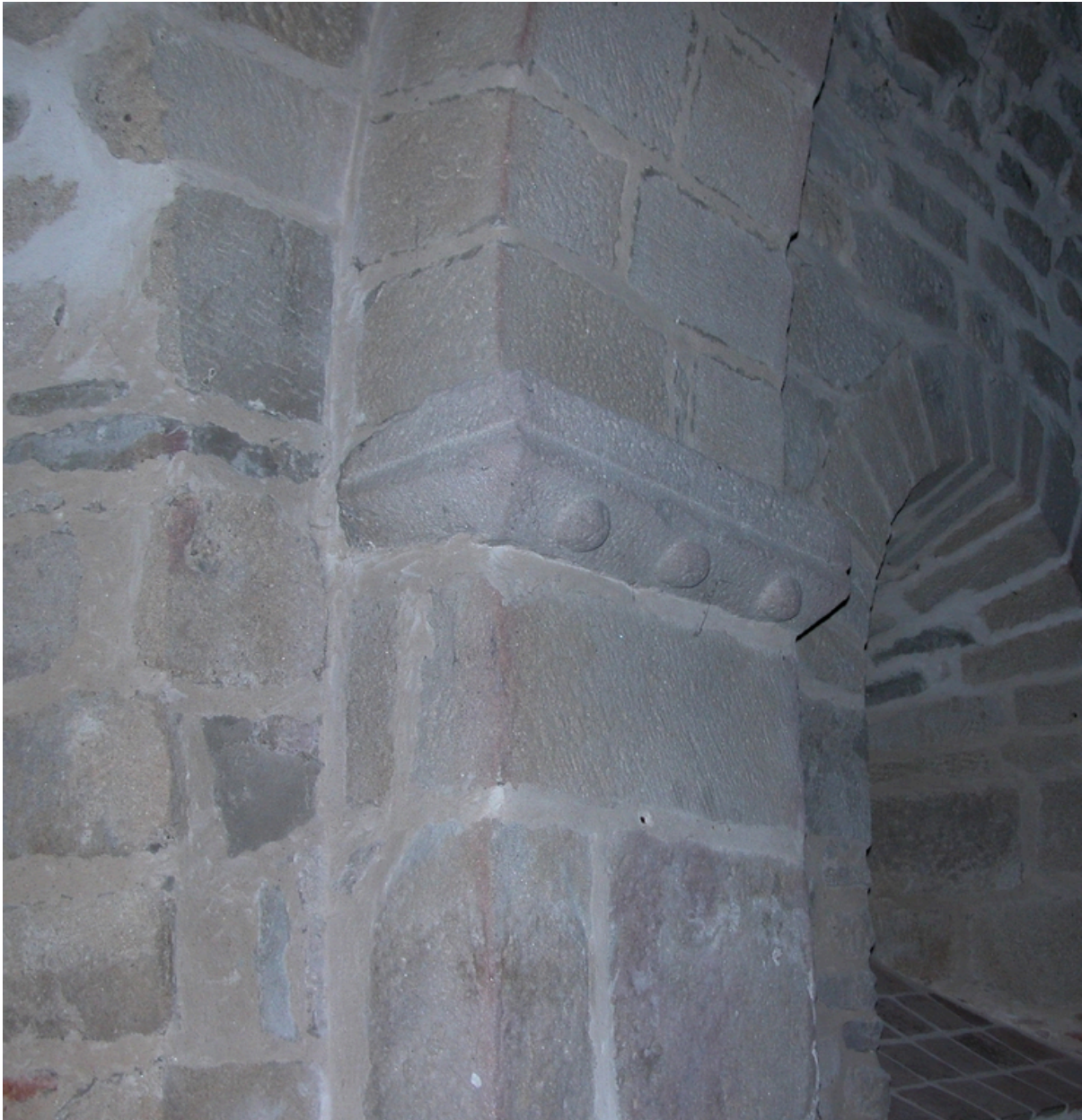
Détail de l'imposte du pilier sud du choeur (travée de choeur, angle sud-ouest).
