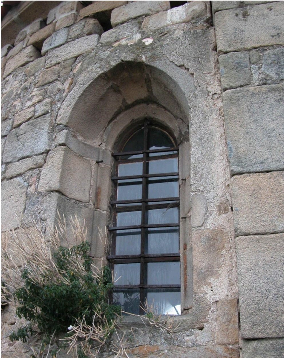
Détail de la fenêtre nord de l'abside.
