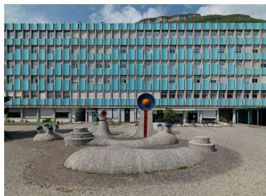
Vue générale, de face Phot. Eric Dessert IVR84_20163800113NUCA
