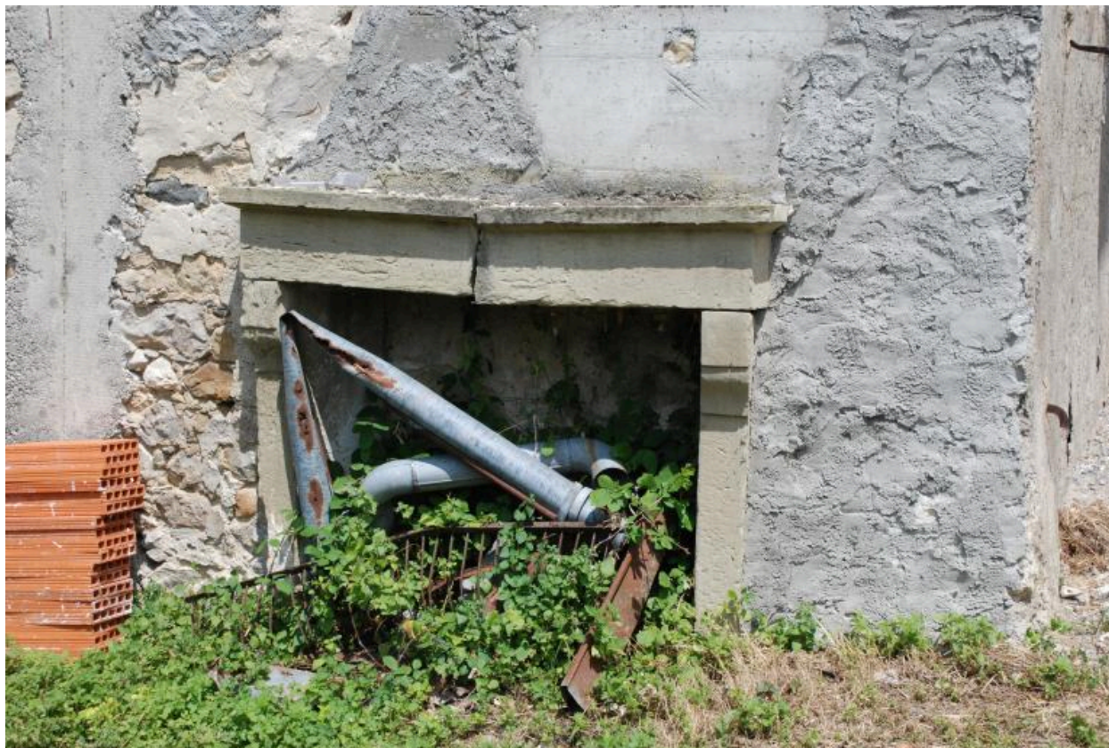
Cheminée en molasse de la cuisine d'une maison détruite, autrefois adossée au mur ouest de la ferme IA74002764.
