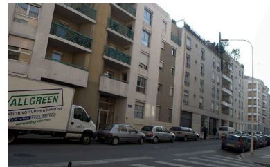
Elévation antérieure, vue partielle Phot. Maryannick Chalabi IVR82_20106903529NUCA
