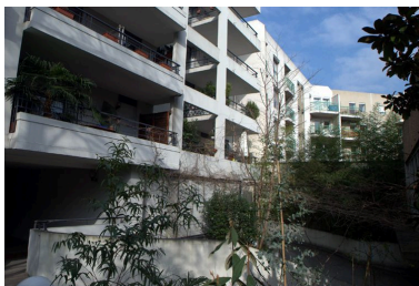
Vue partielle de l'élévation postérieure (à l'arrière-plan) Phot. Maryannick Chalabi IVR82_20106903520NUCA
