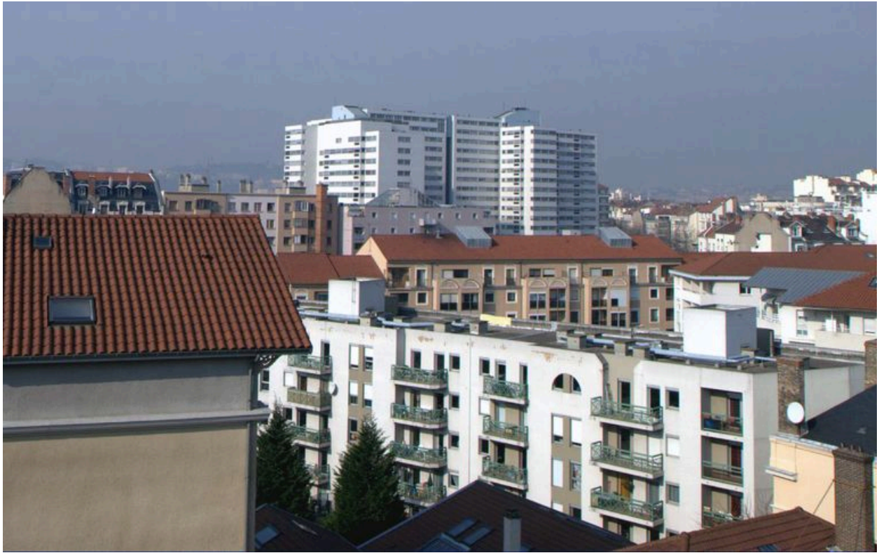
Elévation postérieure, vue partielle depuis le sud-est
