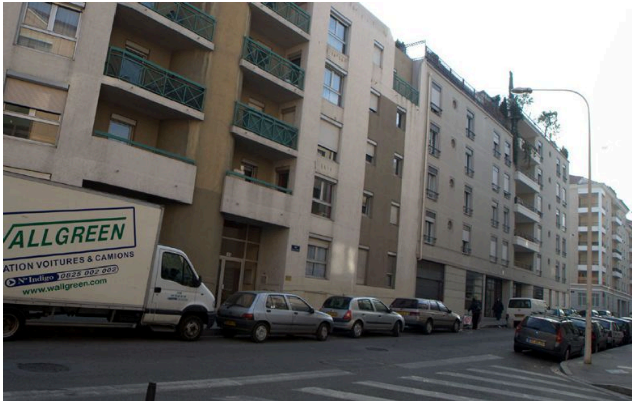
Élévation antérieure, vue partielle
