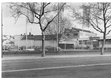
Vue des sheds Phot. Martial Couderette IVR82_20016903166P
