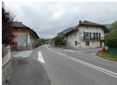
Vue d'ensemble du bâtiment le long de la route principale. Phot. Thierry Leroy IVR84_20167401900NUCAQ
