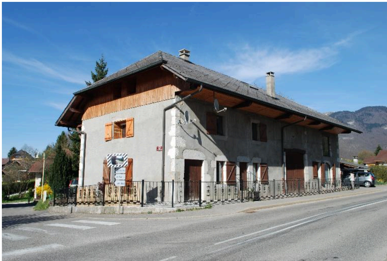
Vue d'ensemble de trois-quarts avant gauche.
