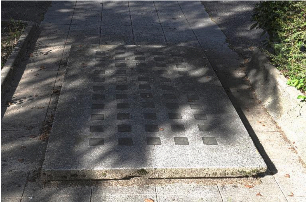
Pavés de verre éclairant les galeries souterraines
