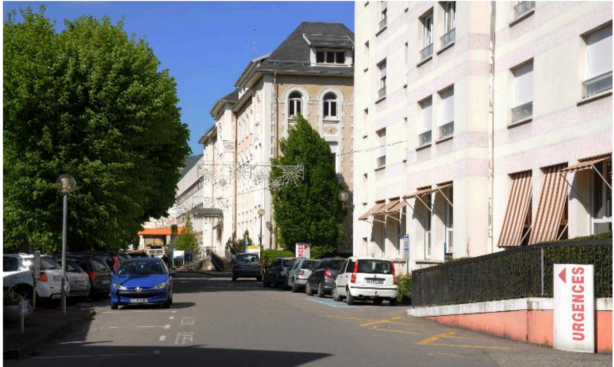
Voie de circulation au sud des pavillons Brachet (bât. B), Le Revard (bât. F) et BMT (bât. G)
