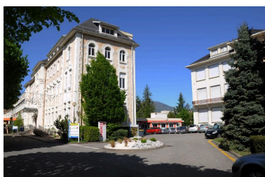
Pavillon Le Revard à gauche (bât. F) et Ex-maternité à droite (bât. C) Phot. Denys Harreau IVR82_20147300567NUCA
