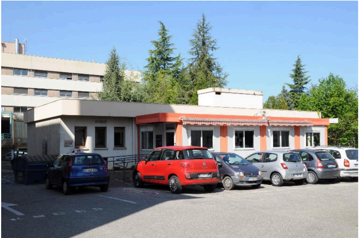
Pharmacie (bât. E), façade est
