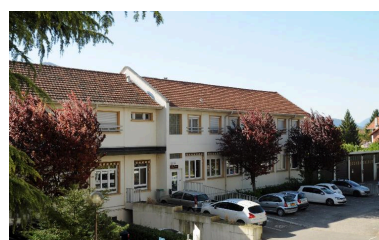
Pavillon Hubert Perrier (bât. I) et menuiserie (bât. J), vue de trois-quart gauche Phot. Denys Harreau IVR82_20147300575NUCA
