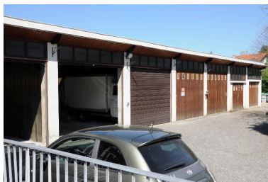
Garages (bât. K) Phot. Denys Harreau IVR82_20147300568NUCA
