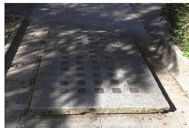
Pavés de verre éclairant les galeries souterraines Phot. Denys Harreau IVR82_20147300505NUCAQ
