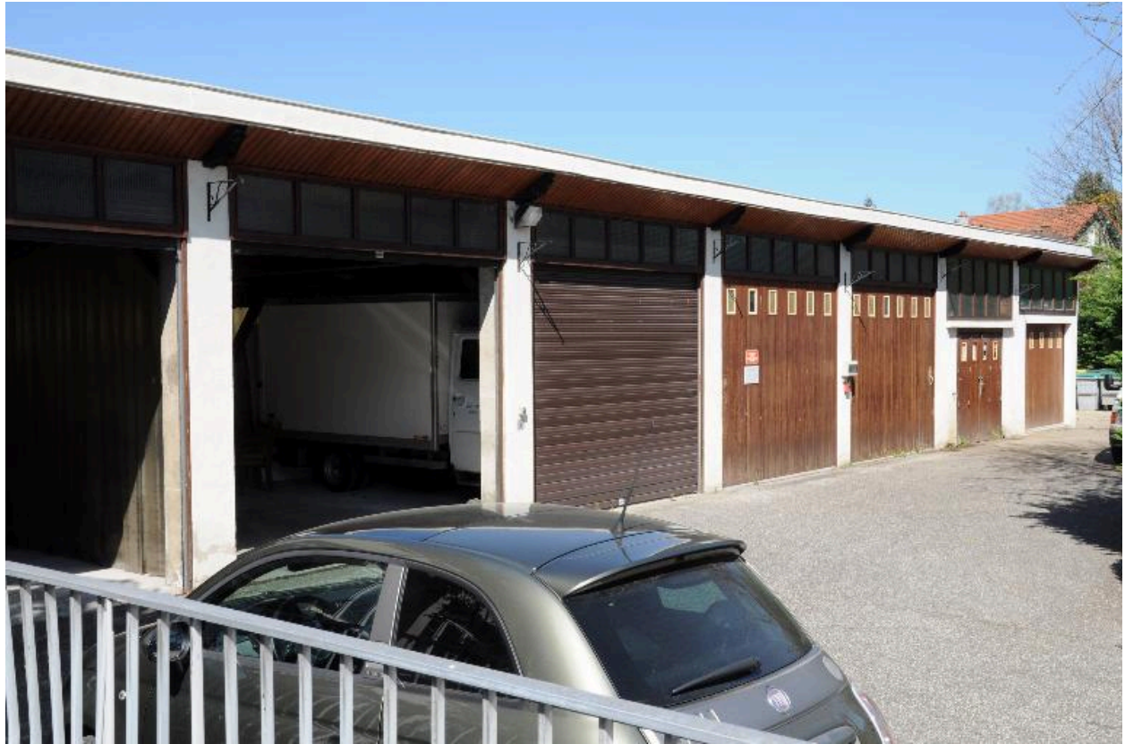
Garages (bât. K)
