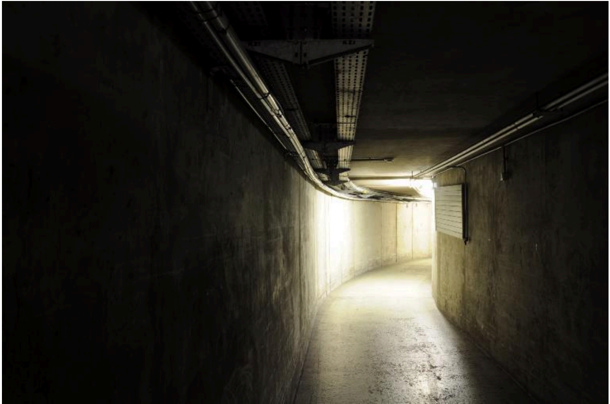
Galerie souterraine, reliant le BMT (bât. G) et le pavillon Le Revard (bât. F)
