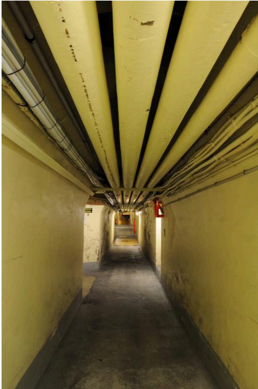
Galerie souterraine voûtée, reliant les pavillons Le Revard (bât. F) et Brachet (bât. B)
