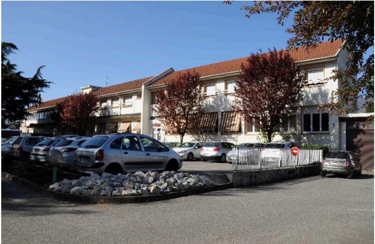
Pavillon Hubert Perrier (bât. I) et menuiserie (bât. J), vue de trois-quart droit
