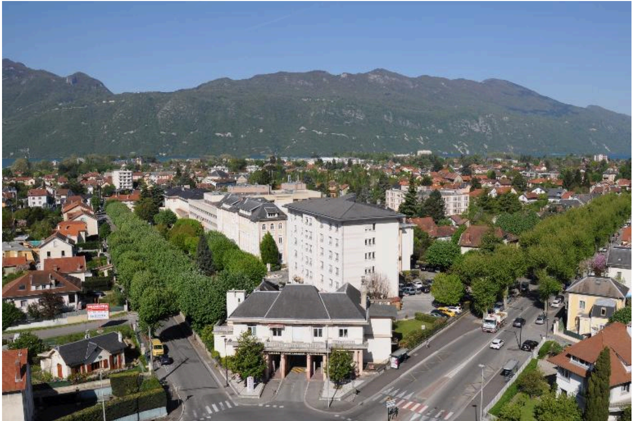
Vue aérienne d'ensemble
