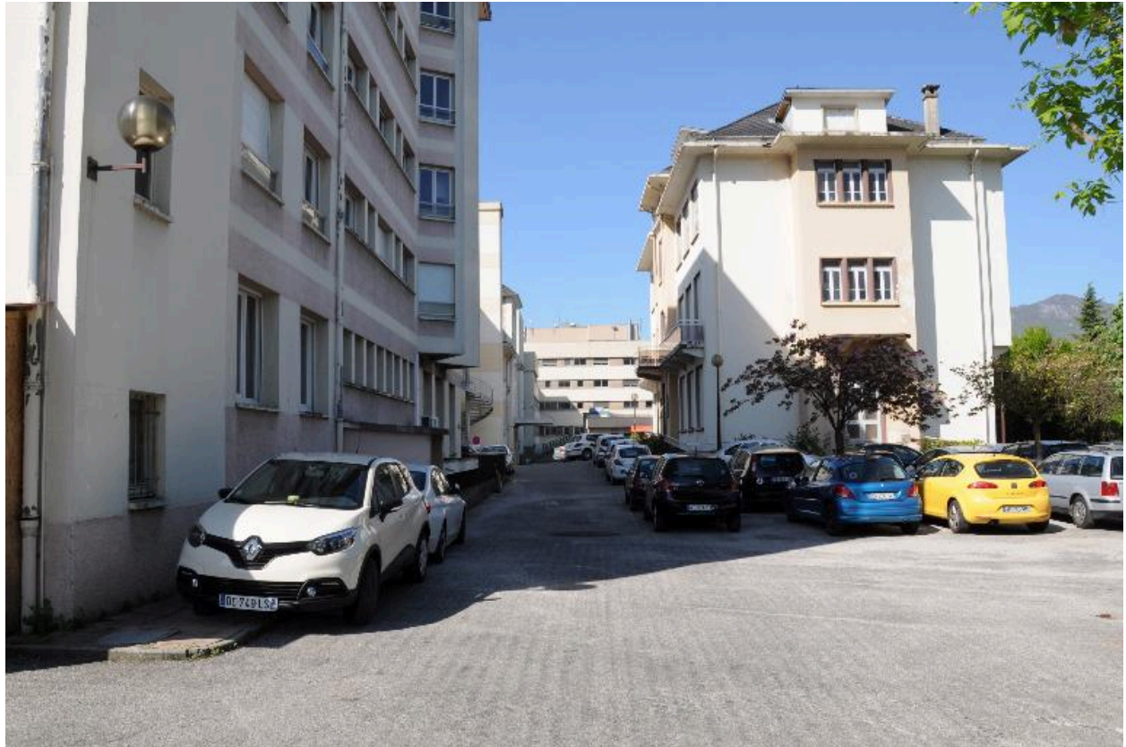
Pavillon Brachet à gauche (bât. B) et Ex-maternité à droite (bât. C)
