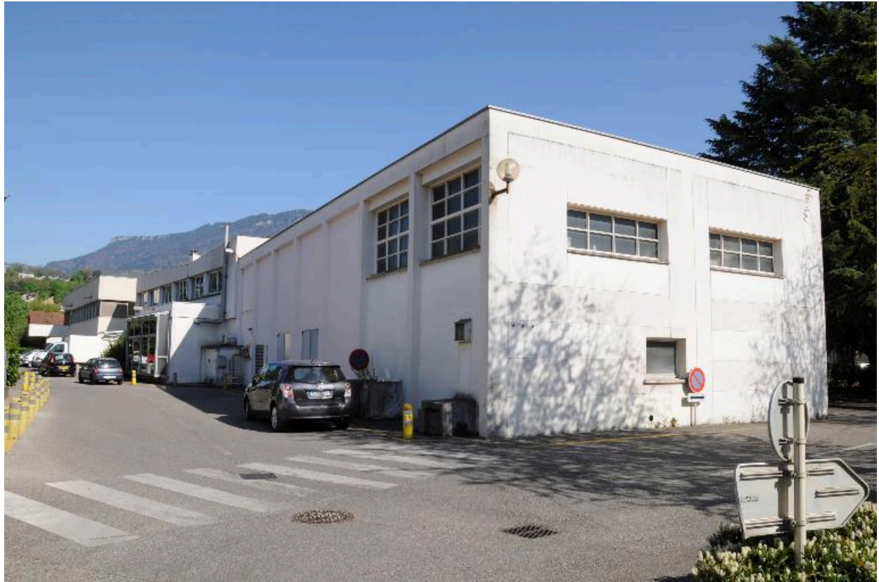
Chaufferie (bât. L) et blanchisserie (bât. M)
