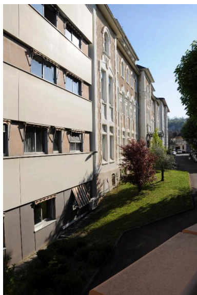
BMT (bât. G), pavillon Le Revard (bât. F) et pavillon Brachet (bât. B) Phot. Denys Harreau IVR82_20147300555NUCA
