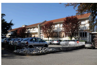
Pavillon Hubert Perrier (bât. I) et menuiserie (bât. J), vue de trois-quart droit Phot. Denys Harreau IVR82_20147300558NUCA
