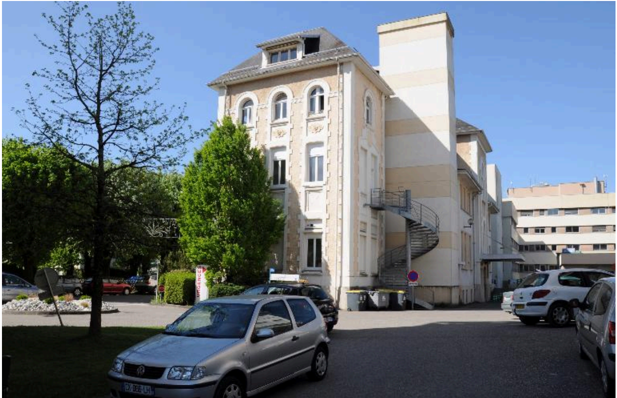
Pavillon Le Revard (bât. F) et BMT en arrière-plan (bât. G)
