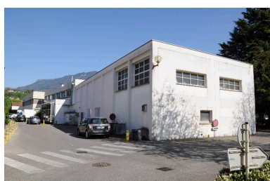
Chaufferie (bât. L) et blanchisserie (bât. M) Phot. Denys Harreau IVR82_20147300550NUCA
