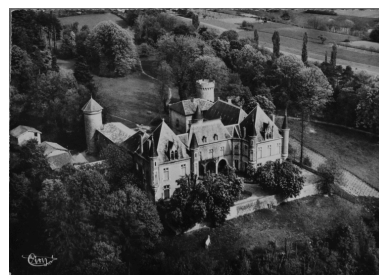
Beauregard (Ain). vue générale du château. Carte postale [milieu XXe siècle], Combiér impr. Mâcon, Cim 23 (repro. interdite) Repro. Jean-Marie Refflé IVR82_19920101023XB
