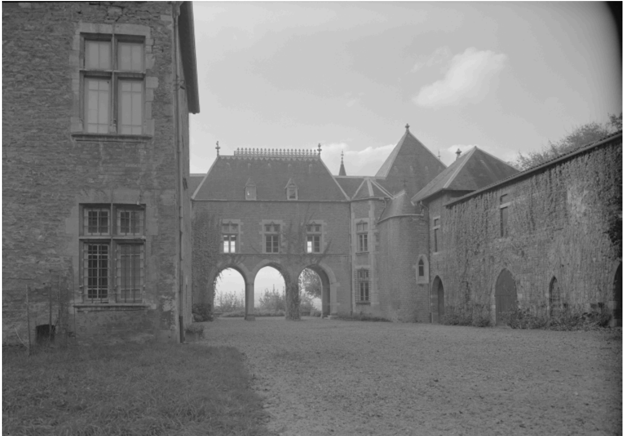
La cour intérieure, vue depuis l'est.
