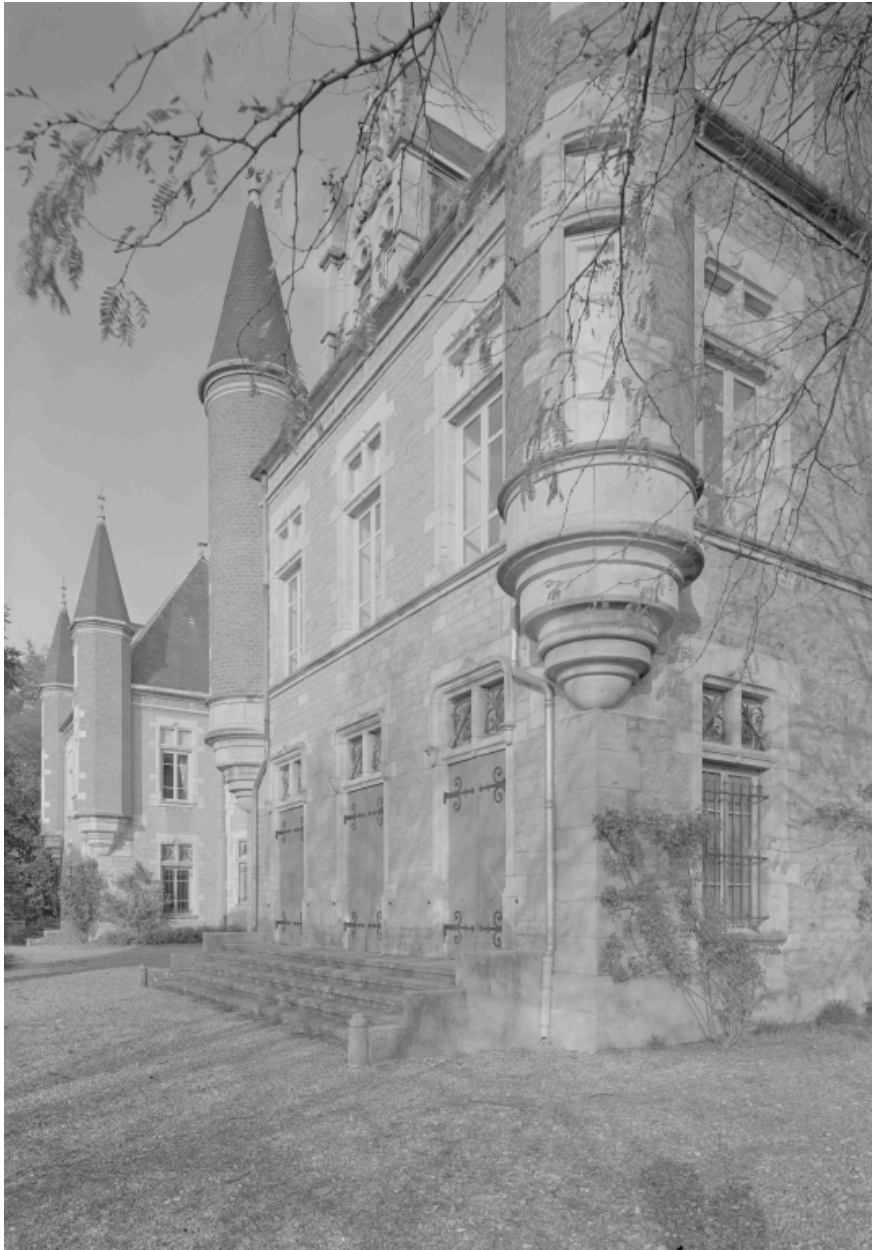
Façade ouest, vue depuis le sud-ouest.
