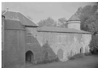
Aile nord, élévation sur cour, et tour nord-est. Phot. Jean-Marie Refflé IVR82_19870100577P
