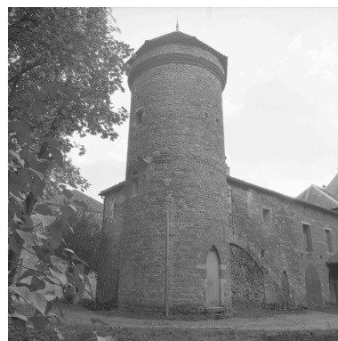
Aile nord : porte du corps de passage, côté nord. Phot. Jean-Marie Refflé IVR82_19870100596X
