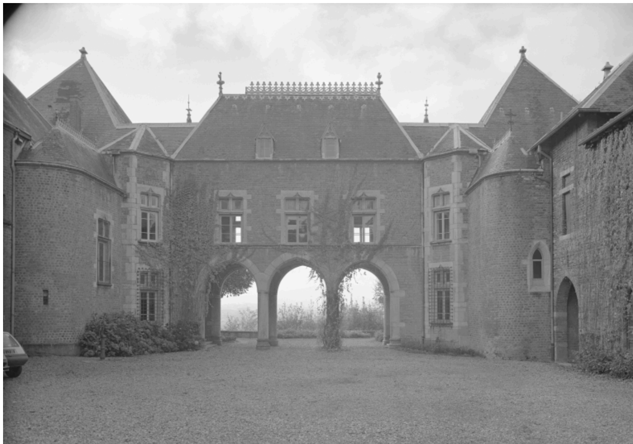
Le corps de passage, vue prise de l'est.
