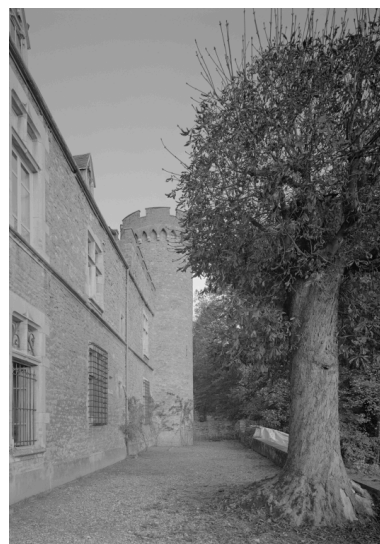
Aile sud, élévation postérieure sur terrasse. Phot. Jean-Marie Refflé IVR82_19870100574P
