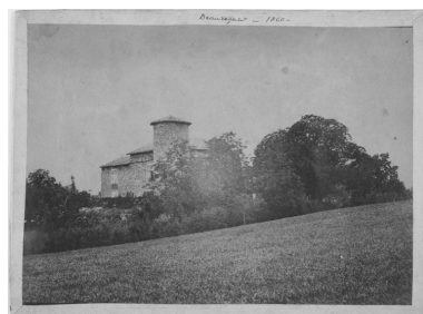
Etat avant 1860. Photogr. ancienne. Repro. Jean-Marie Refflé IVR82_19870100566P
