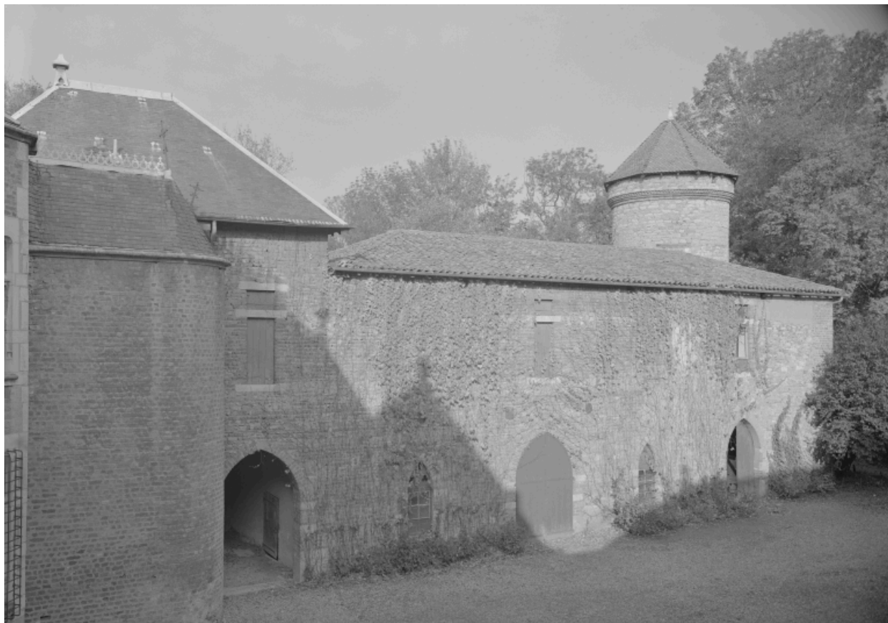
Aile nord, élévation sur cour, et tour nord-est.
