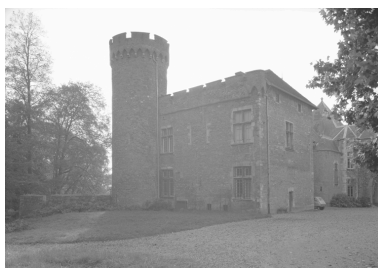
Aile sud : vestiges de l'ancien corps de logis (vue prise du nord-est). Phot. Jean-Marie Refflé IVR82_19870100568P
