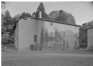
Ferme de Vignerons, logis et remise, élévation latérale. Phot. Jean-Marie Refflé IVR82_19870100585P
