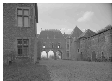
La cour intérieure, vue depuis l'est. Phot. Jean-Marie Refflé IVR82_19870100578P
