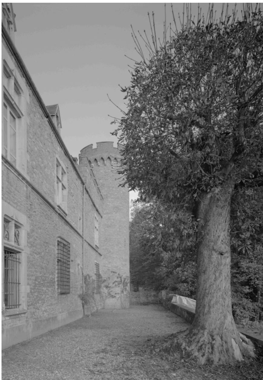
Aile sud, élévation postérieure sur terrasse.
