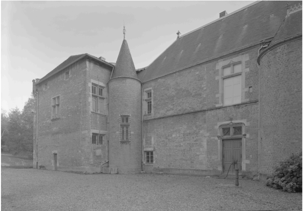
Aile sud, élévation sur cour.
