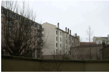
Vue de l'élévation postérieure depuis l'escalier du 3, avenue Jean-Jaurès Phot. Maryannick Chalabi IVR82_20046904322NUCA
