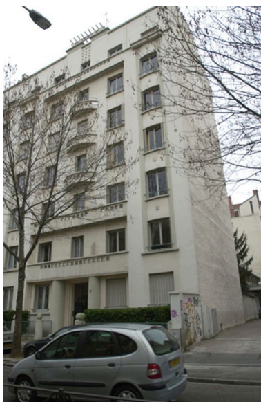
Détail du 14, rue Jean-Marie Chavant Phot. Maryannick Chalabi IVR82_20046904314NUCA
