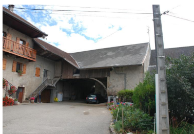
Vue d'ensemble des communs adossés au logis. Phot. Thierry Monnet IVR84_20207401709NUCA
