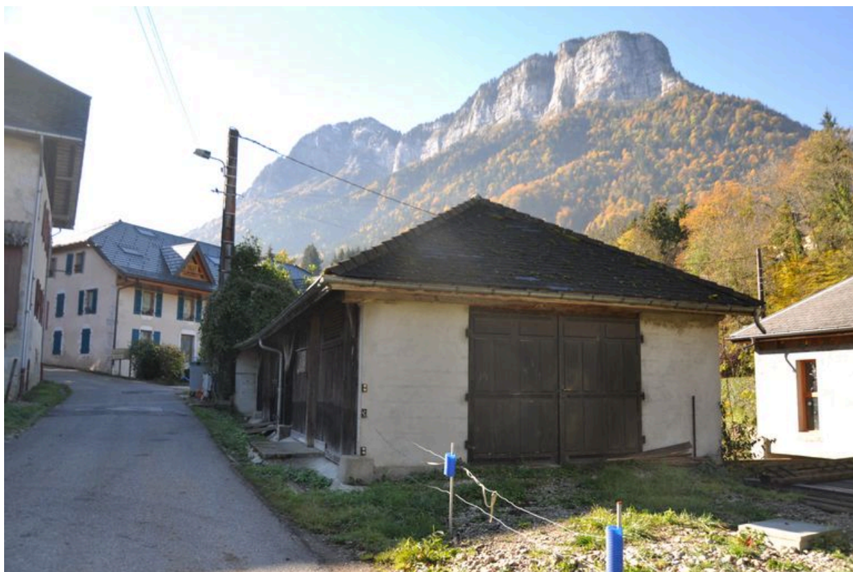
Mur pignon nord de l'ancien bâtiment de l'huilerie
