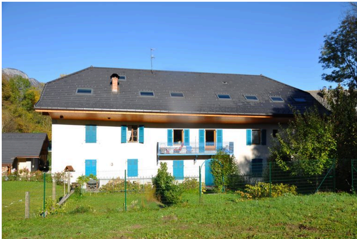
Vue de la façade postérieure sud prise depuis le jardin
