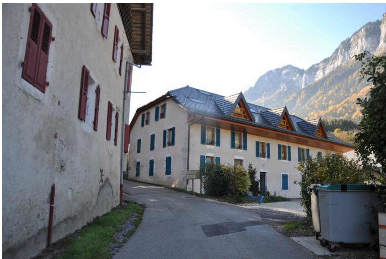
Elévation nord-est de la façade antérieure du bâtiment du moulin
