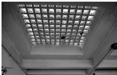
Préau joignant le bâtiment F à l'infirmerie, détail de la couverture en béton et briques de verre
