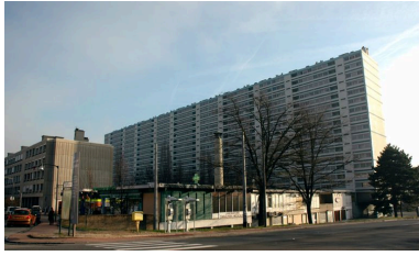
Vue d'ensemble de l'immeuble Balmont-nord, 322-329 rue du Doyen-Chapas et du centre commercial 337 avenue de Balmont Phot. Véronique Belle IVR82_20066900800NUCA
