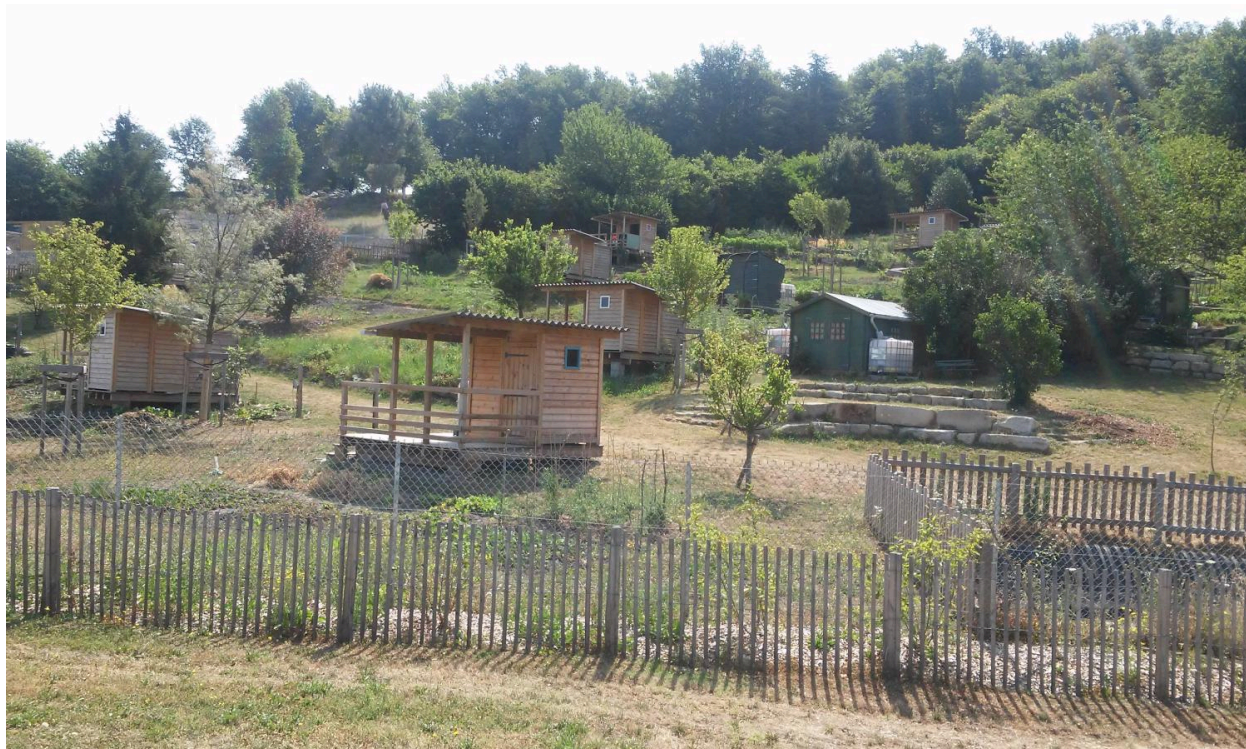
Remplacement des anciennes cabanes localisées en face du golf, jardins ouvriers Bel Air
