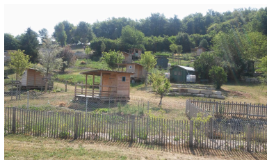
Remplacement des anciennes cabanes localisées en face du golf, jardins ouvriers Bel Air Phot. Nadine Halitim-Dubois IVR84_20204200352NUCA
