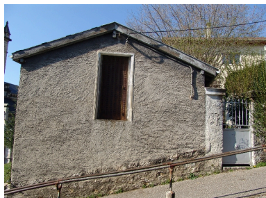
Dépendances Phot. François Fouger IVR82_20057300483NUCA
