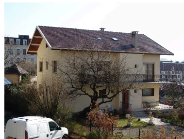
Vue d'ensemble Phot. François Fouger IVR82_20057300486NUCA
