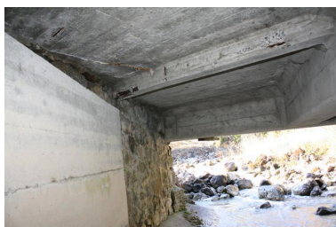
Pont de Crêt, détails pile et tablier Phot. Benoît Huraut IVR84_20207401269NUCA
