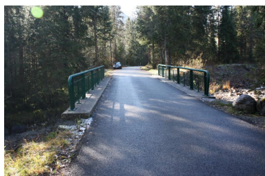
Pont de Crêt, chaussée et garde-corps Phot. Benoît Huraut IVR84_20207401268NUCA
