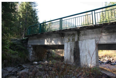
Pont de Crêt, face aval Phot. Benoît Huraut IVR84_20207401266NUCA
