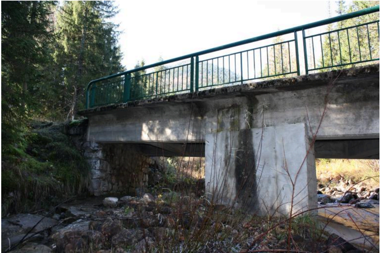
Pont de Crêt, face aval
