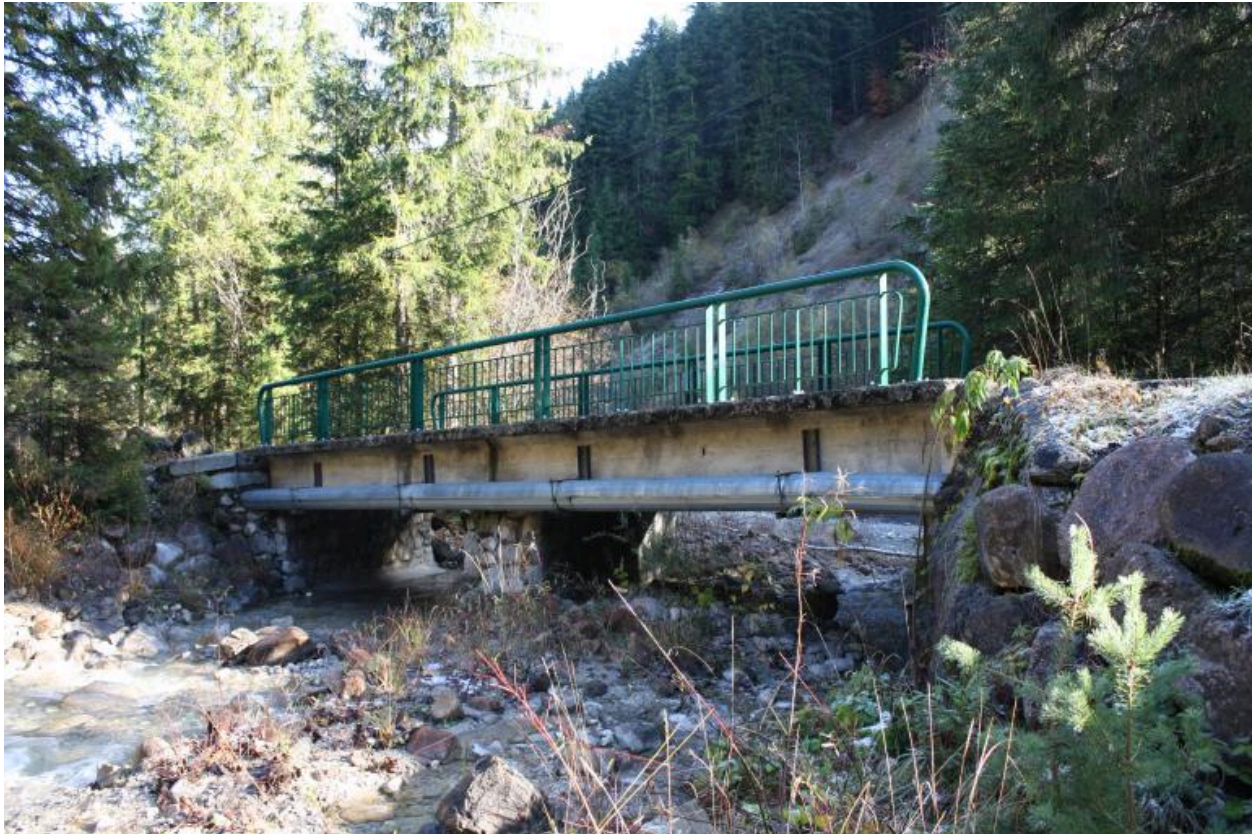
Pont de Crêt, face amont
