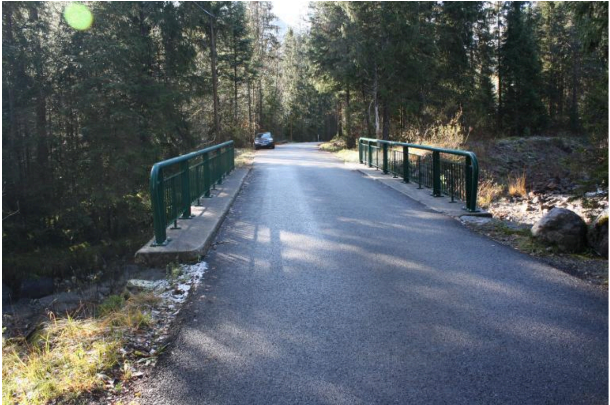
Pont de Crêt, chaussée et gardes corps
