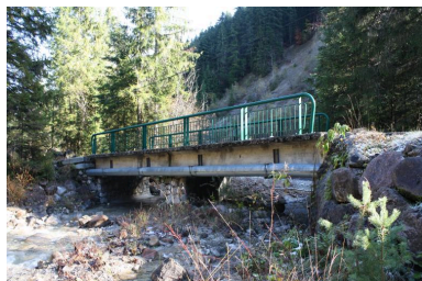
Pont de Crêt, face amont IVR84_20197401281NUCA
