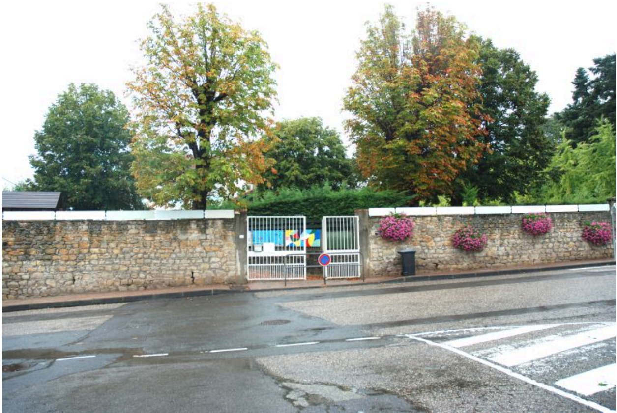
Mur de clôture en moellon depuis la place Bouvier.
