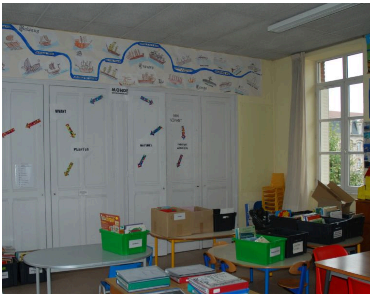
Salle de classe au 1er étage : suite de placards muraux en menuiserie.
