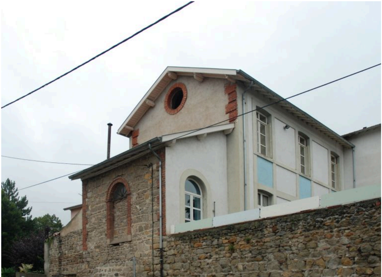
Vue partielle de trois-quarts gauche depuis la rue de l'école normale.
