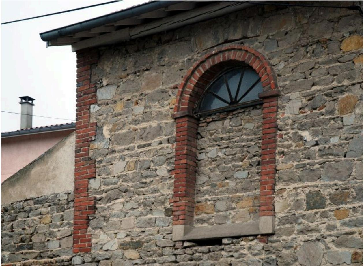
Matériaux de construction d'origine dans l'appentis latéral gauche : mur en moellon de granite, baie cintrée à encadrement de briques.
