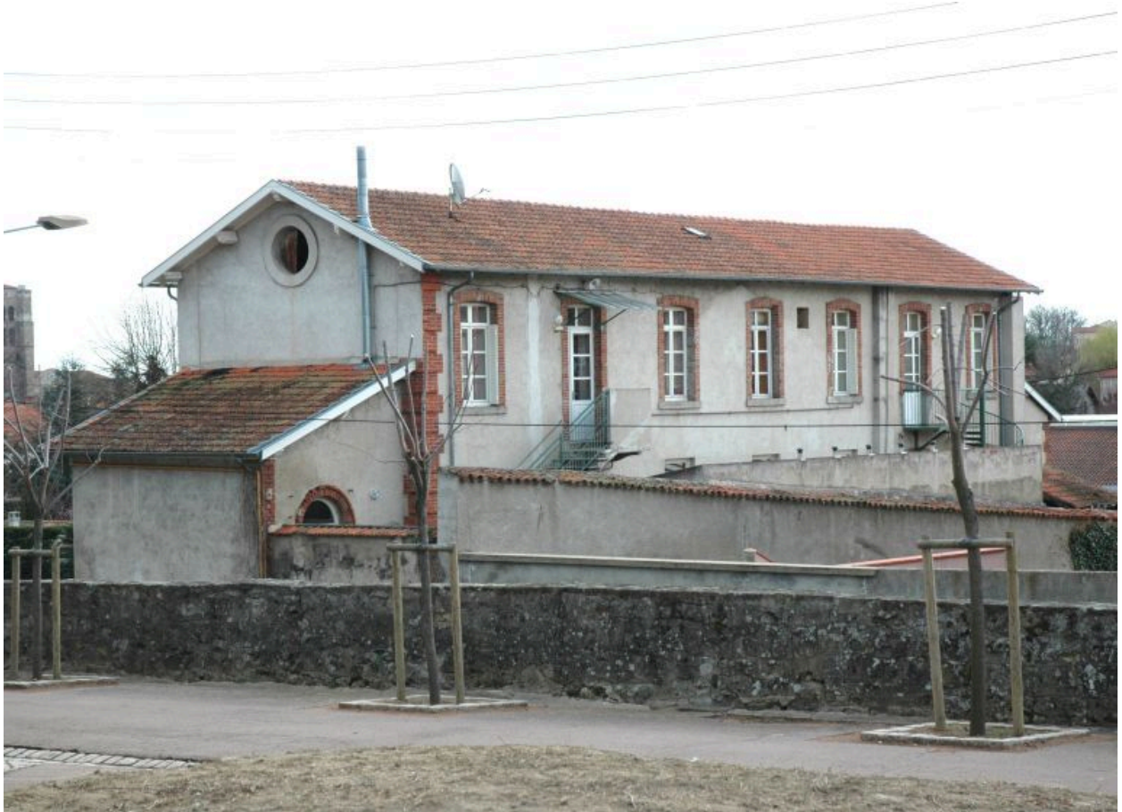
Vue partielle de l'éviation postérieure depuis l'avenue d'Allard.
