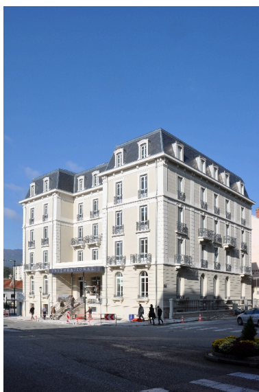
Vue générale après travaux Phot. François Fouger IVR82_20097301100NUCA
