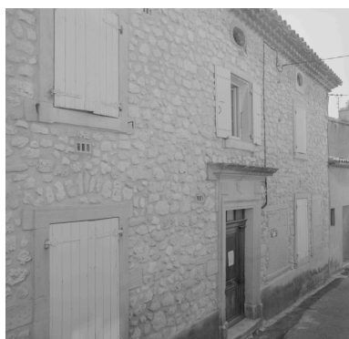
Façade sur la Grande rue, vue partielle. Phot. Alain Franchella IVR82_19992600448X
