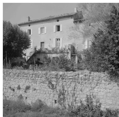
Elévation postérieure sur le jardin. Phot. Alain Franchella IVR82_19992600446X
