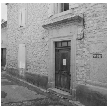
Façade, détail ; à l'extrémité, remise et dépendances. Phot. Alain Franchella IVR82_19992600447X
