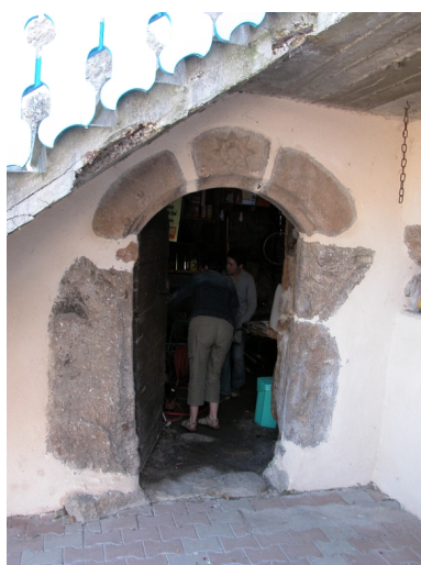
Détail de la porte de la cave occidentale. Phot. Thierry Monnet IVR82_20114201827NUCA
