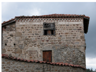
Vue de la partie supérieure du logis oriental, depuis le sud. Phot. Caroline Guibaud IVR82_20114201825NUCA
