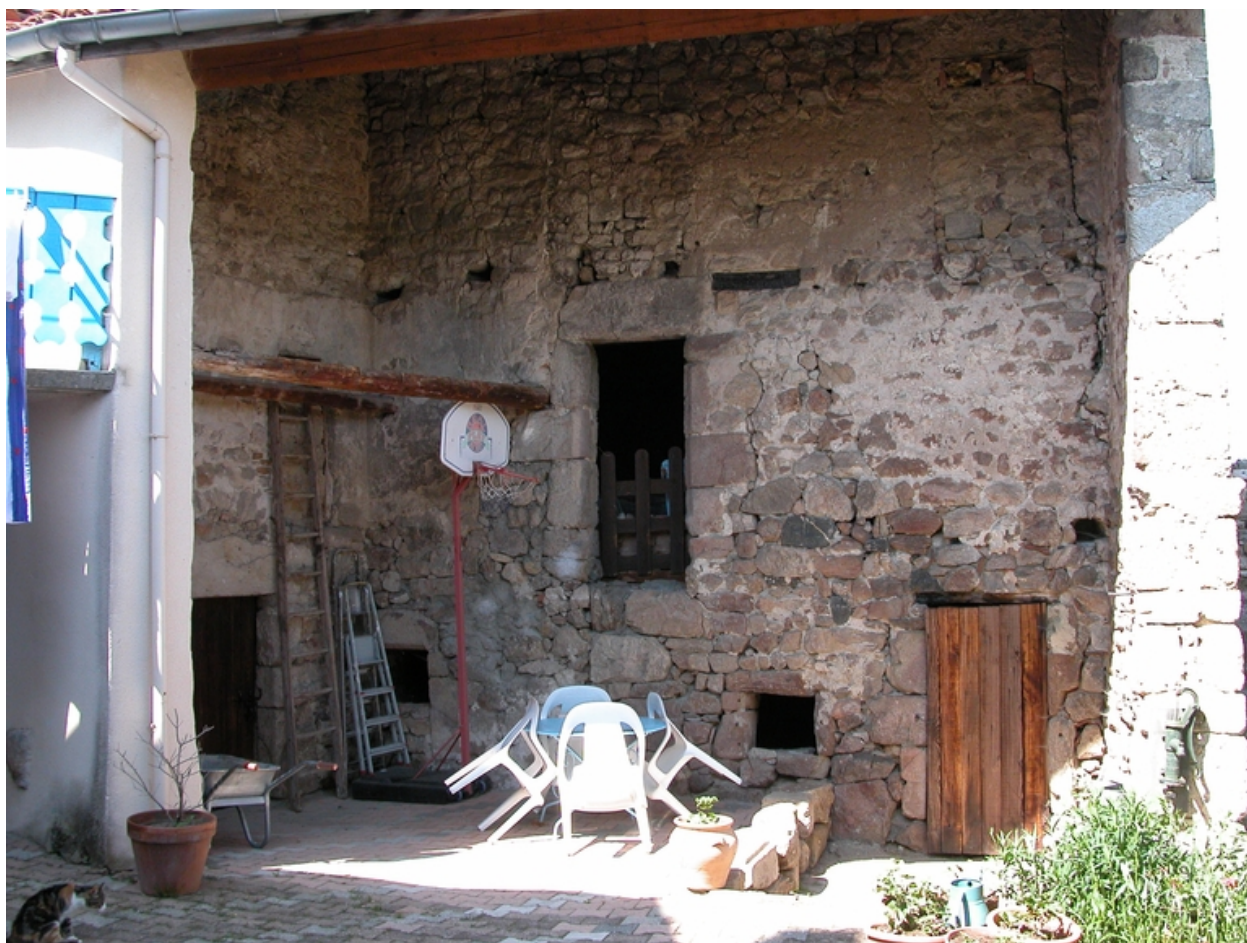
Vue de la façade sur cour du logis oriental, depuis le sud-ouest.
