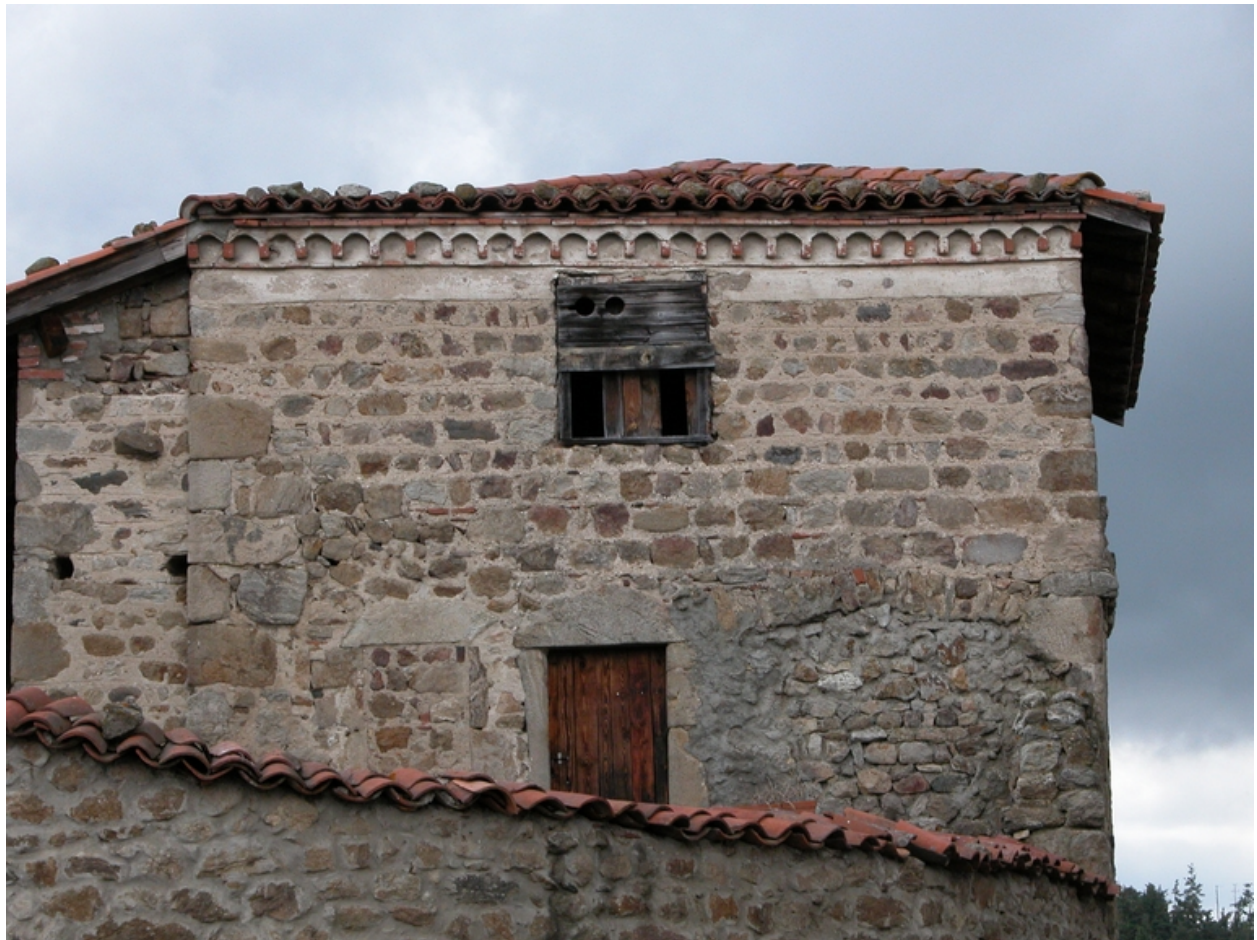
Vue de la partie supérieure du logis oriental, depuis le sud.
