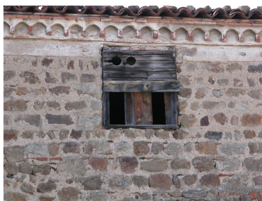
Détail de l'ouverture du pigeonnier du logis oriental. Phot. Caroline Guibaud IVR82_20114201833NUCA
