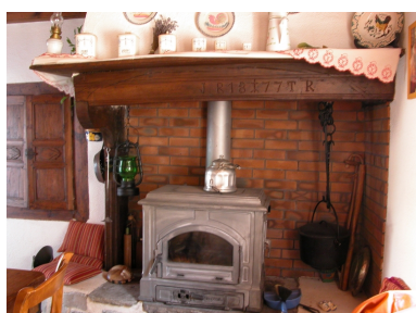
Cheminée de la cuisine du logis occidental. Phot. Thierry Monnet IVR82_20114201830NUCA
