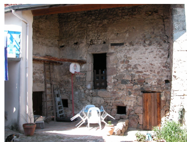
Vue de la façade sur cour du logis oriental, depuis le sud-ouest. Phot. Thierry Monnet IVR82_20114201829NUCA
