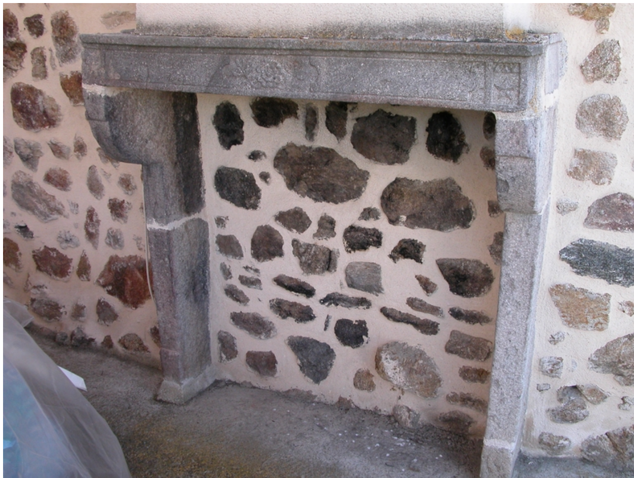
Cheminée de la salle sud-ouest du logis occidental.
