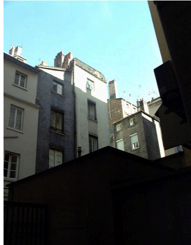
Façade postérieure (pavillon couvert d'un dôme), vue de la cour du n ° 5, av. du Maréchal-de-Saxe Phot. Bernard Ducouret IVR82_20016900829NUCA
