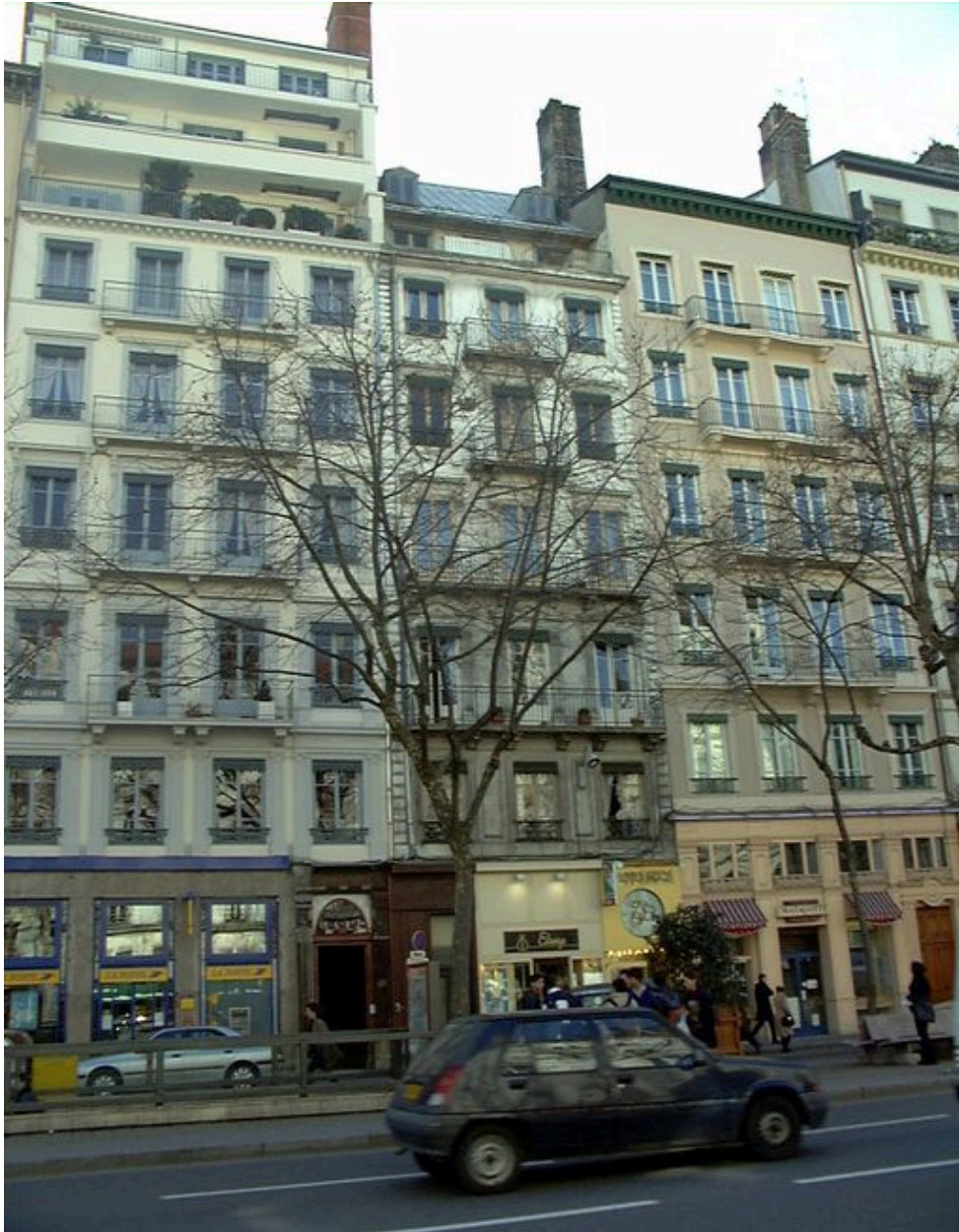
Façade sur rue, vue générale
