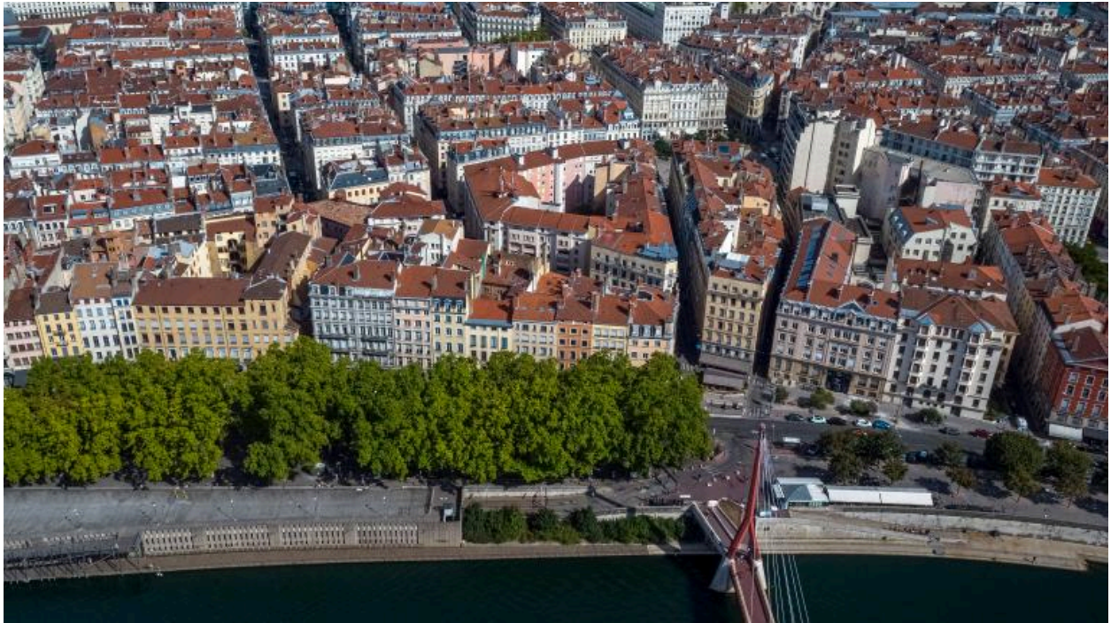
Vue aérienne depuis l'ouest
