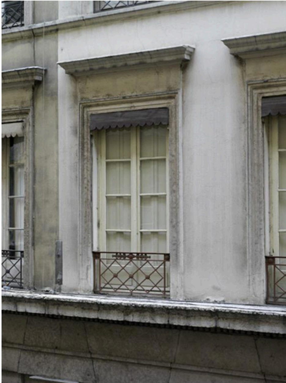
Fenêtres des 6 et 8 de la rue depuis l'immeuble situé n°5
