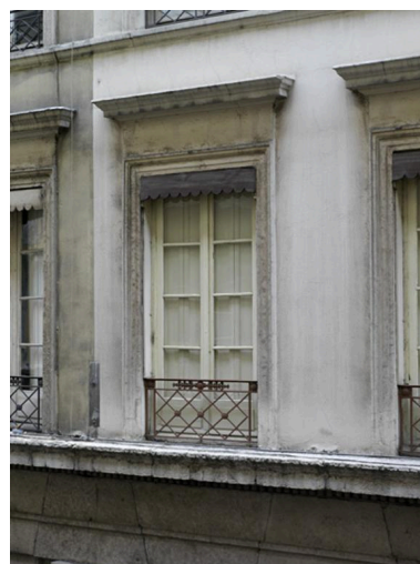
Fenêtres des 6 et 8 de la rue depuis l'immeuble situé n°5 Phot. Eric Dessert IVR82_20086902482NUCA
