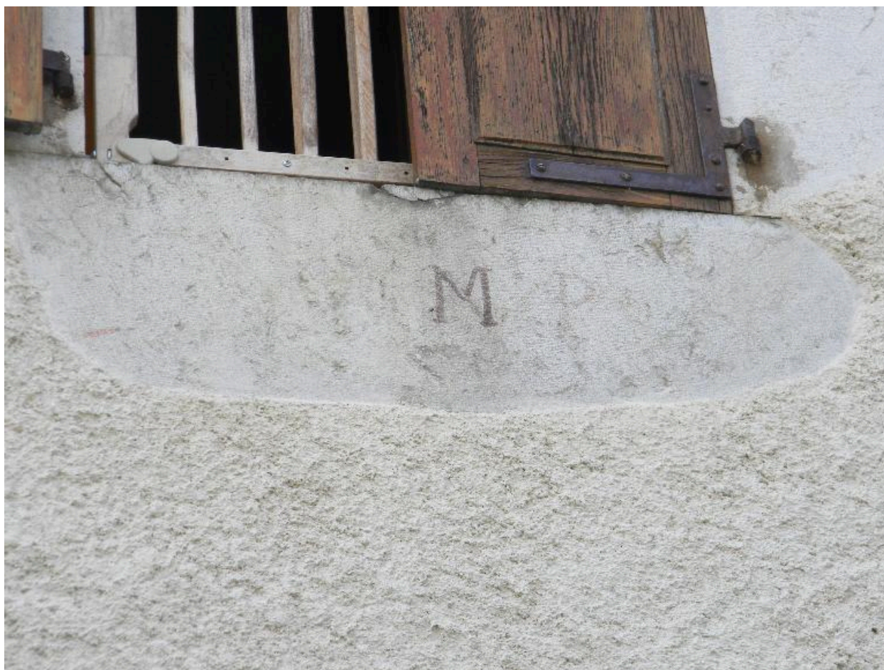
Détail d'une assise de fenêtre portant l'inscription MP sur le pignon est d'une ancienne ferme (2008 B7 1163).
