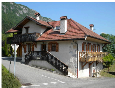
Vue de l'ancienne fruitière (2008 B2 224). Phot. Jérôme Daviet IVR82_20147400258NUCA
