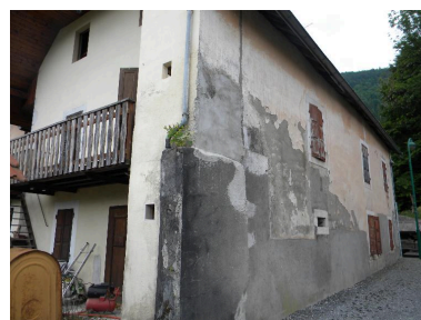
Vue du pignon est d'une ancienne ferme (2008 B3 562 bâtiment 1) Phot. Jérôme Daviet IVR82_20147400368NUCA
