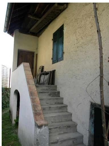
Vue d'un escalier en pierre sur la façade ouest d'une ancienne maison (2008 B2 389, 390) Phot. Jérôme Daviet IVR82_20147400345NUCA
