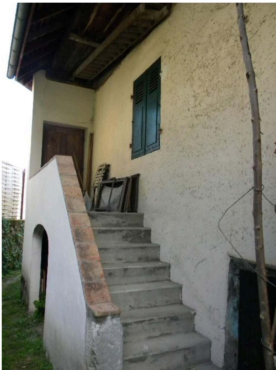
Vue d'un escalier en pierre sur la façade ouest d'une ancienne maison (2008 B2 389, 390)
