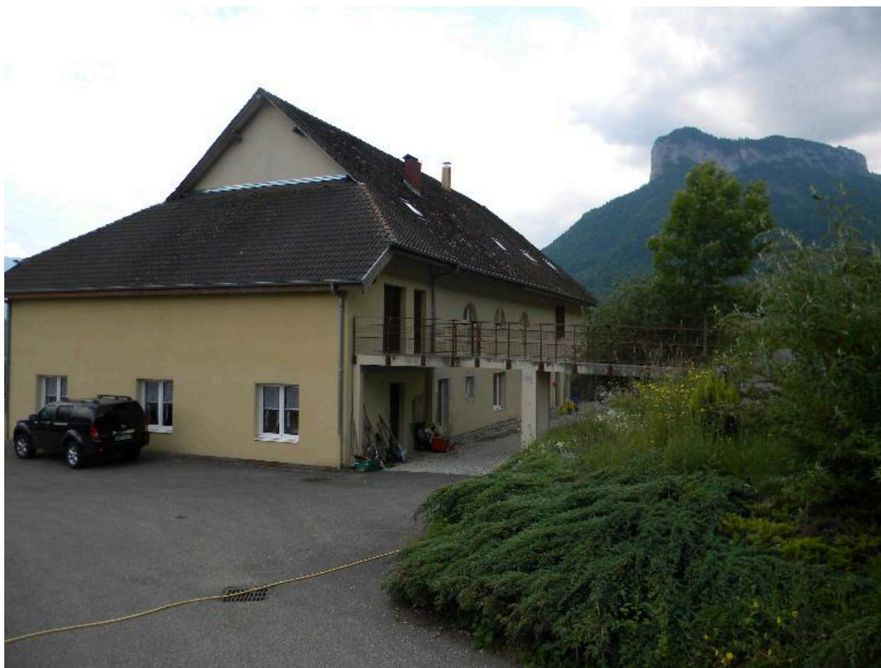
Vue de trois-quarts de la ferme de Pontgibaud (2008 B7 2026).
