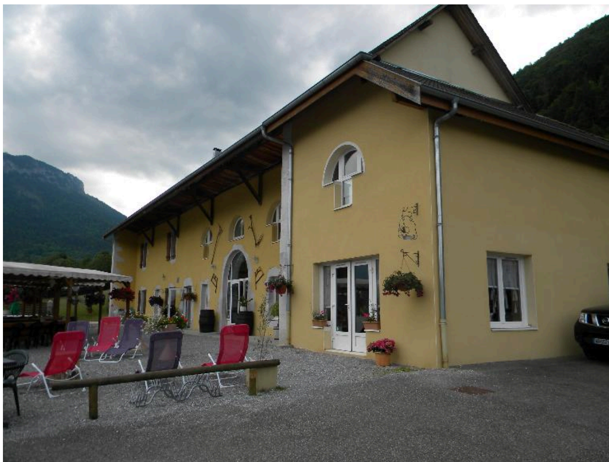
Vue de la façade principale de la ferme de Pontgibaud (2008 B7 2026)
