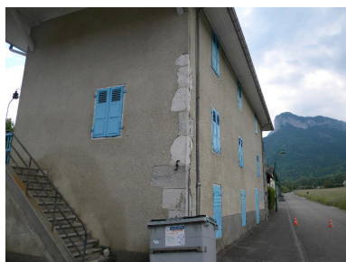
Vue d'ensemble d'une ancienne maison (2008 B3 1200). Phot. Jérôme Daviet IVR82_20147400378NUCA
