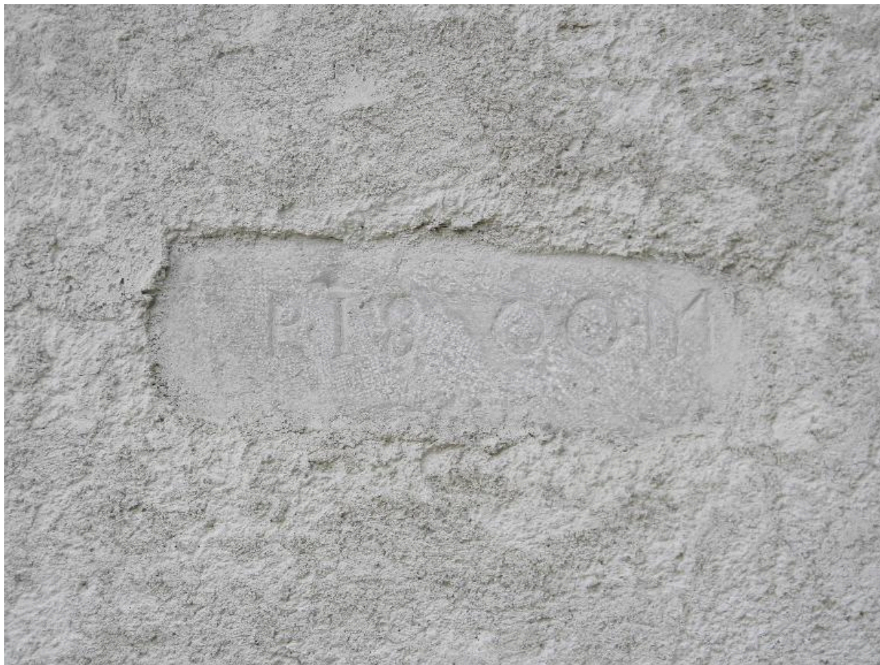
Vue d'une pierre en façade nord d'une ancienne ferme portant l'inscription P 1800 M (2008 B7 1163).
