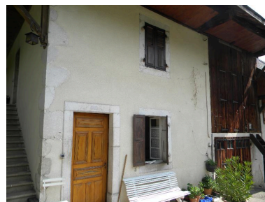
Vue de la façade du logis ouest de deux fermes mitoyennes (2008 B2 2014, 2273). Phot. Jérôme Daviet IVR82_20147400339NUCA
