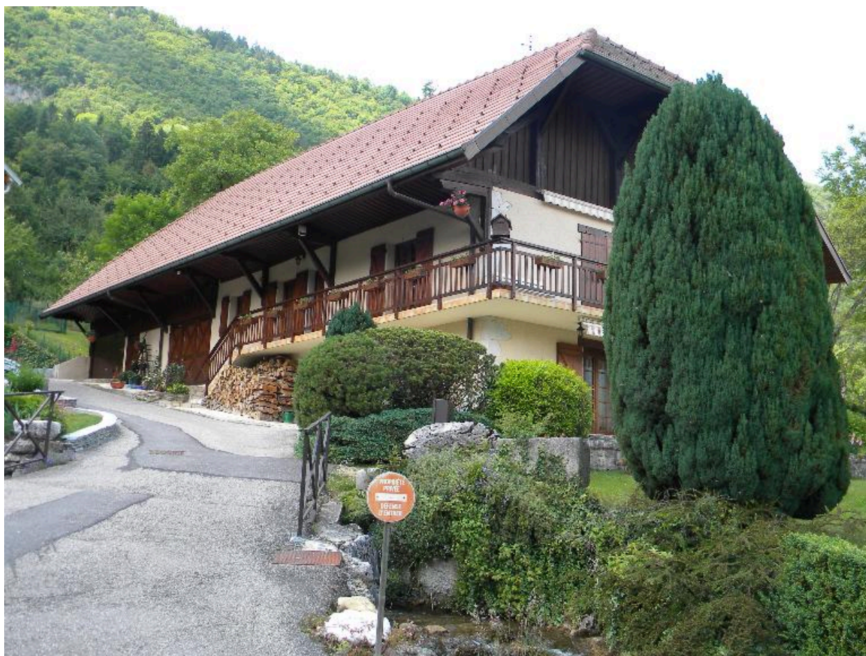
Vue d'une ancienne ferme modifiée (2008 B2 1840).
