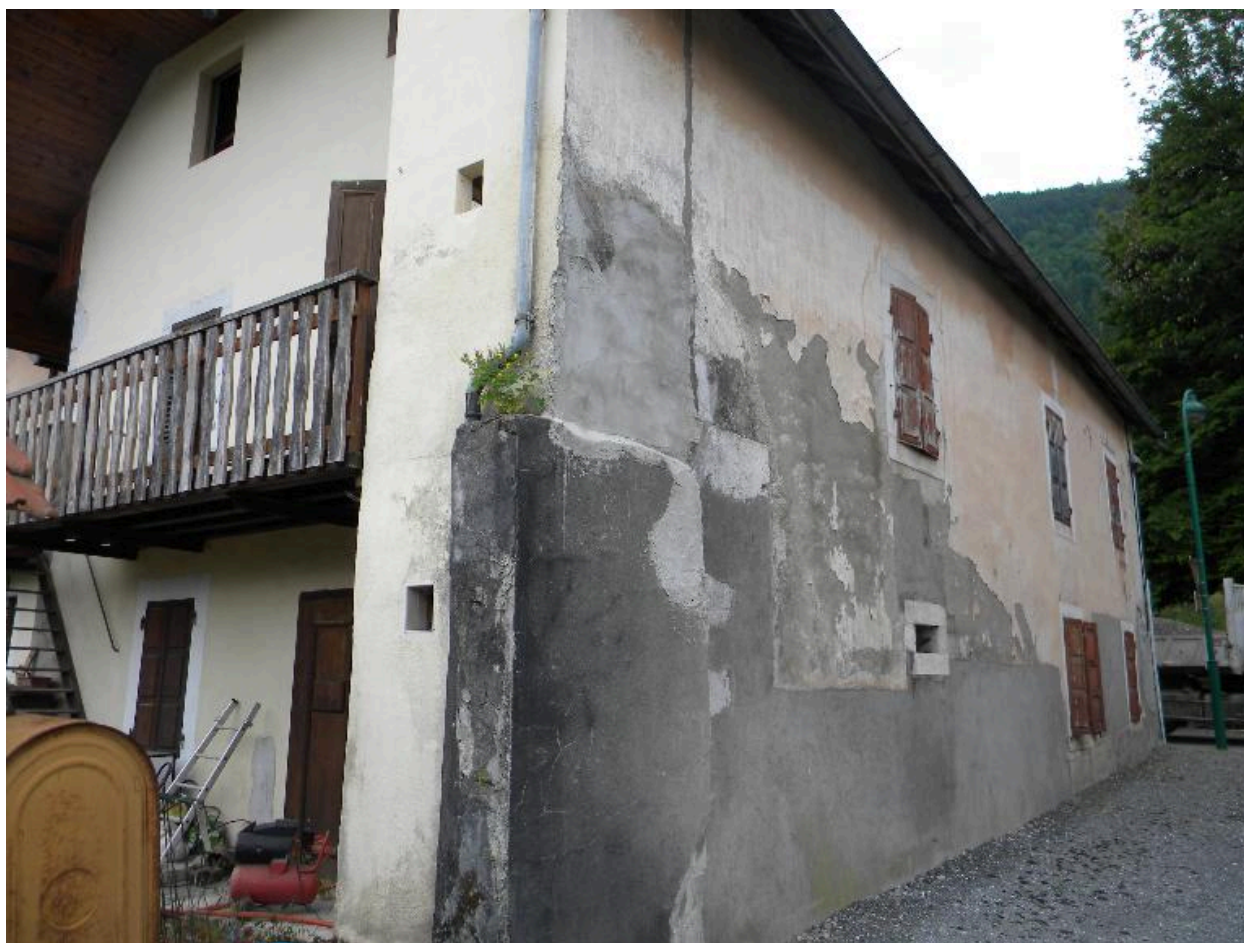
Vue du pignon est d'une ancienne ferme (2008 B3 562 bâtiment 1)
