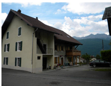
Vue de l'alignement de bâtiments mitoyens (2008 B3 555, 1487). Phot. Jérôme Daviet IVR82_20147400382NUCA
