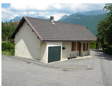
Vue d'une ancienne maison (2008 B2 373).
