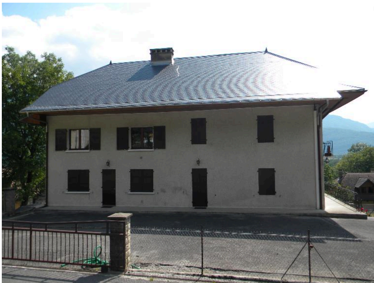
Vue d'une ancienne ferme modifiée (2008 B2 1957, 1958).
