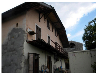
Vue de la façade est d'une ancienne auberge (2008 B3 562 bâtiment 3). Phot. Jérôme Daviet IVR82_20147400375NUCA
