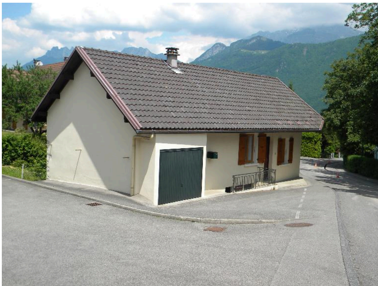
Vue d'une ancienne maison (2008 B2 373).
