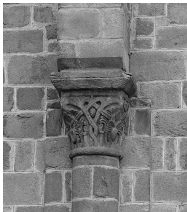
Détail du chapiteau soutenant l'arcature décorative sur le bras sud du transept. Phot. Eric Dessert IVR82_20064200091X
