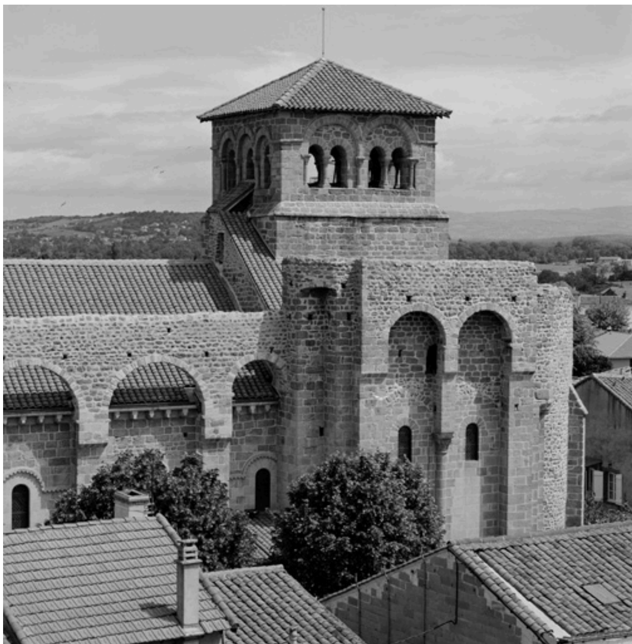
Vue de la moitié est de la façade sud, depuis une grue placée au sud-ouest.
