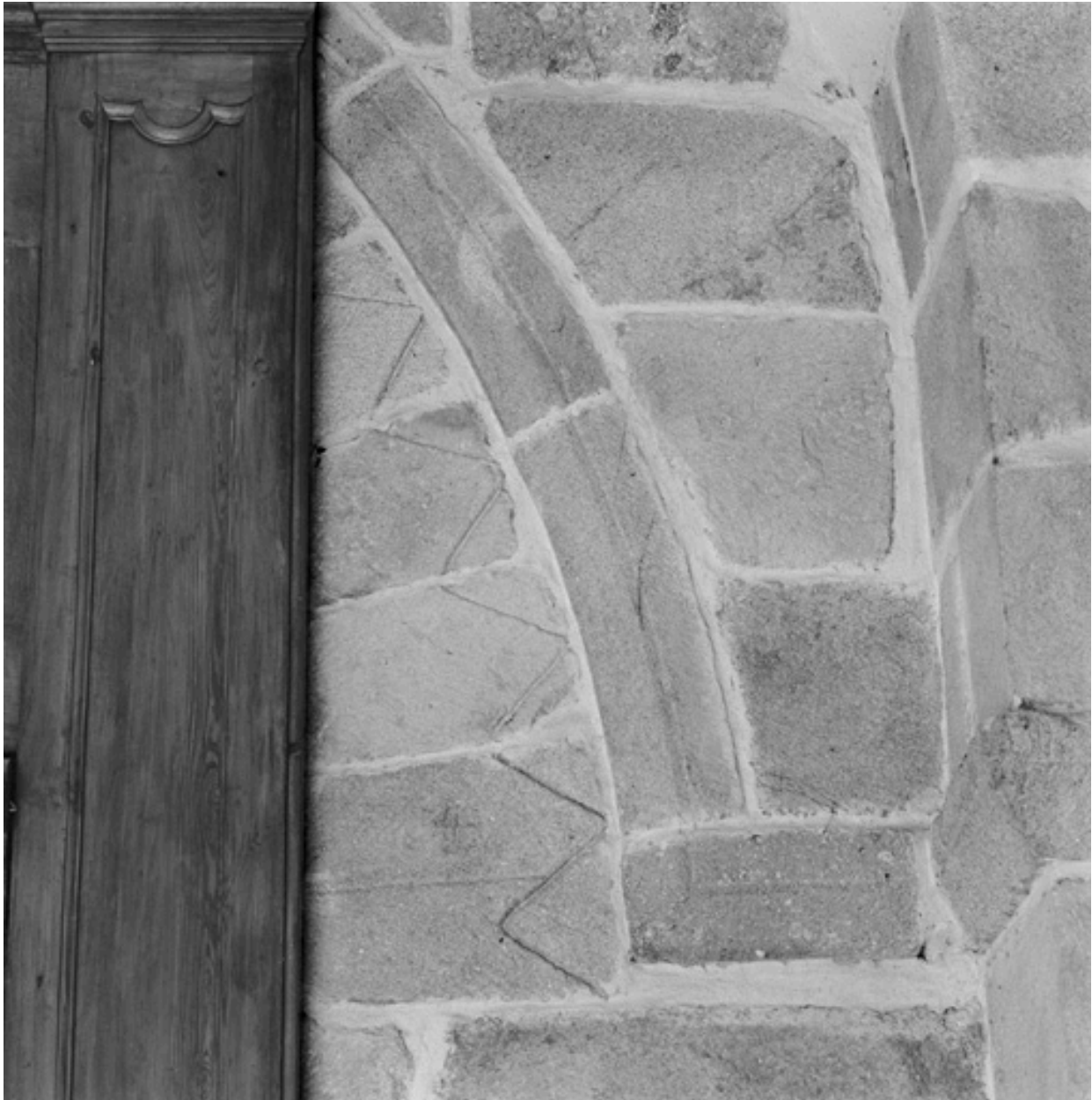
Détail de l'extrémité droite de l'archivolte du portail du narthex vers la nef.
