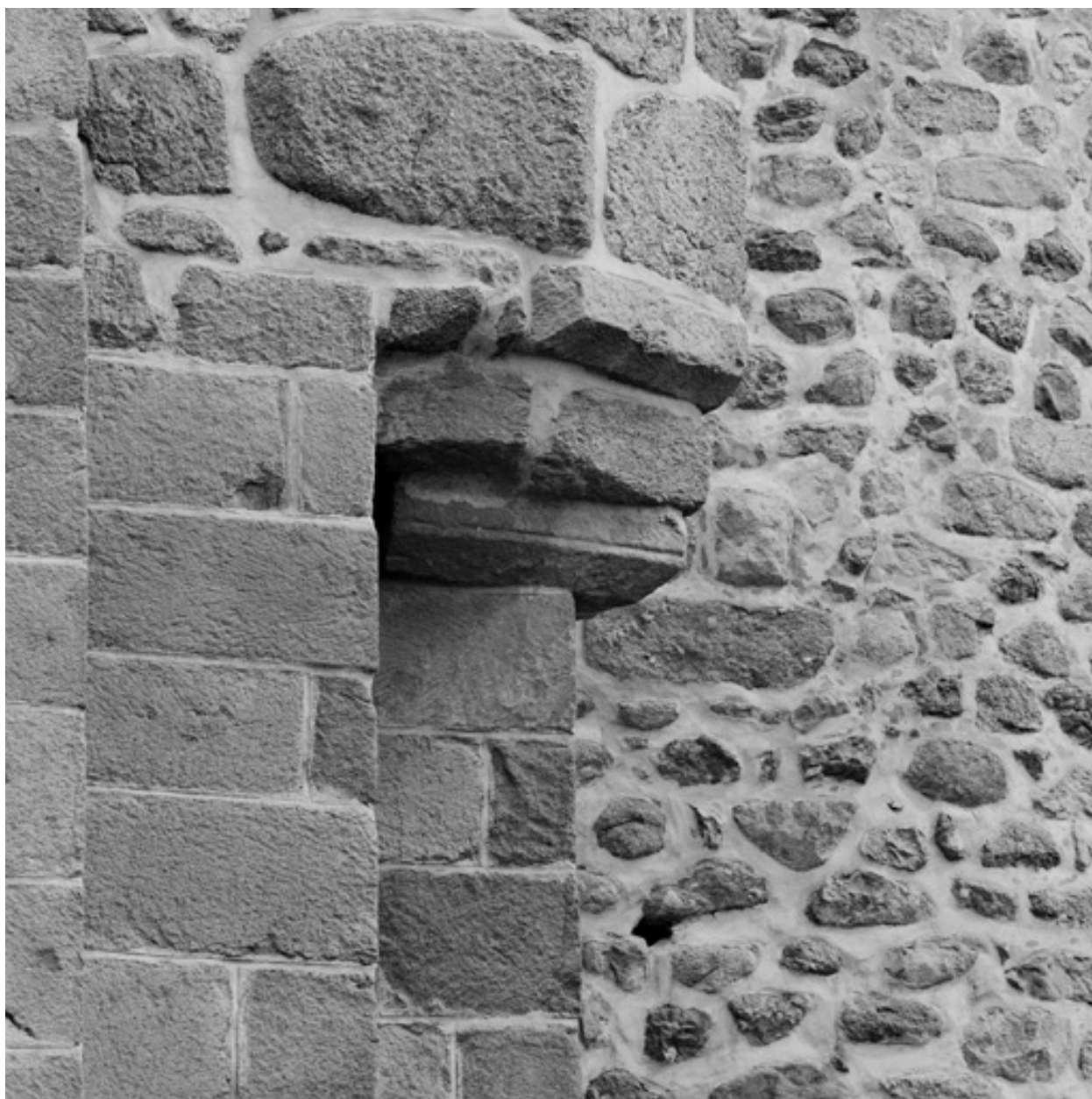
Détail du pilier soutenant l'échauguette (détruite) dans l'angle oriental du bras sud du transept.
