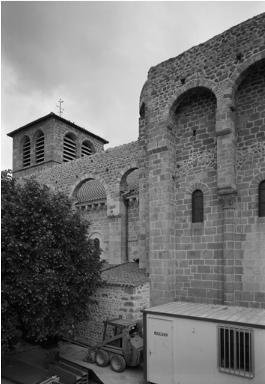
Vue de la façade sud depuis le sud-est (du sol).
