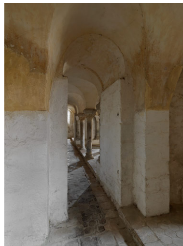
Vue du vestibule transversal de la crypte, depuis le sud.
