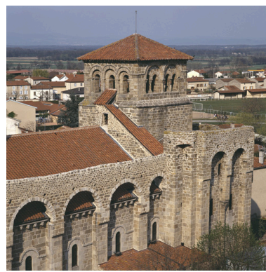
Vue de la moitié est de la façade sud, depuis une grue placée au sud-ouest. Phot. Eric Dessert IVR82_20064200050XA
