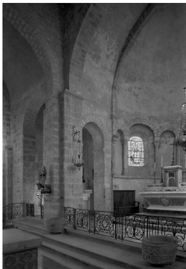
Vue intérieure du chœur et de l'abside, de trois-quarts depuis le sud-ouest. Phot. Eric Dessert IVR82_20064200151P
