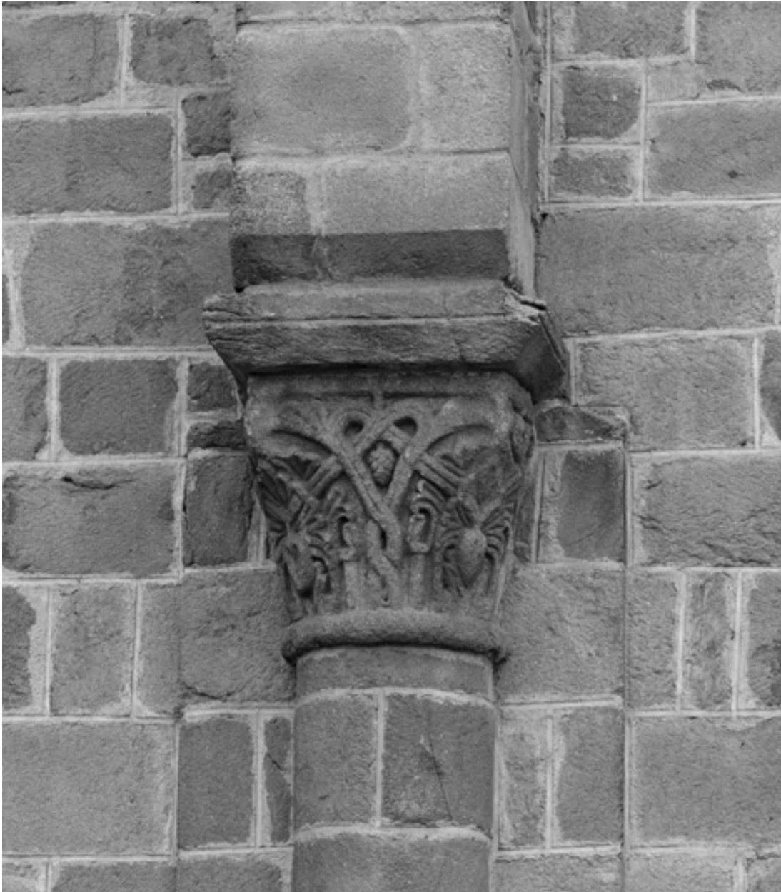
Détail du chapiteau soutenant l'arcature décorative sur le bras sud du transept.
