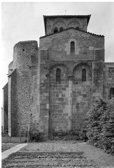
Vue de la façade nord du transept nord. Phot. Eric Dessert IVR82_20064200148P
