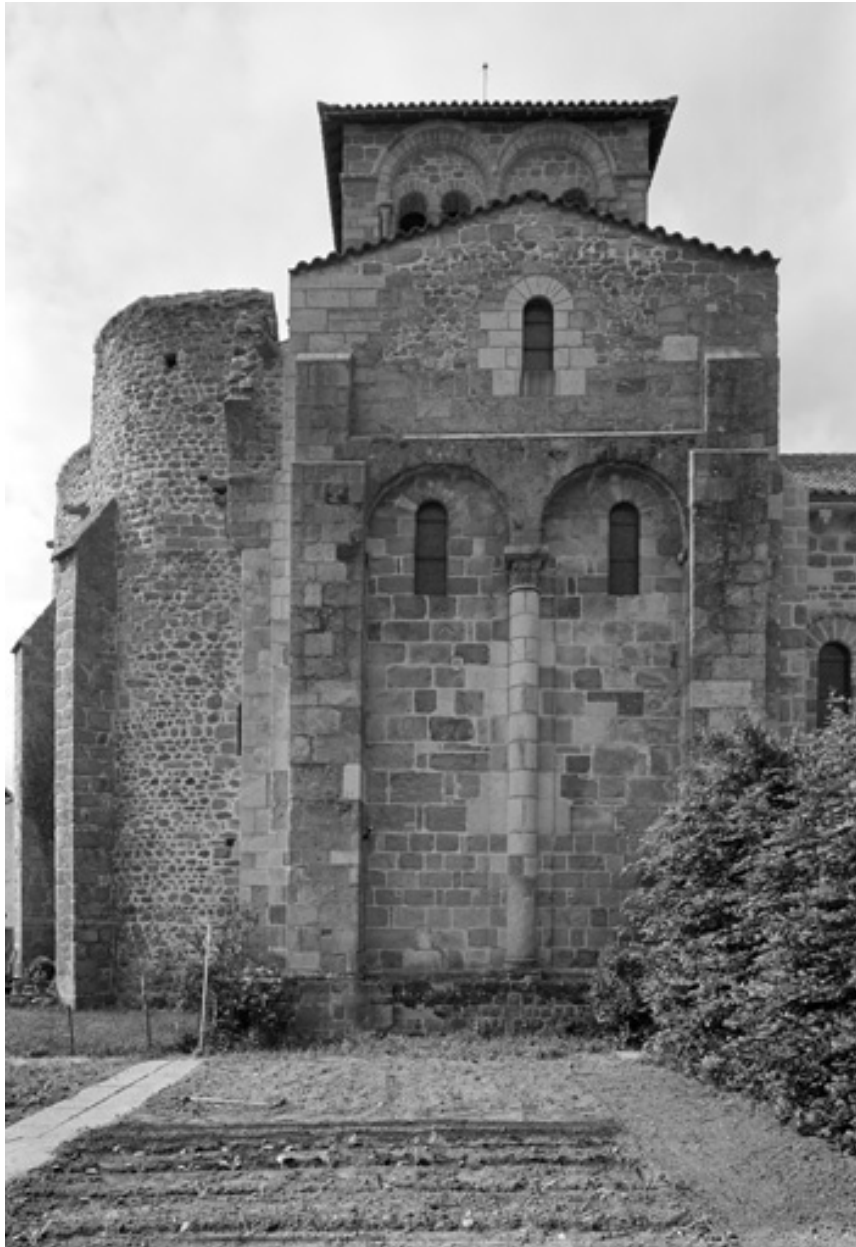
Vue de la façade nord du transept nord.
