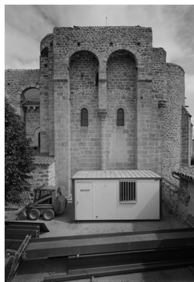
Vue de la façade sud du bras sud du transept, depuis le sud. Phot. Eric Dessert IVR82_20064200134P
