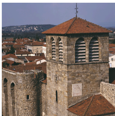
Vue des niveaux supérieurs du clocher porche et de l'aile ouest des bâtiments conventuels, depuis une grue placée au sud-ouest. Phot. Eric Dessert IVR82_20064200057XA
