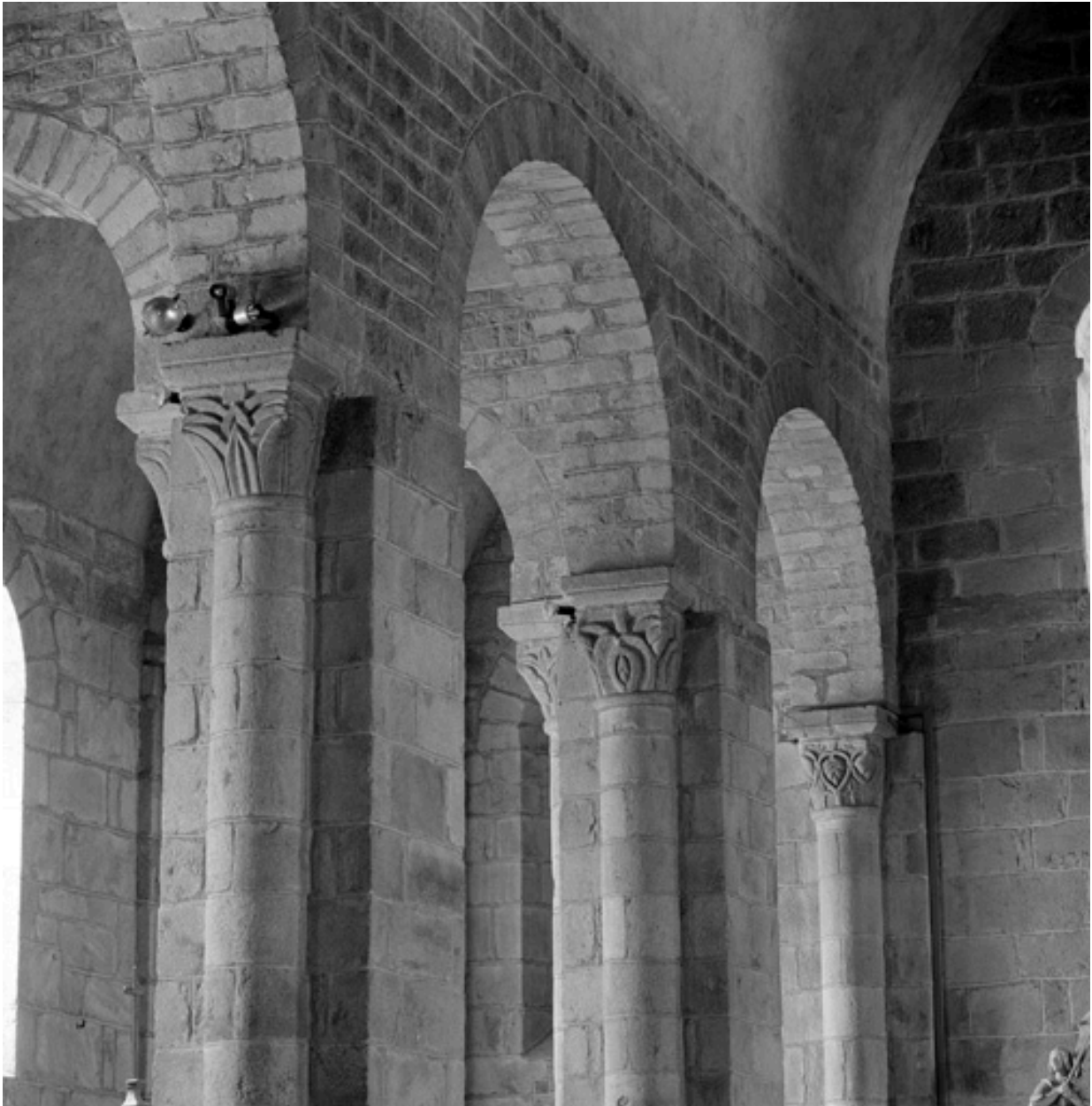
Détail des grandes arcades de la nef, du côté sud, depuis le nord-est.
