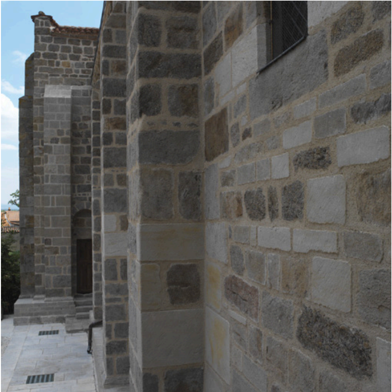
Vue de la façade nord dans l'axe de la porte de communication de l'église avec le cloître.
