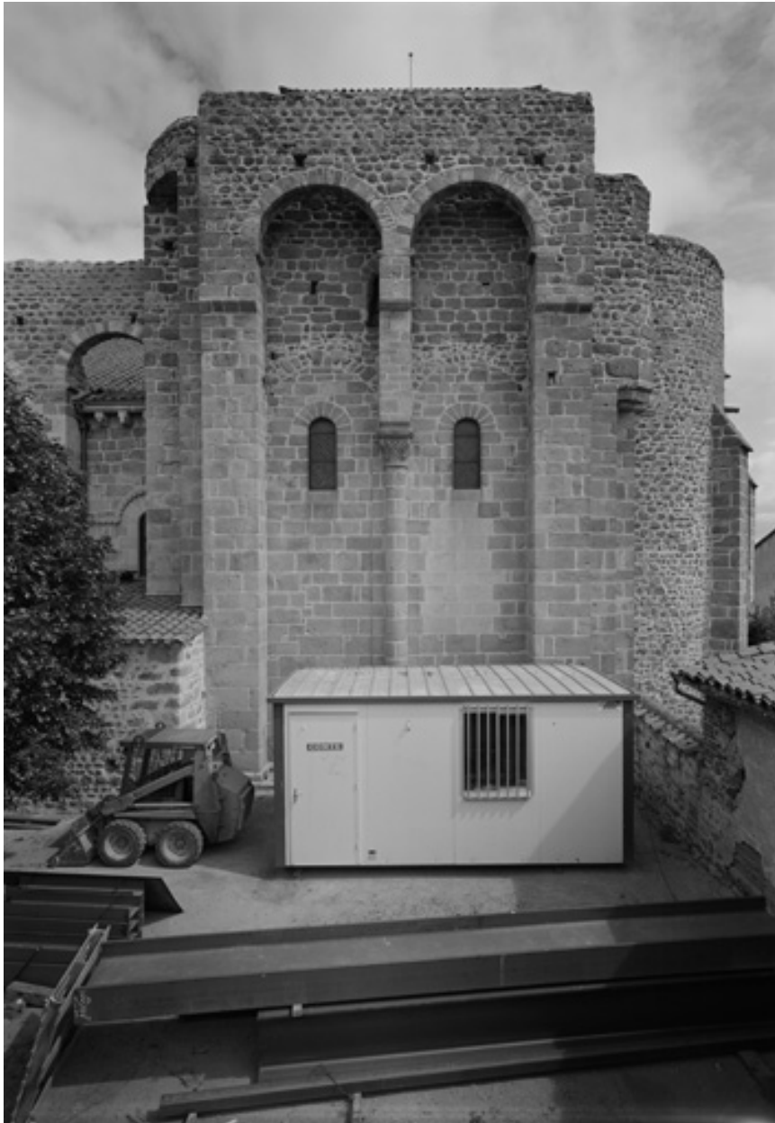
Vue de la façade sud du bras sud du transept, depuis le sud.
