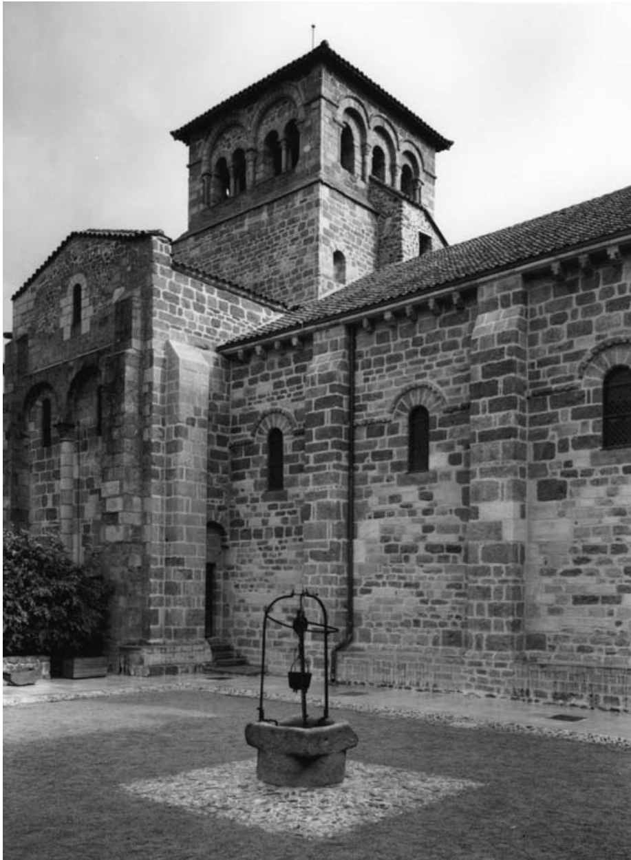
Vue d'ensemble du transept et de la façade nord de l'église, depuis le nord-ouest.
