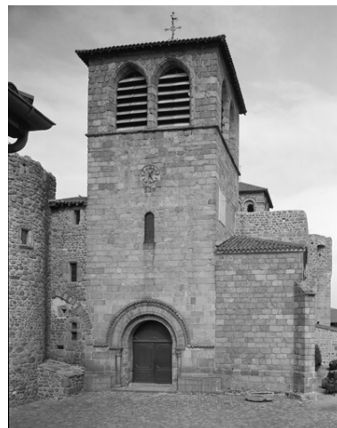
Vue d'ensemble de la façade occidentale. Phot. Eric Dessert IVR82_20064200135P
