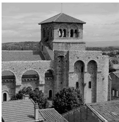
Vue de la moitié est de la façade sud, depuis une grue placée au sud-ouest. Phot. Eric Dessert IVR82_20064200048X
