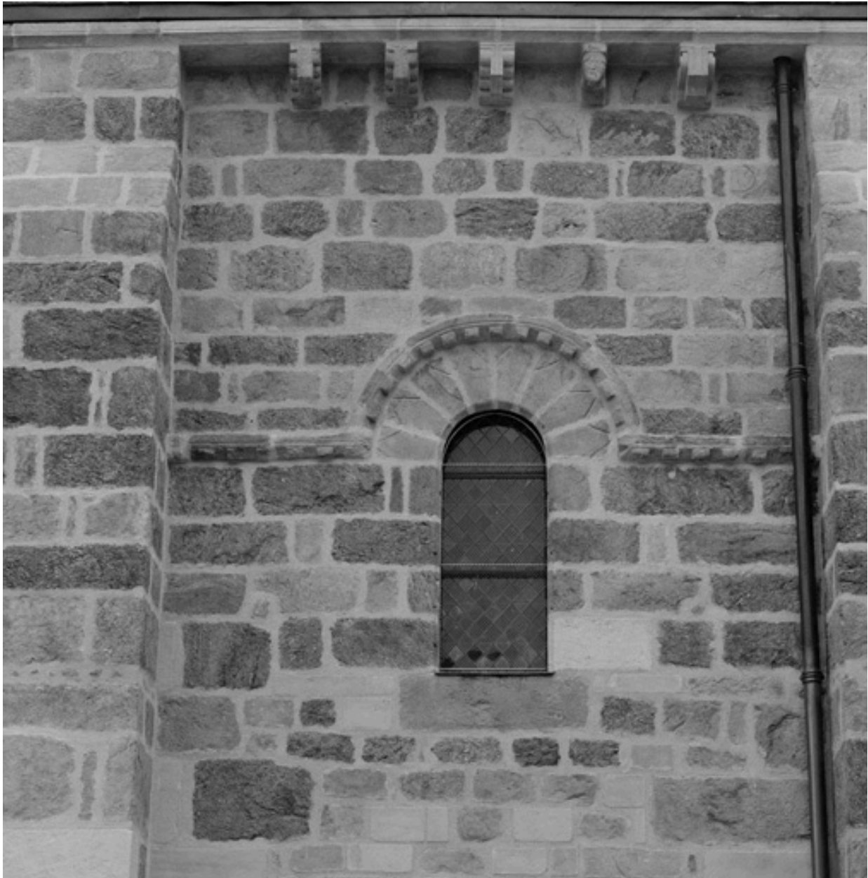
Détail de la façade nord : fenêtre de la 3e travée.
