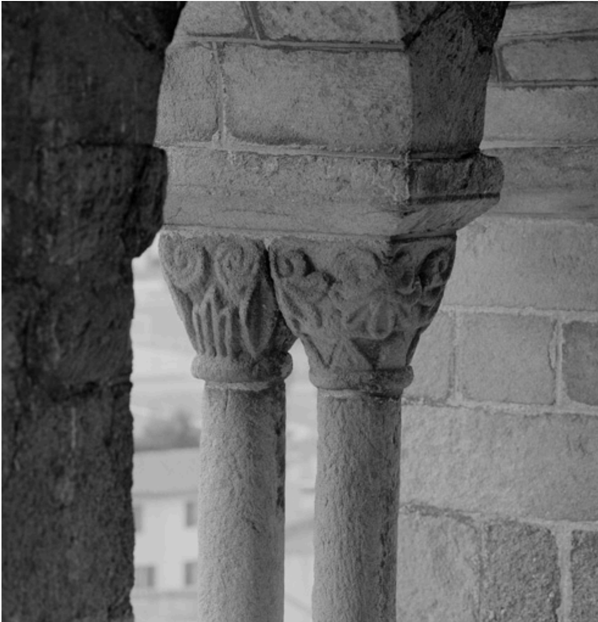
Chapiteaux de la tour clocher (face sud, baie ouest, vu de l'intérieur du clocher).
