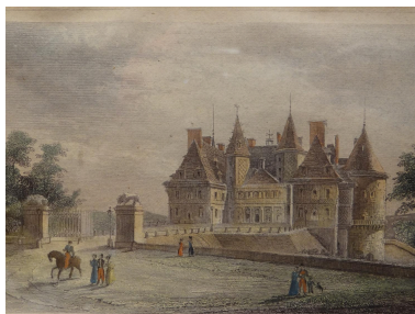
Détail Phot. Lionel Sauzade IVR84_20216300500NUCA
