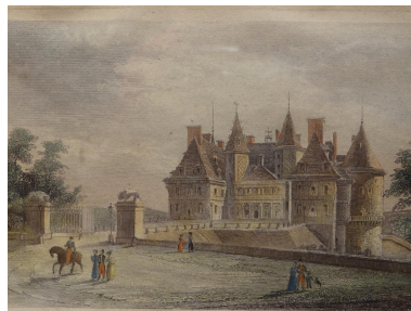
Détail Phot. Lionel Sauzade IVR84_20216300500NUCA
